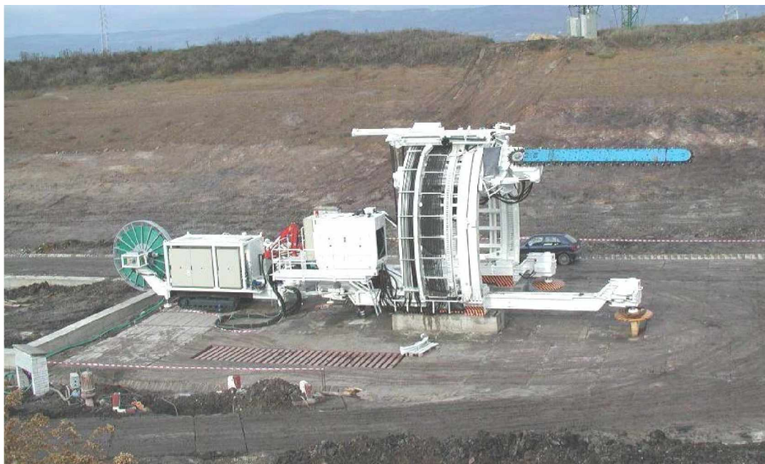
Obrázek 4: Tunelovací stroj s řetězovou pilou použitý na tunelu Březno (zdroj autora)
