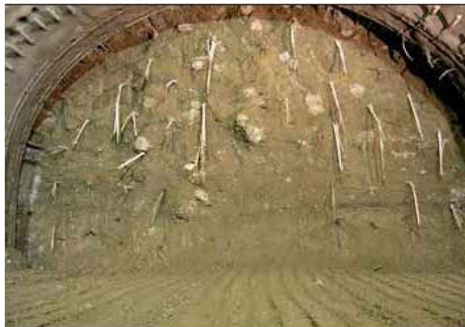
Obrázek 5: Zajištění stability čelby dle metody ADECO-RS
