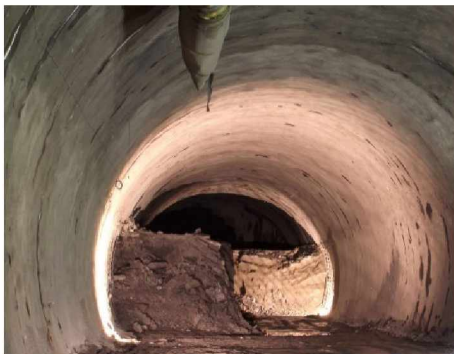
Obrázek 2: Horizontální členění výrubu, TKB Blanka (zdroj autora)
