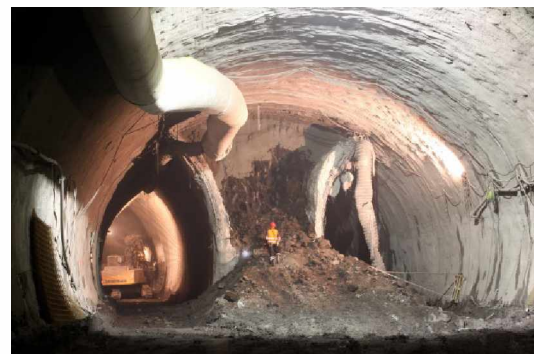
Obrázek 3: Vertikální členění výrubu, TKB Blanka (zdroj autora)
