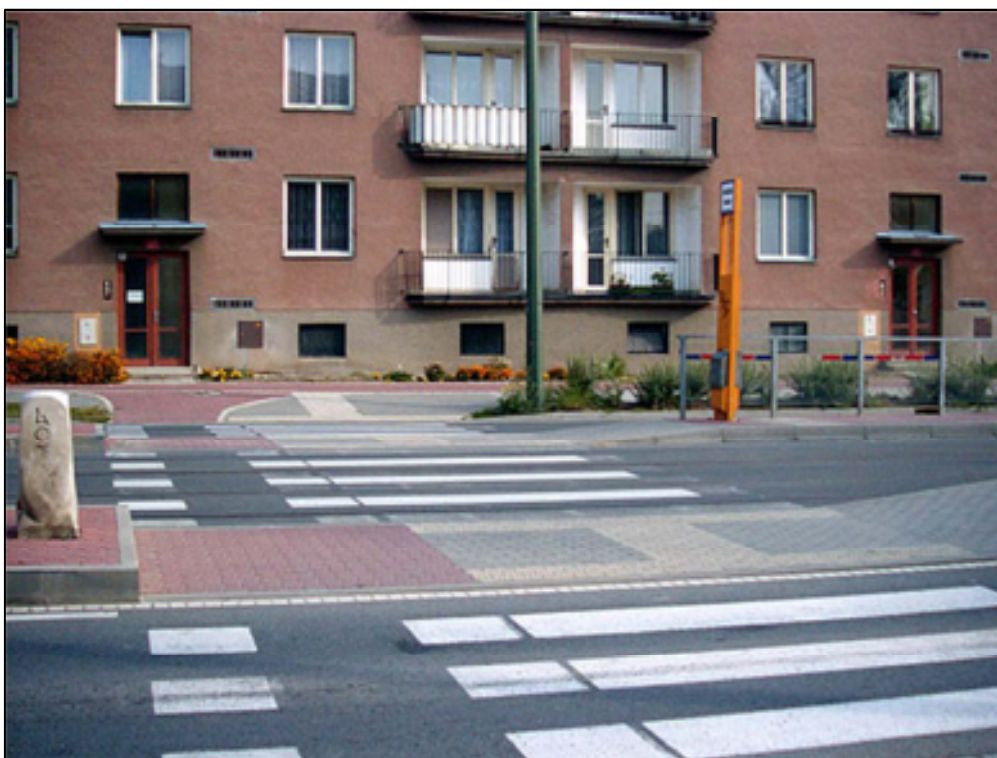
Obrázek 1 Bezbariérový přechod Zdroj: [20]
