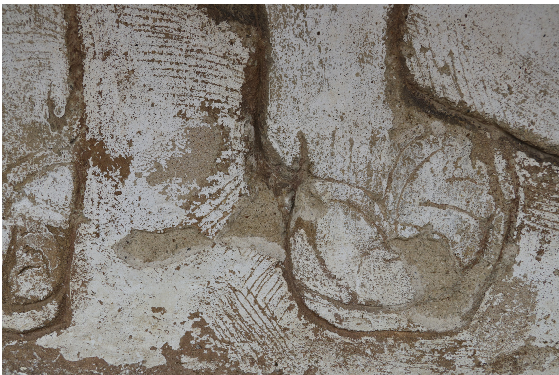
Obr. 24: Poškození v oblasti nohou figury v místě odstříku vody od římsy v podobě ztráty druhotného intonaca pocházejícího z předchozího restaurátorského zásahu pod vedením O. Zoubka. Stav před restaurováním.
