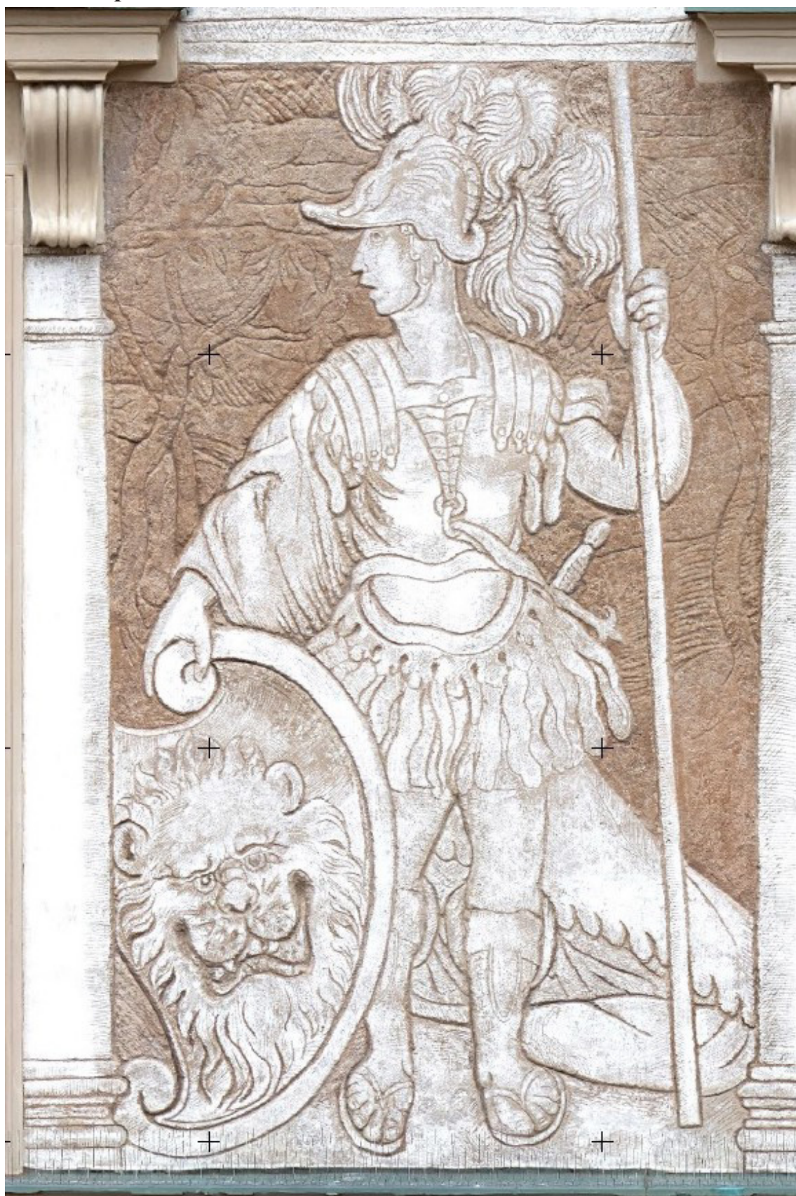
Obr. 37: Celek úseku vyobrazující Hrdinu v antikizující zbroji . Stav po restaurování. Fotogrammetrická dokumentace (ortofotoplán), stav k 26.11.2024. Zpracoval: Ing. Pavel Hlavenka, Ing. Jiří Vidman v prosinci 2024.
