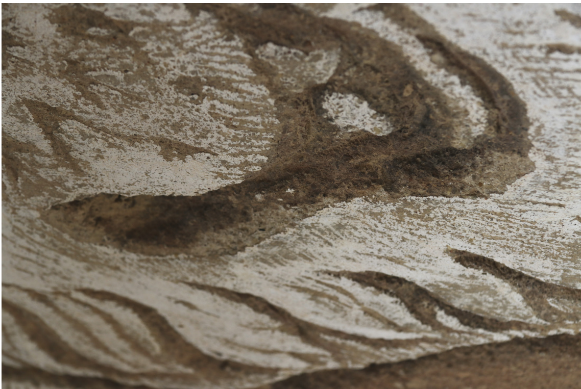
Obr. 23: Detail dokumentující hluboké rytí do omítky a sulfatizaci povrchu v hloubkách odryté plochy. Stav před restaurováním.
