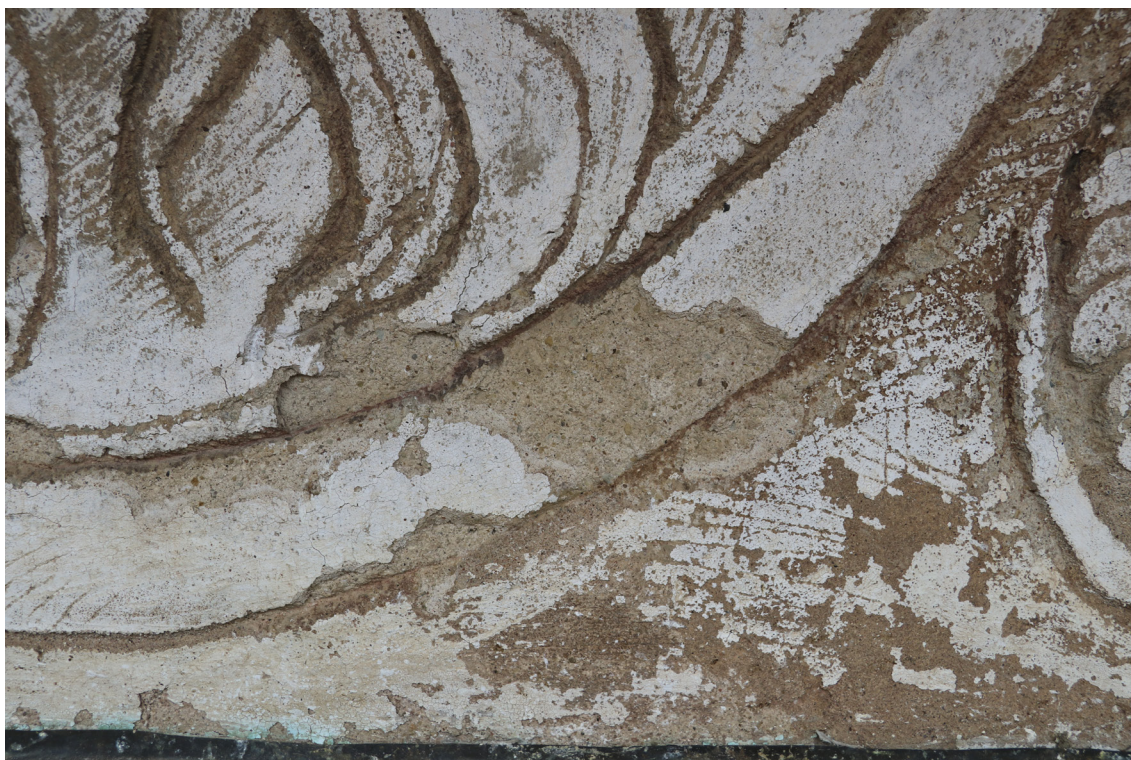
Obr. 25: Ztráta intonaca ve spodní části výjevu nad římsou. Jedná se o degradovanou rekonstrukci z let 1984–1987. Stav před restaurováním.
