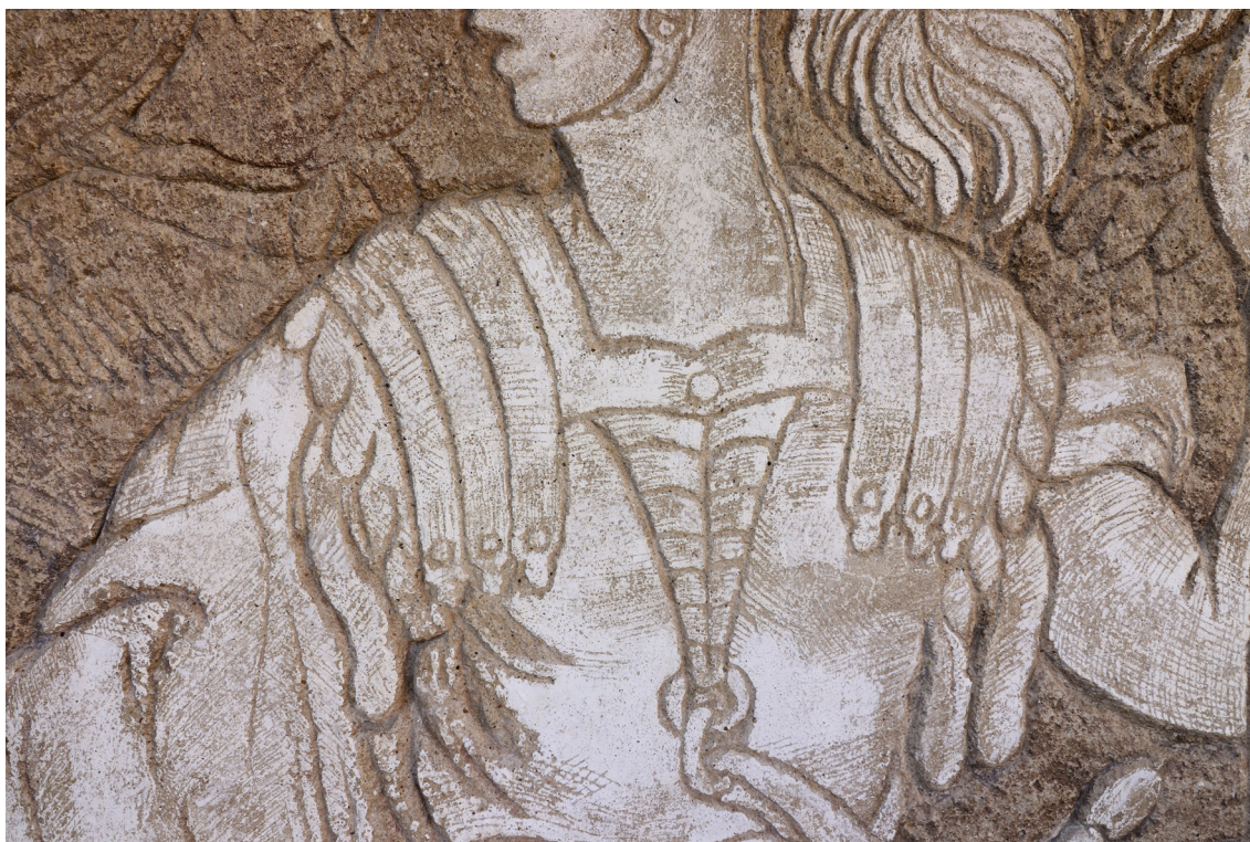
Obr. 39: Horní partie restaurovaného úseku. Stav po retuši.
