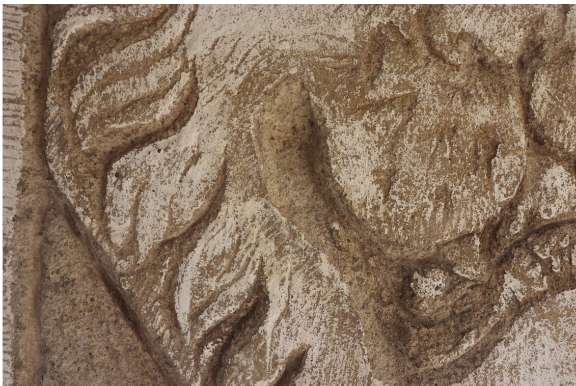
Obr. 33: Odstranění síranových krust 20 % (hm.) roztokem uhličitanu amonného z hloubek ryté kresby. Stav po očištění.
