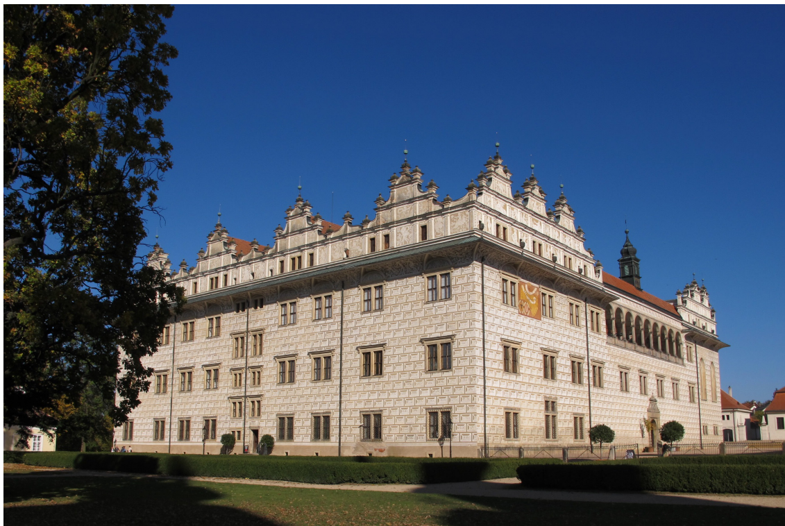
Obr. 01: Pohled na jihozápadní a jihovýchodní fasádu zámku Litomyšl. Foto dostupné z: https://www.zamek-litomysl.cz/cs/fotogalerie
