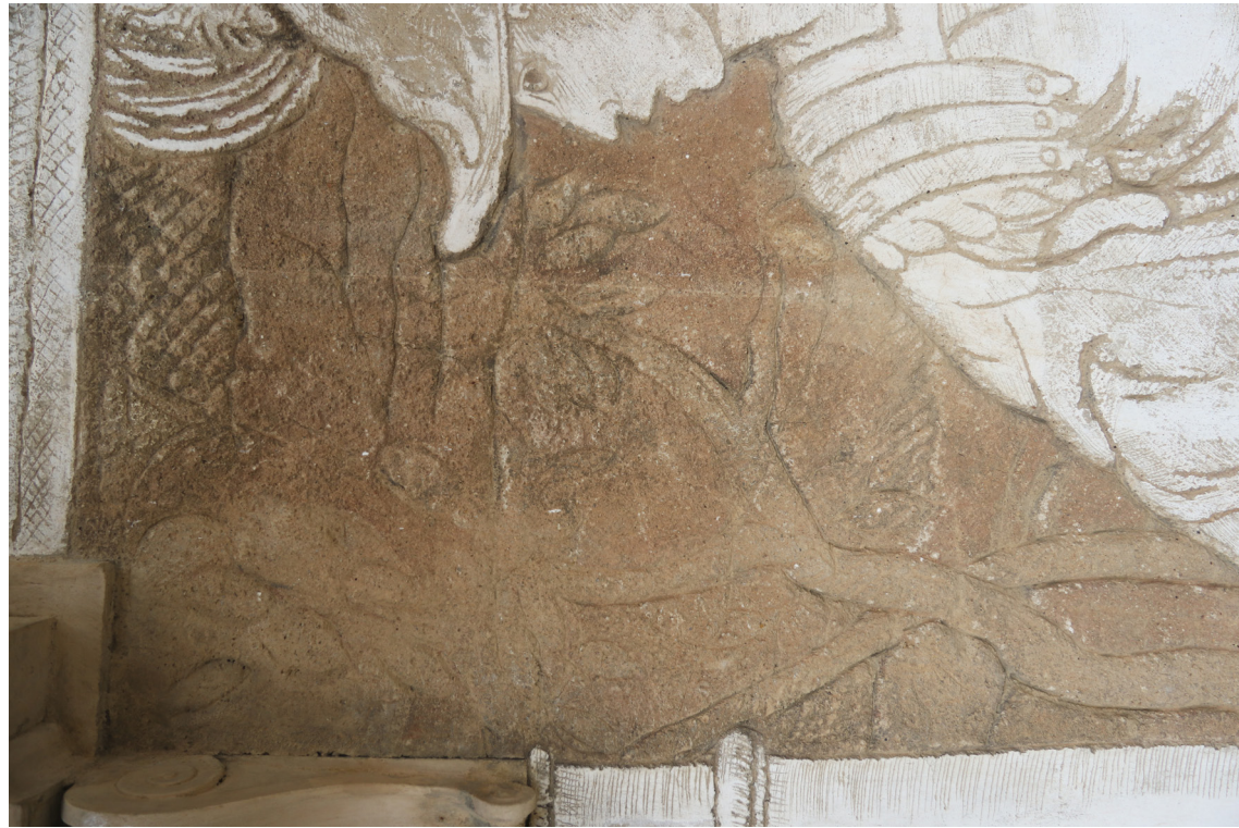
Obr. 18: Fotografie zachycuje ryté linie stromu na plošně odrytém pozadí. Původní barevnost omítky je překryta druhotnými lazurními nátěry. Stav před restaurováním.
