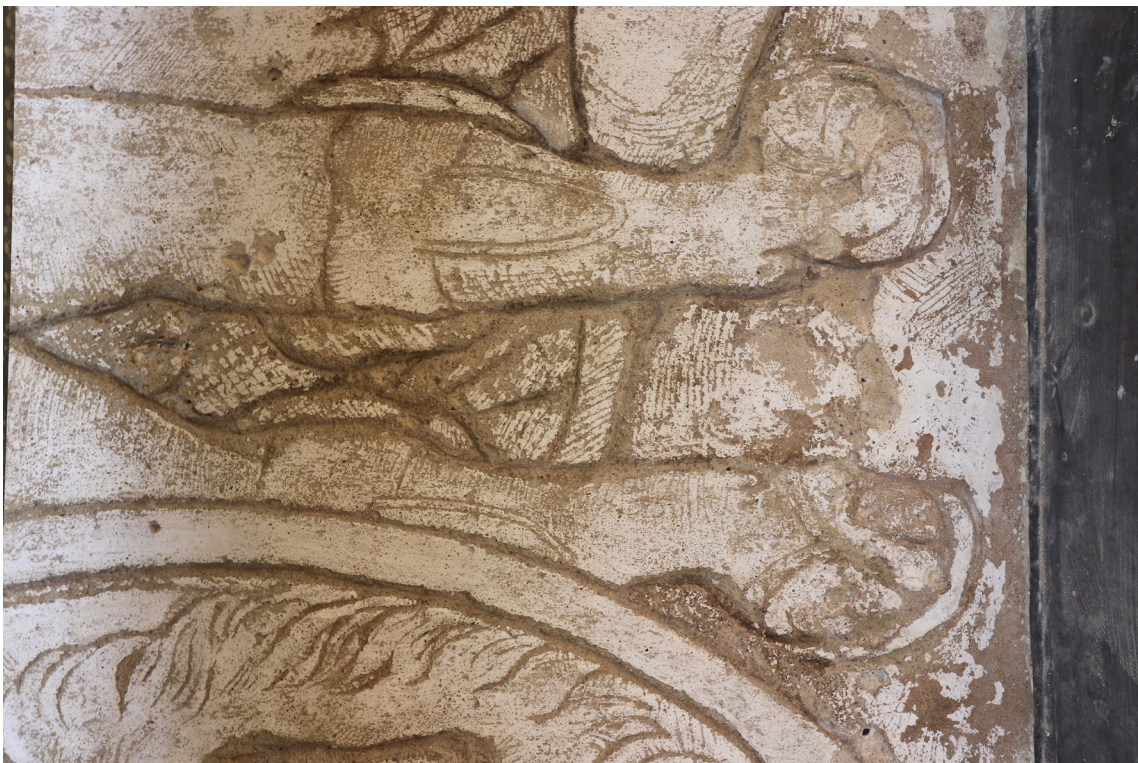
Obr. 32: Nejdegradovanější oblast restaurované části. V těchto místech byla provedena rozsáhlá konsolidace. Stav po očištění a injektáži.
