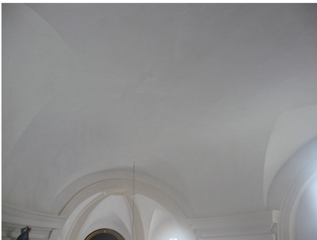
Obrázek 116 Klenba nad hlavní lodí
