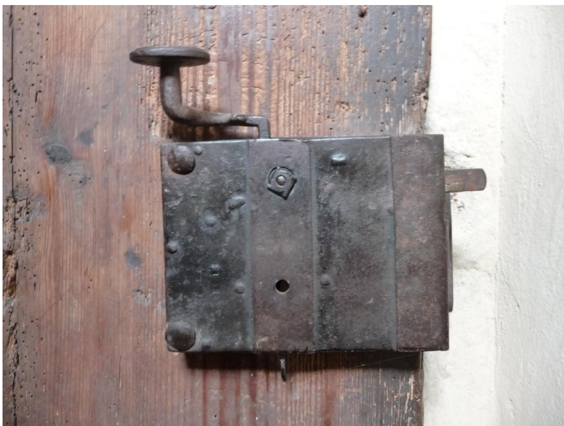
Obrázek 44 Dveře na schodiště na kůr - detail zámku
