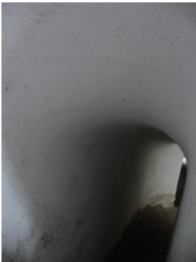
Obrázek 83 Klenba nad schodištěm na kůr
