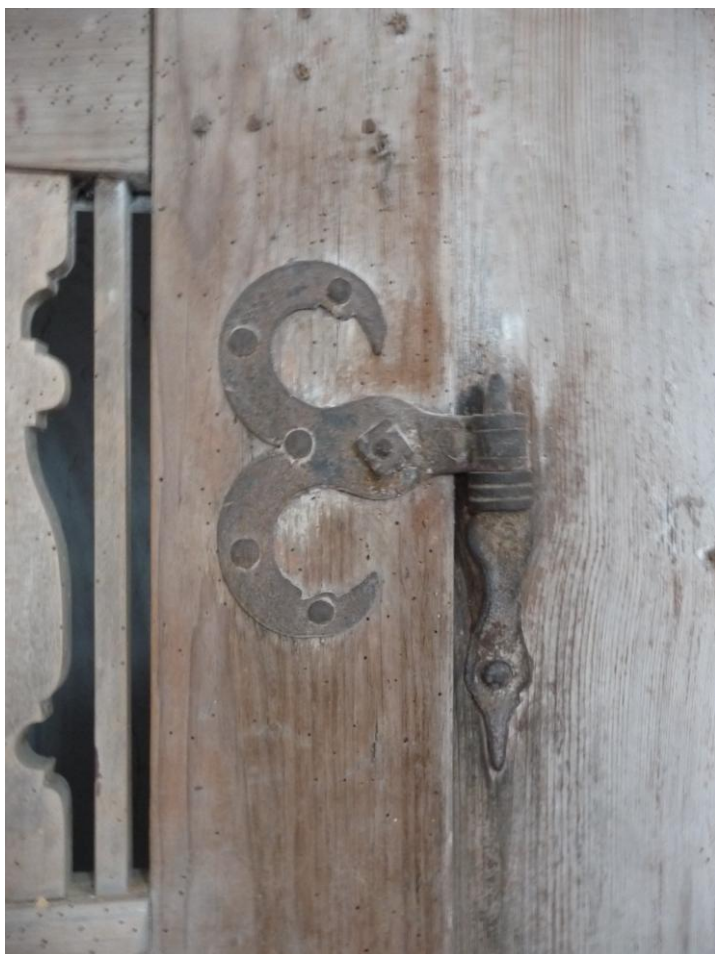
Obrázek 92 Dvířka na kůr - detail závěsu a závěsného háku
