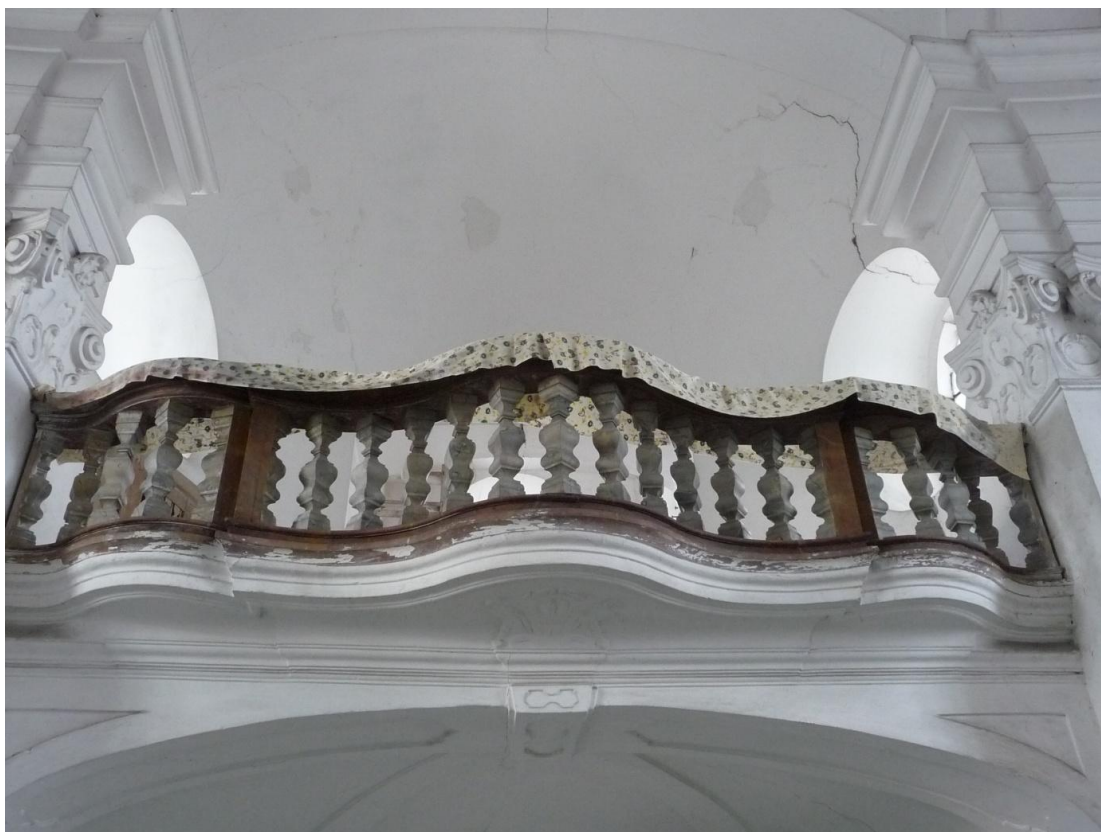
Obrázek 98 Balustráda na kůru
