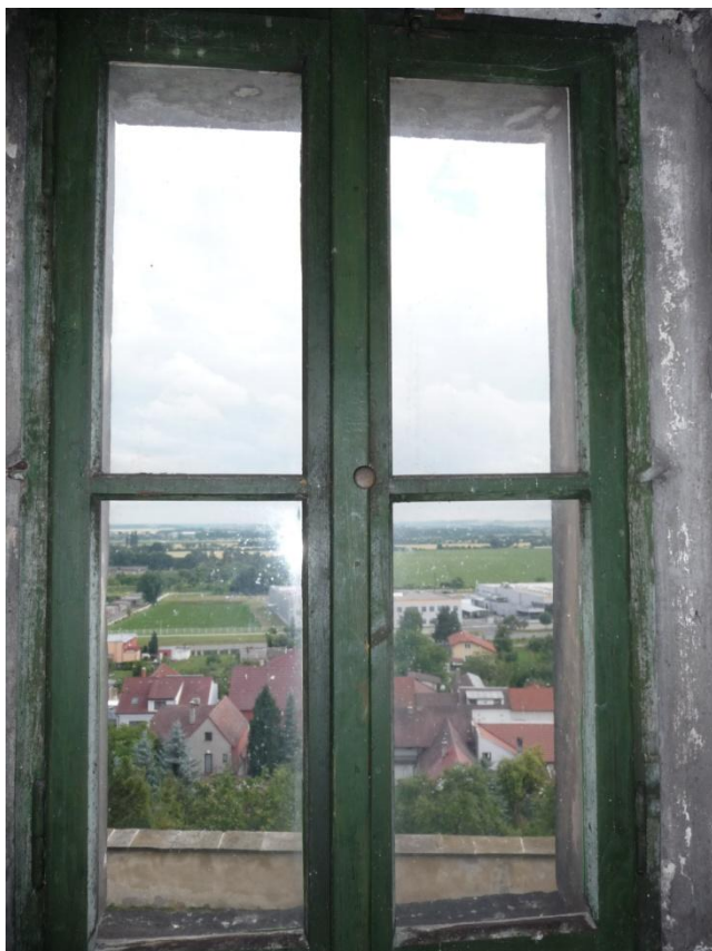
Obrázek 59 Příklad okna u schodiště na kůr - lícová strana
