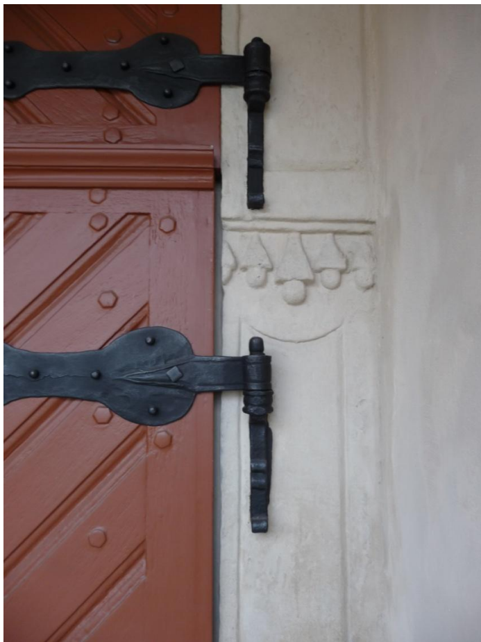
Obrázek 119 Vstupní dveře - detail závěsu a dveřního háku
