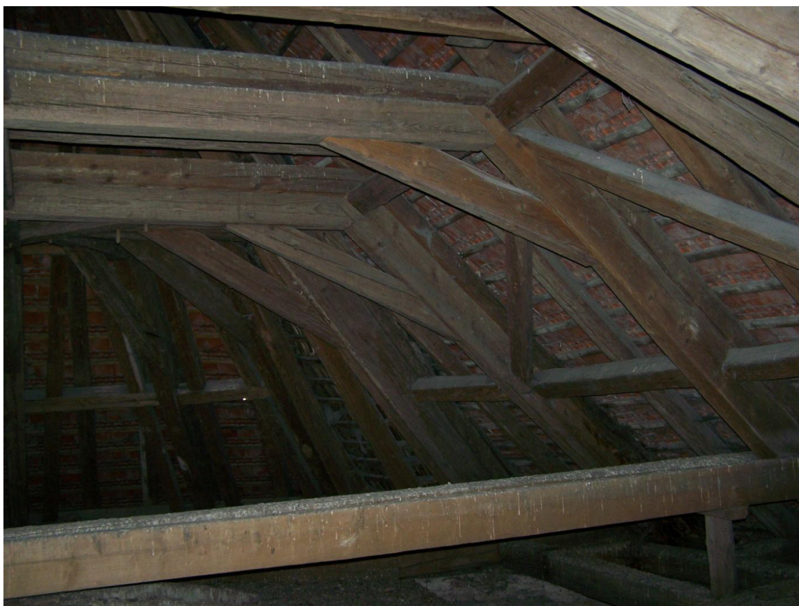
Obrázek 79 Krov nad hlavní lodí
