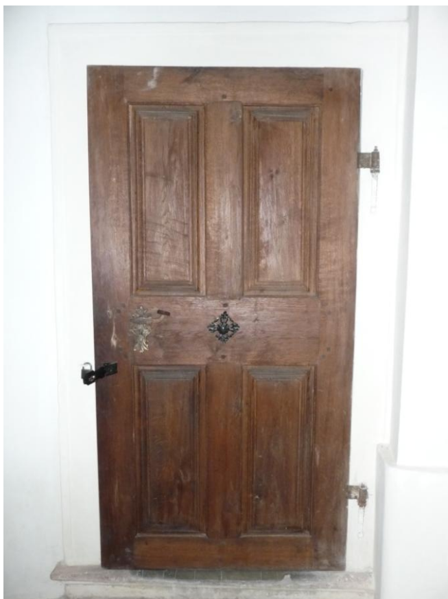
Obrázek 121 Dveře na schodiště na kůr - lícová strana
