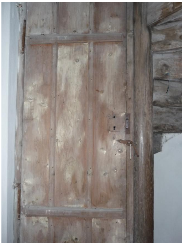
Obrázek 125 Dveře do krovu - lícová strana
