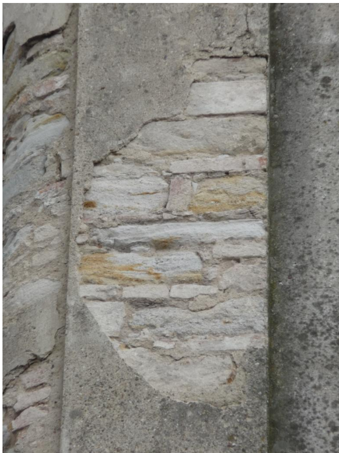
Obrázek 76 Odhalené zdivo hlavní lodi
