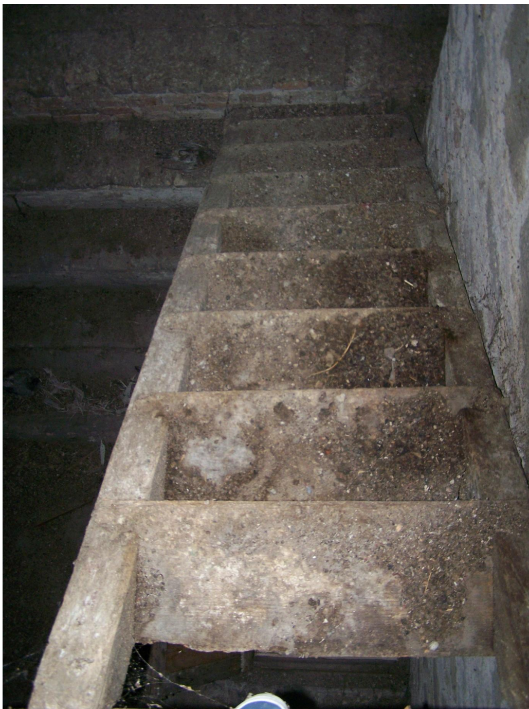
Obrázek 85 Schodiště z krovu do věže
