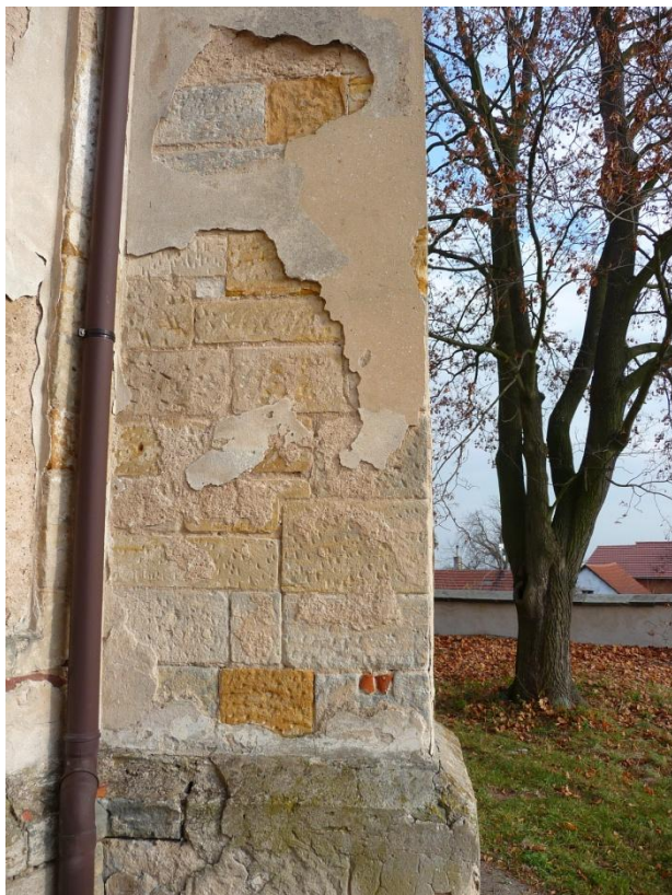
Obrázek 22 Odhalené zdivo v opěrném systému presbytáře s patrným pekováním
