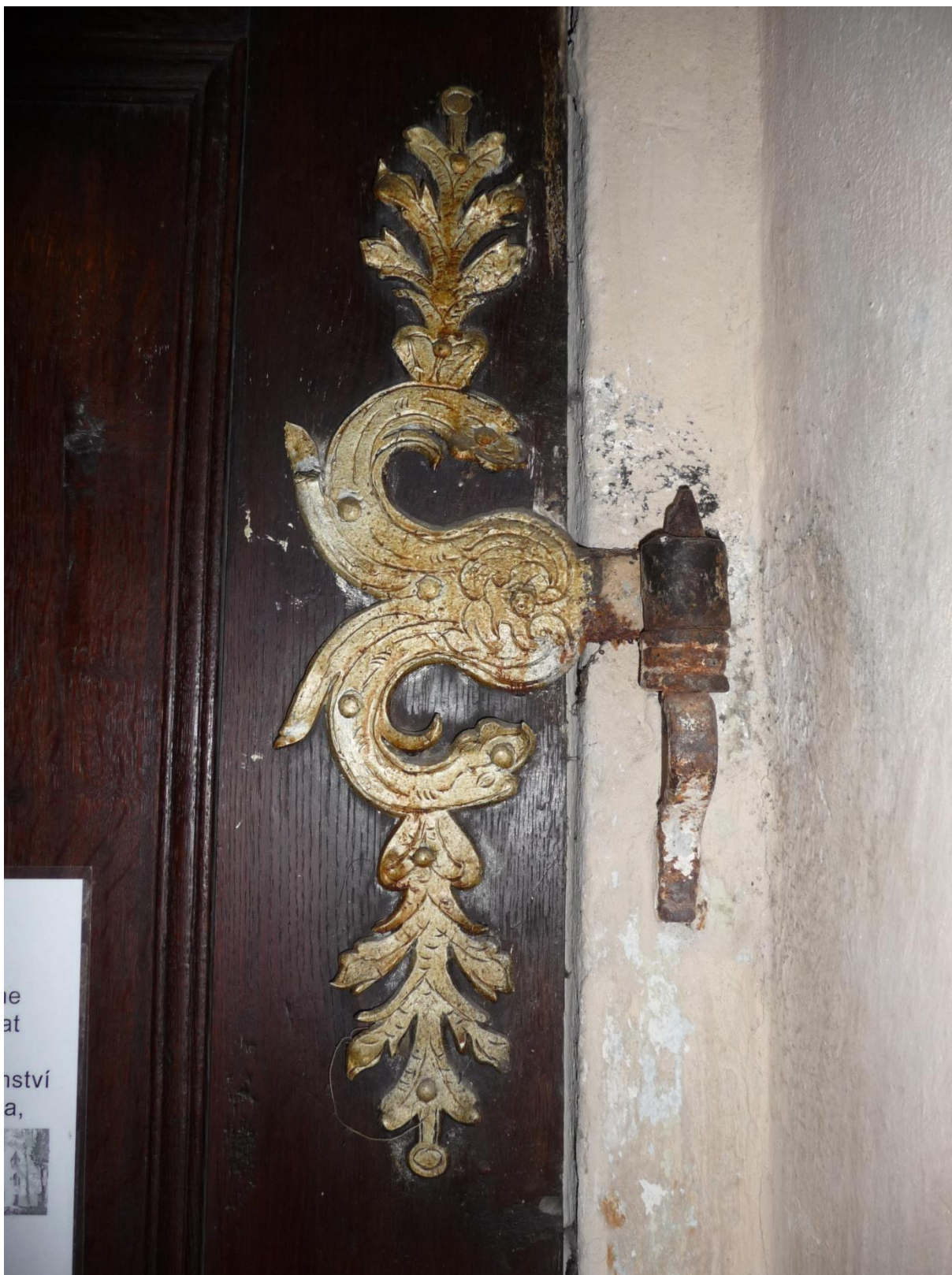
Obrázek 49 Dveře do sakristie - detail závěsu a dveřního háku
