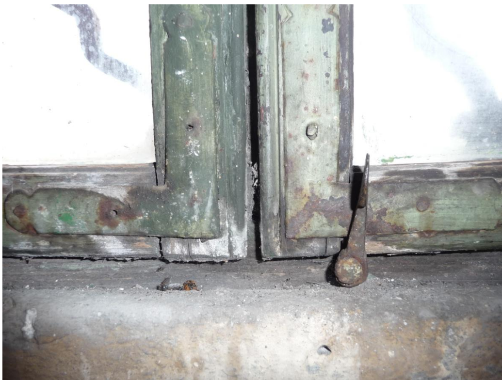
Obrázek 57 Okno u schodiště na kůr - detail zavírání
