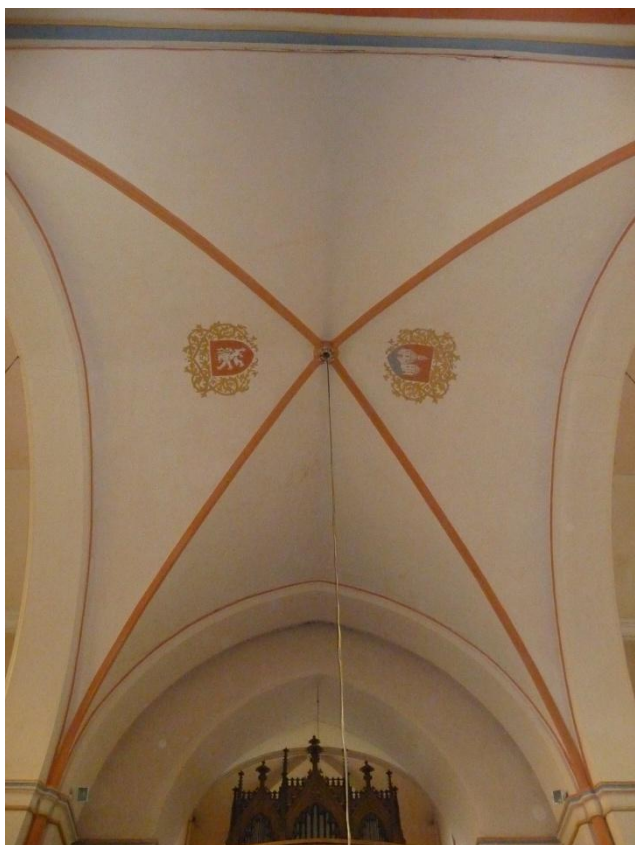
Obrázek 32 Falešná klenba nad hlavní lodí
