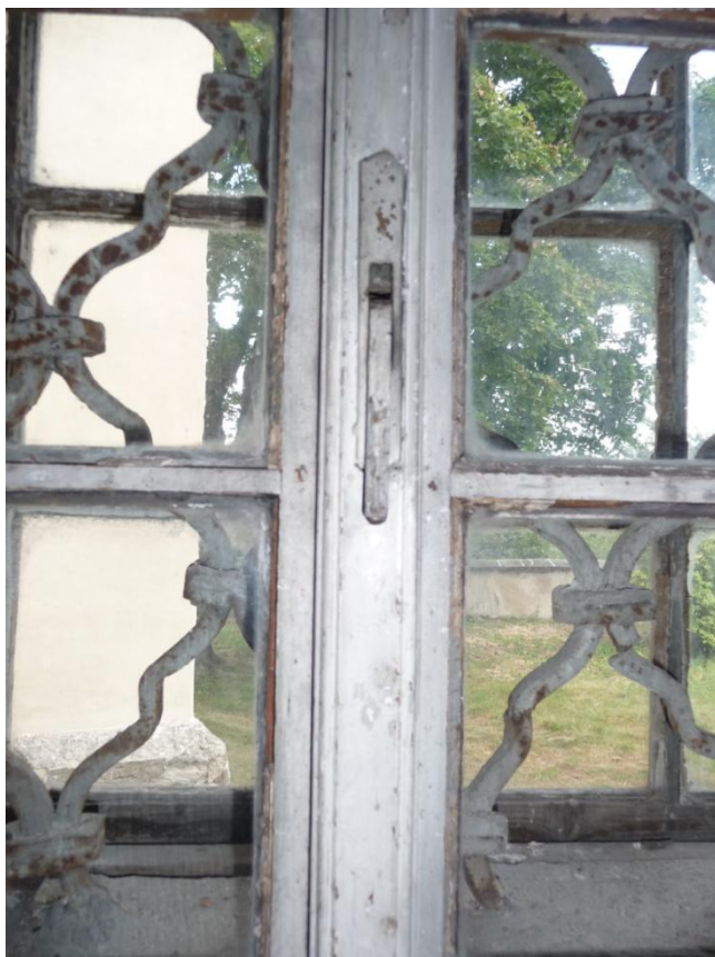
Obrázek 63 Okno v sakristii - detail otvírání
