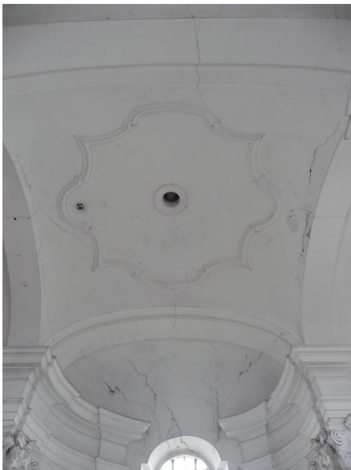
Obrázek 81 Klenba nad hlavní lodí - lícová strana
