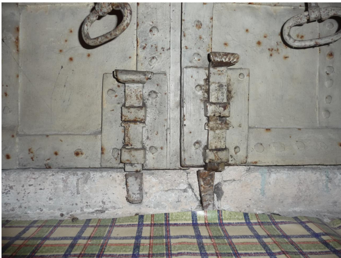
Obrázek 66 Železná okenice u okna v sakristii - detail zavírání
