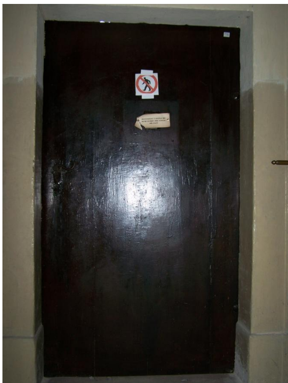
Obrázek 41 Dveře na schodiště na kůr - lícová strana
