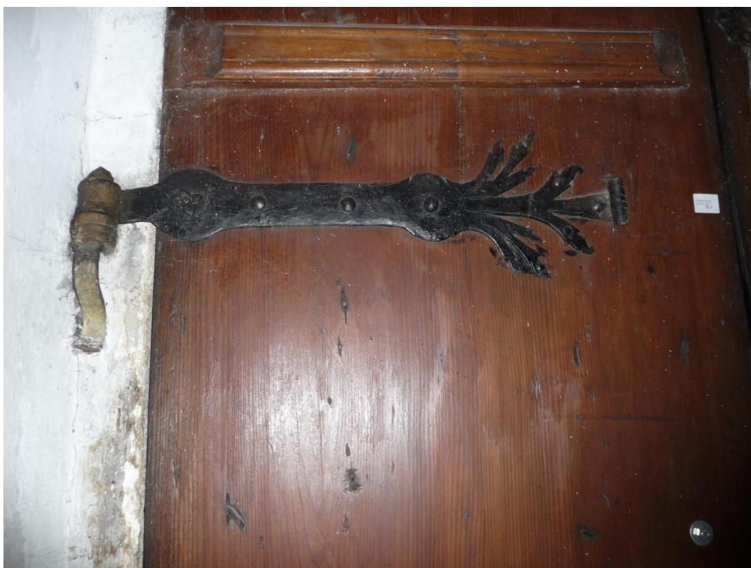
Obrázek 89 Vstupní dveře - detail závěsu a dveřního háku
