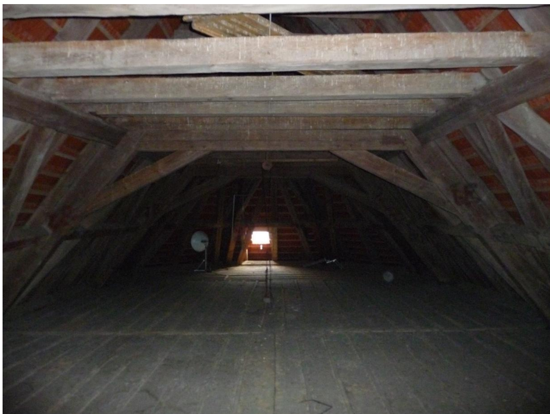
Obrázek 24 Krov nad hlavní lodí
