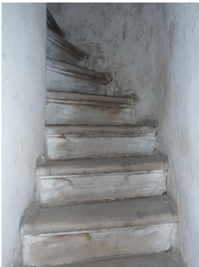
Obrázek 84 Schodiště na kůr
