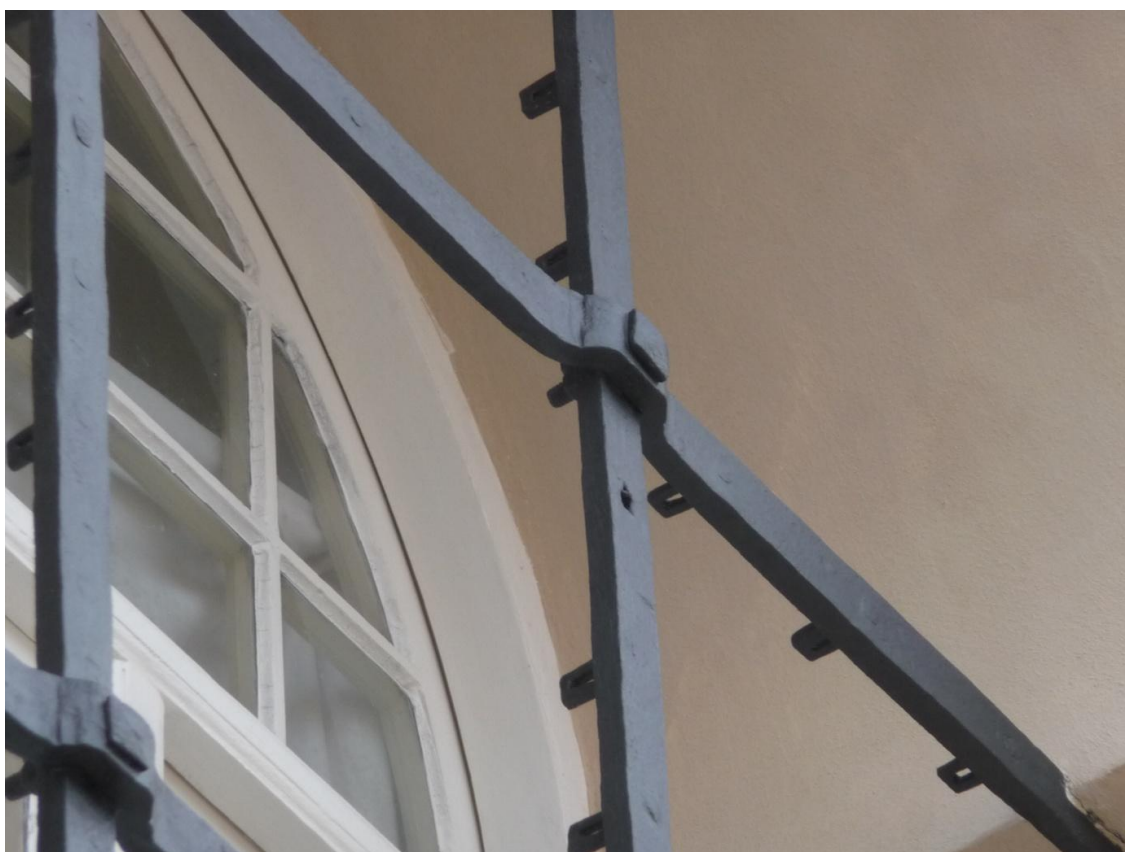
Obrázek 128 Mříže v oknech - detail
