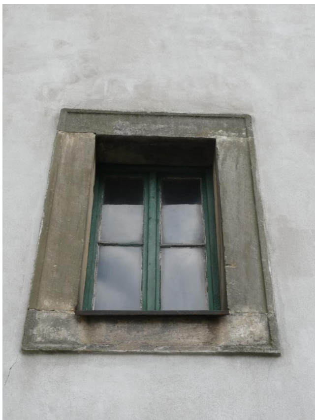
Obrázek 58 Příklad okna u schodiště na kůr - lícová strana
