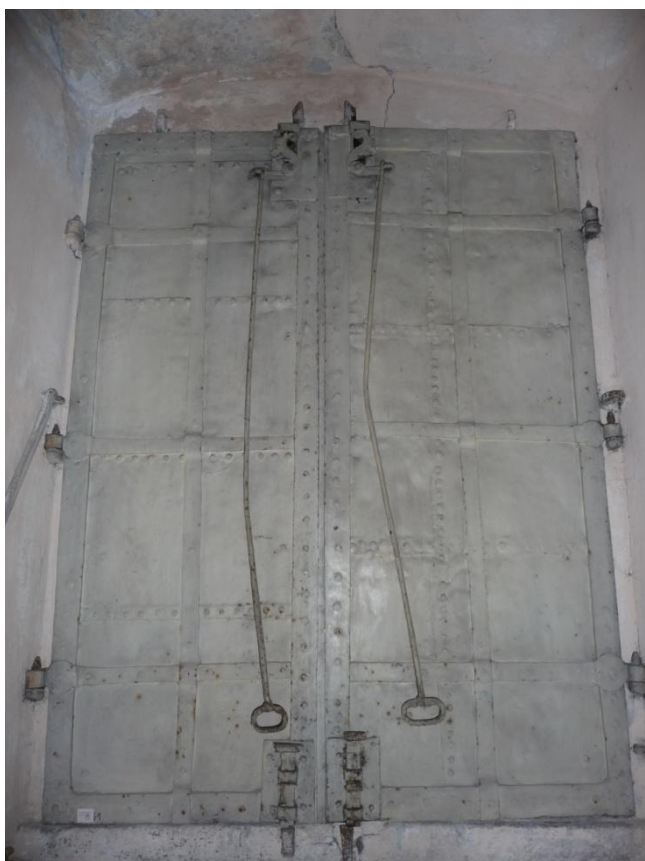
Obrázek 65 Železná okenice u okna v sakristii - rubová strana
