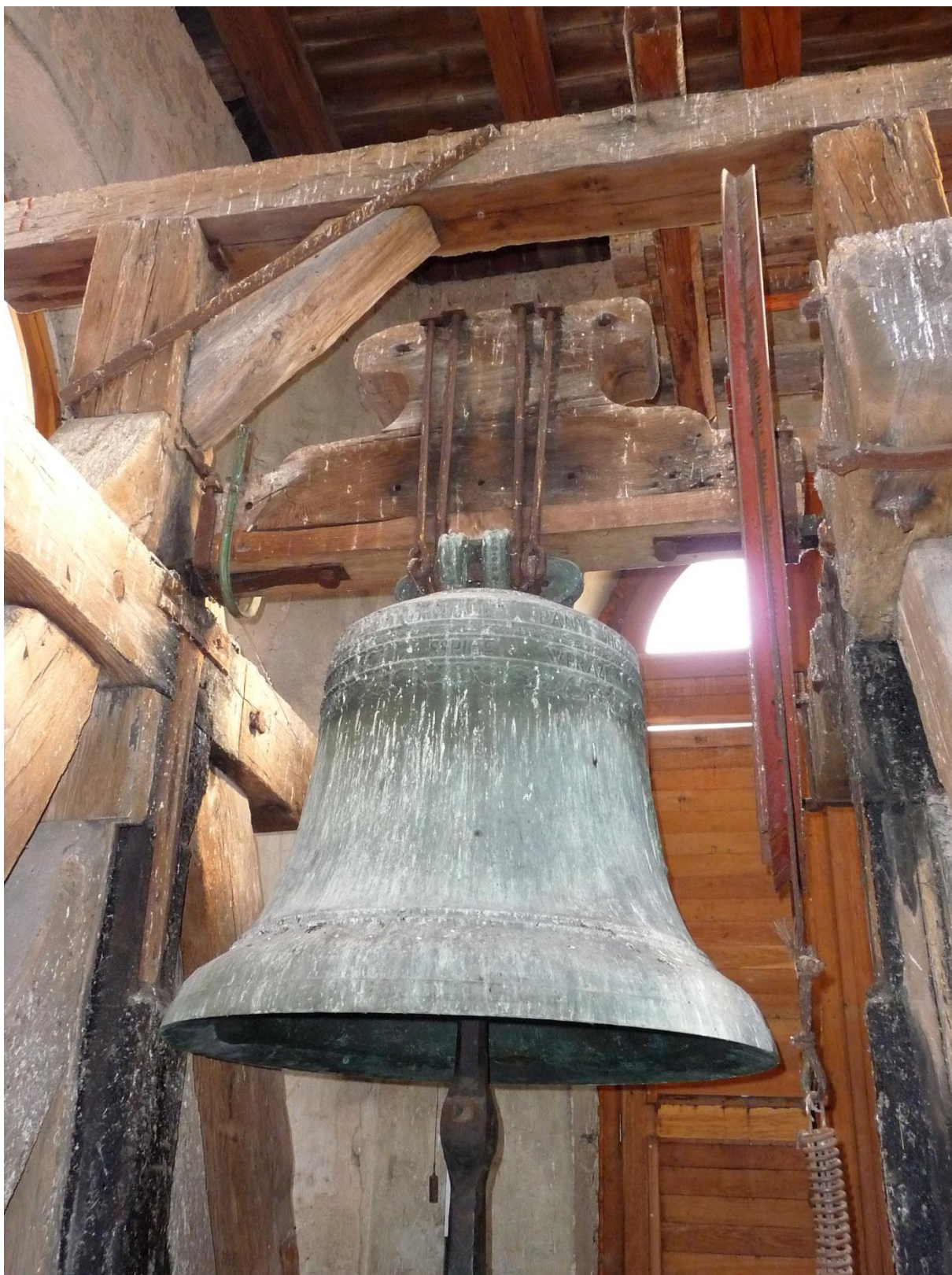
Obrázek 30 Zvonová stolice - detail zavěšení zvonu
