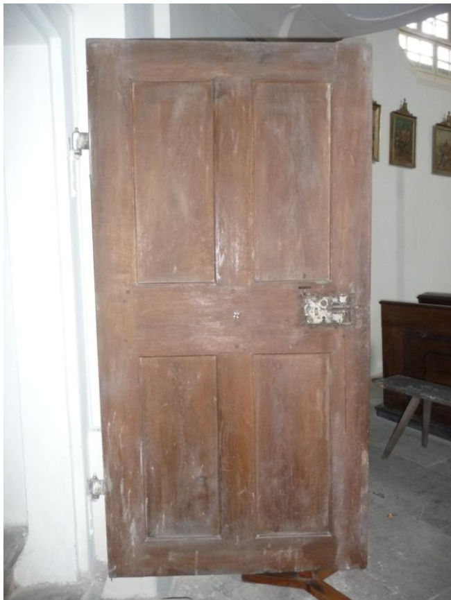
Obrázek 122 Dveře na schodiště na kůr - rubová strana
