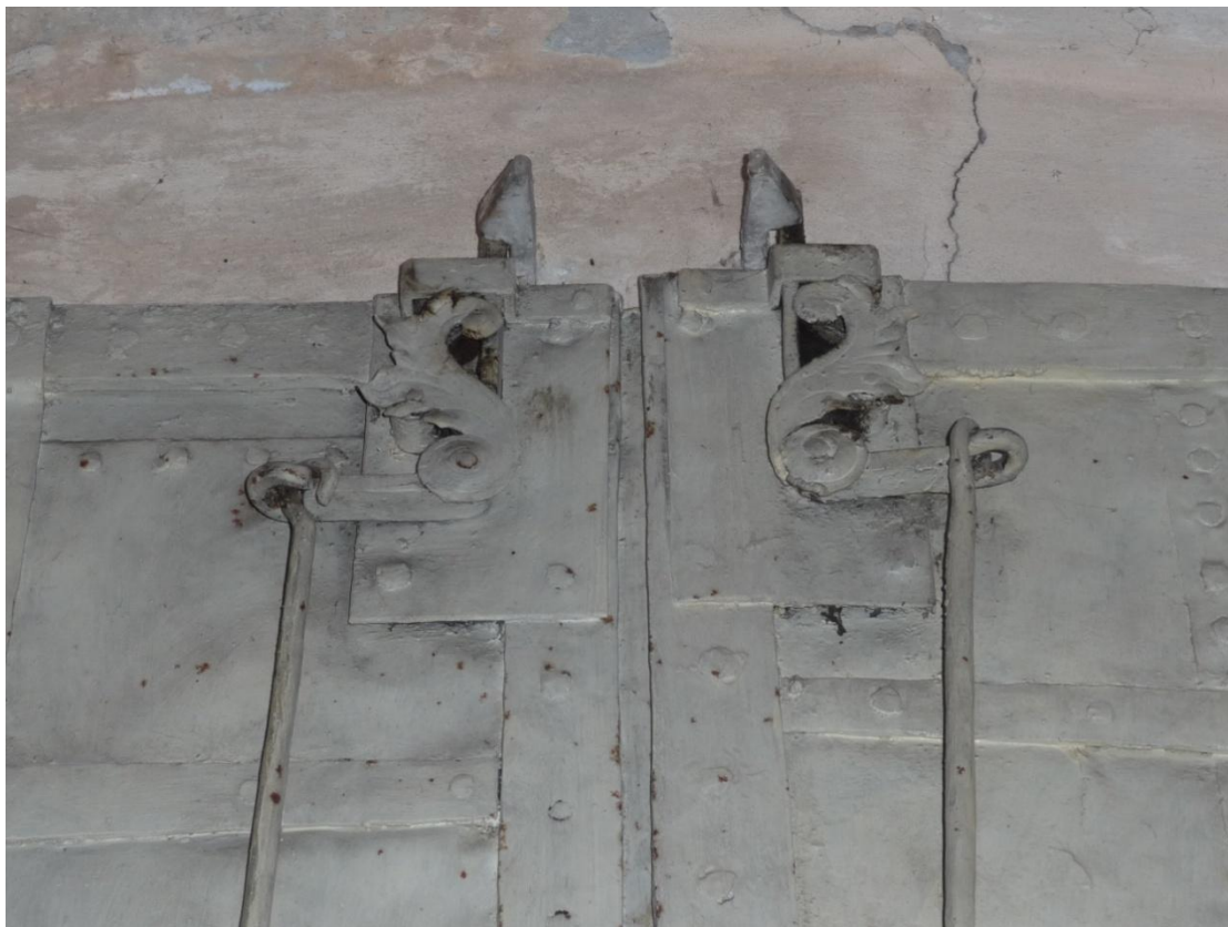
Obrázek 67 Železná okenice u okna v sakristii - detail zavírání
