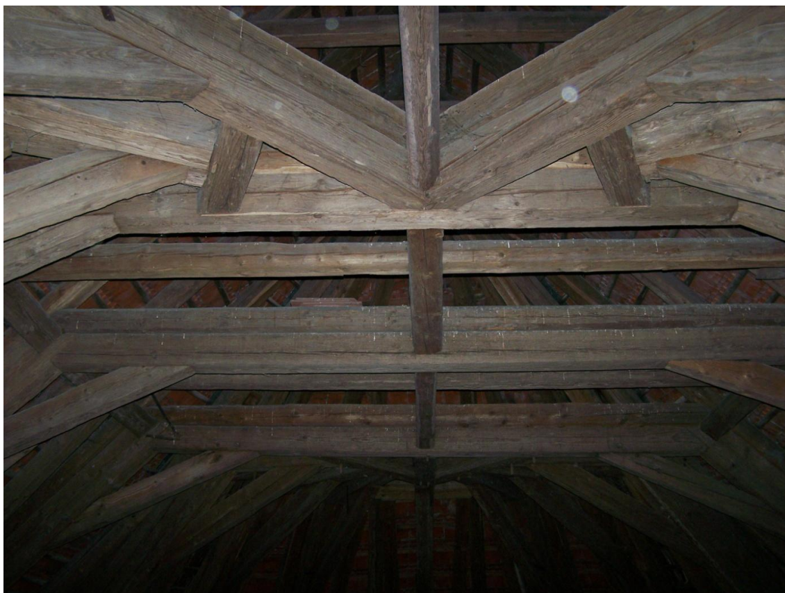
Obrázek 78 Krov nad hlavní lodí
