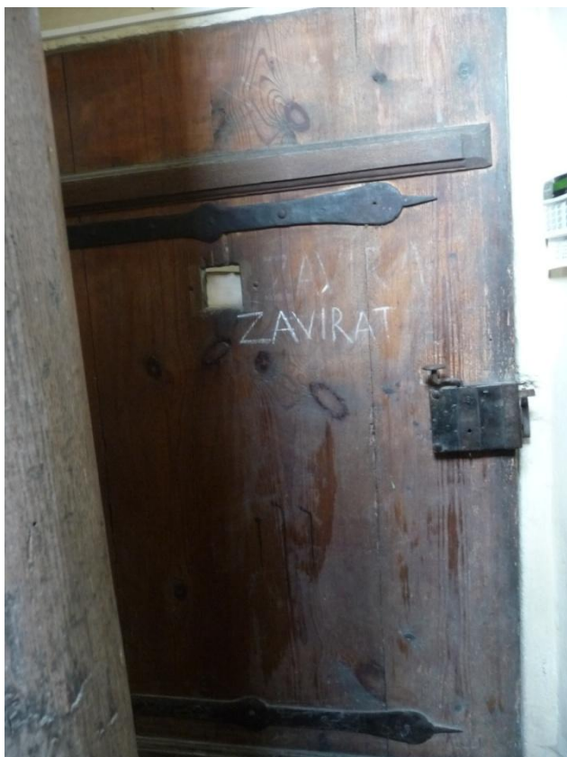
Obrázek 42 Dveře na schodiště na kůr - rubová strana
