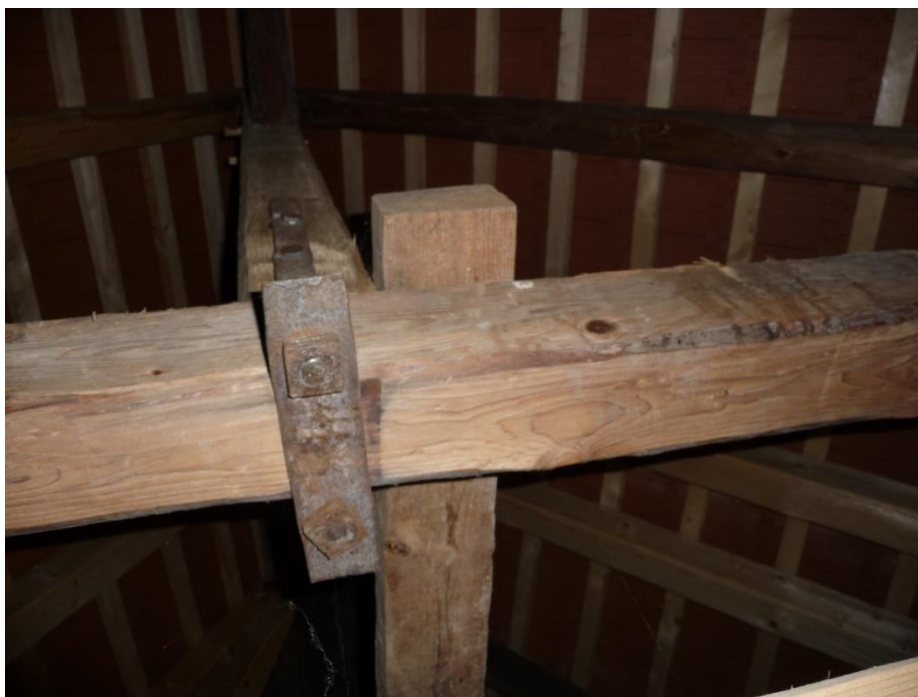
Obrázek 111 Krov nad hlavní lodí - detail závěsu
