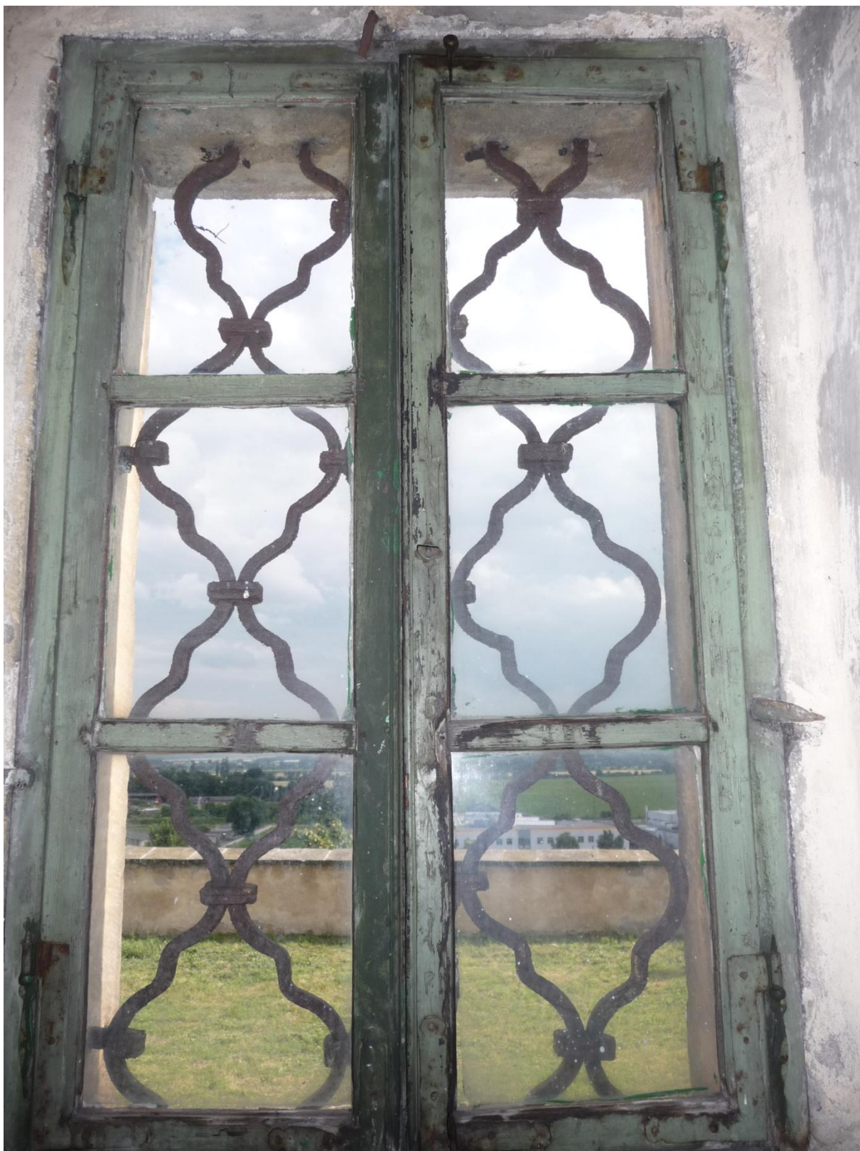
Obrázek 55 Okno u schodiště na kůr
