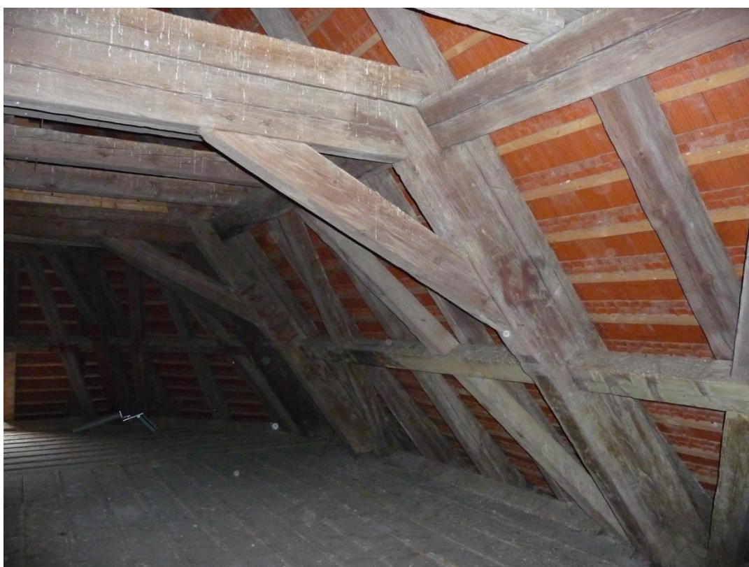
Obrázek 25 Krov nad hlavní lodí
