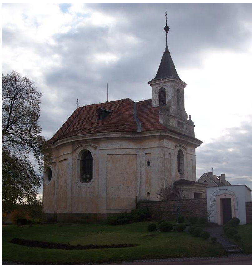
Obrázek 107 Pohled na kostel z severozápadu
