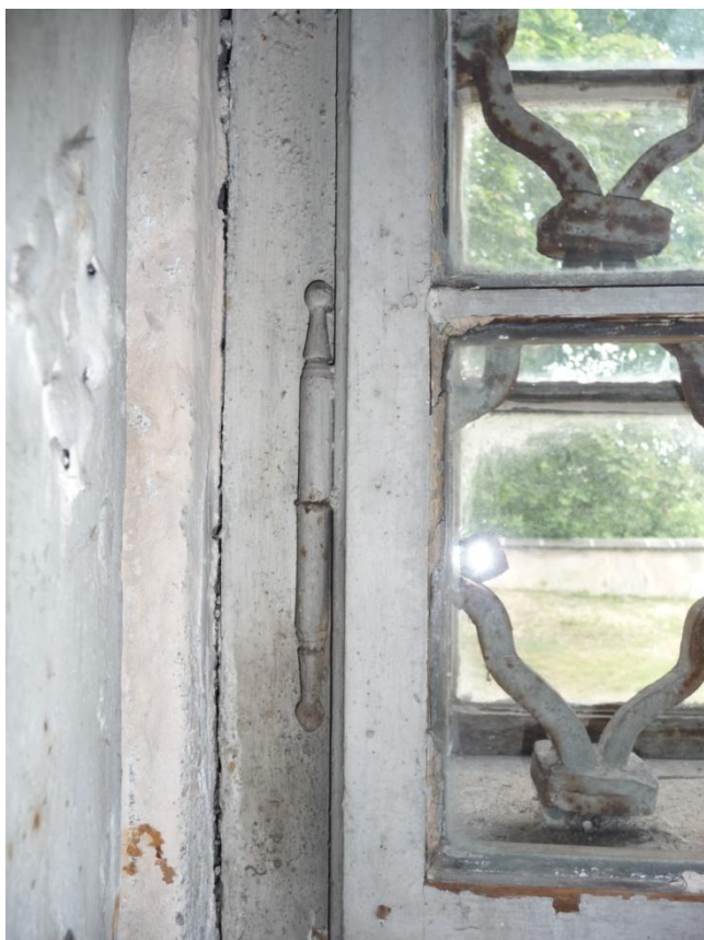
Obrázek 62 Okno v sakristii - detail závěsu
