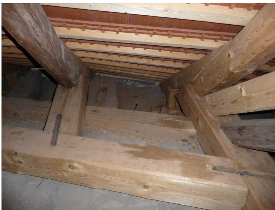
Obrázek 112 Krov nad hlavní lodí - detail paty krovu
