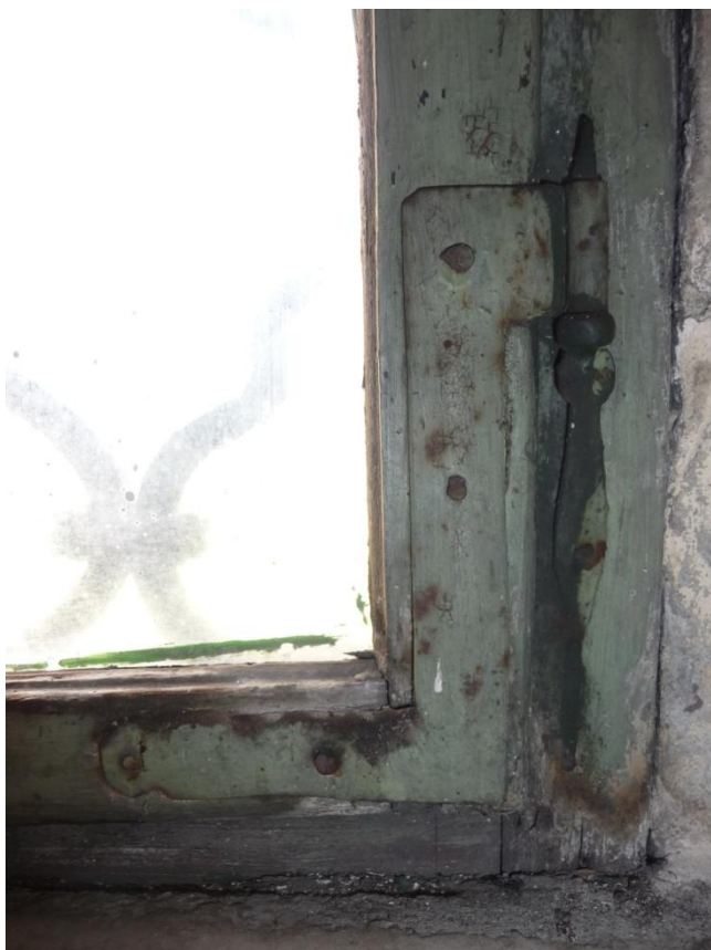
Obrázek 56 Okno u schodiště na kůr - detail závěsu a závěsného háku
