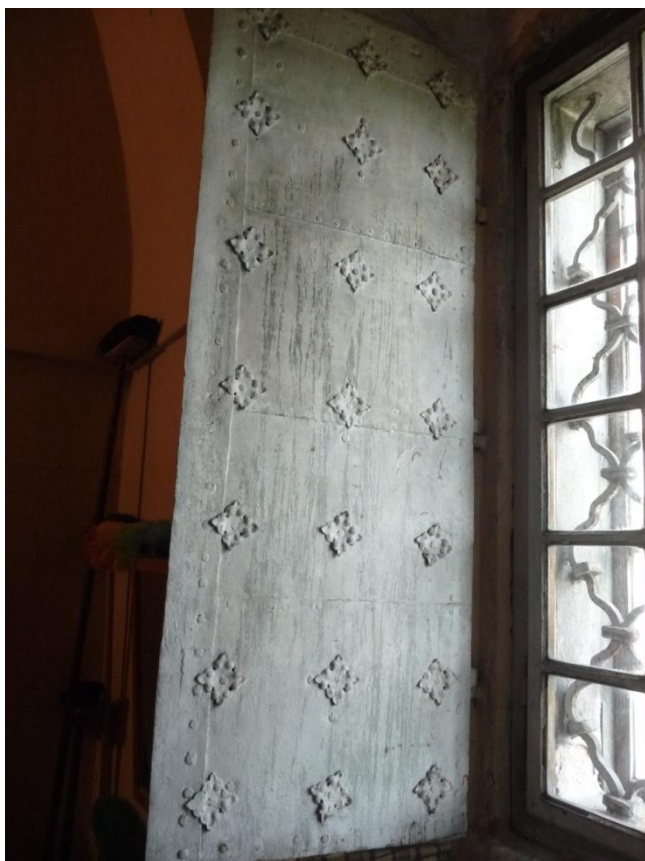
Obrázek 64 Železná okenice u okna v sakristii - lícová strana
