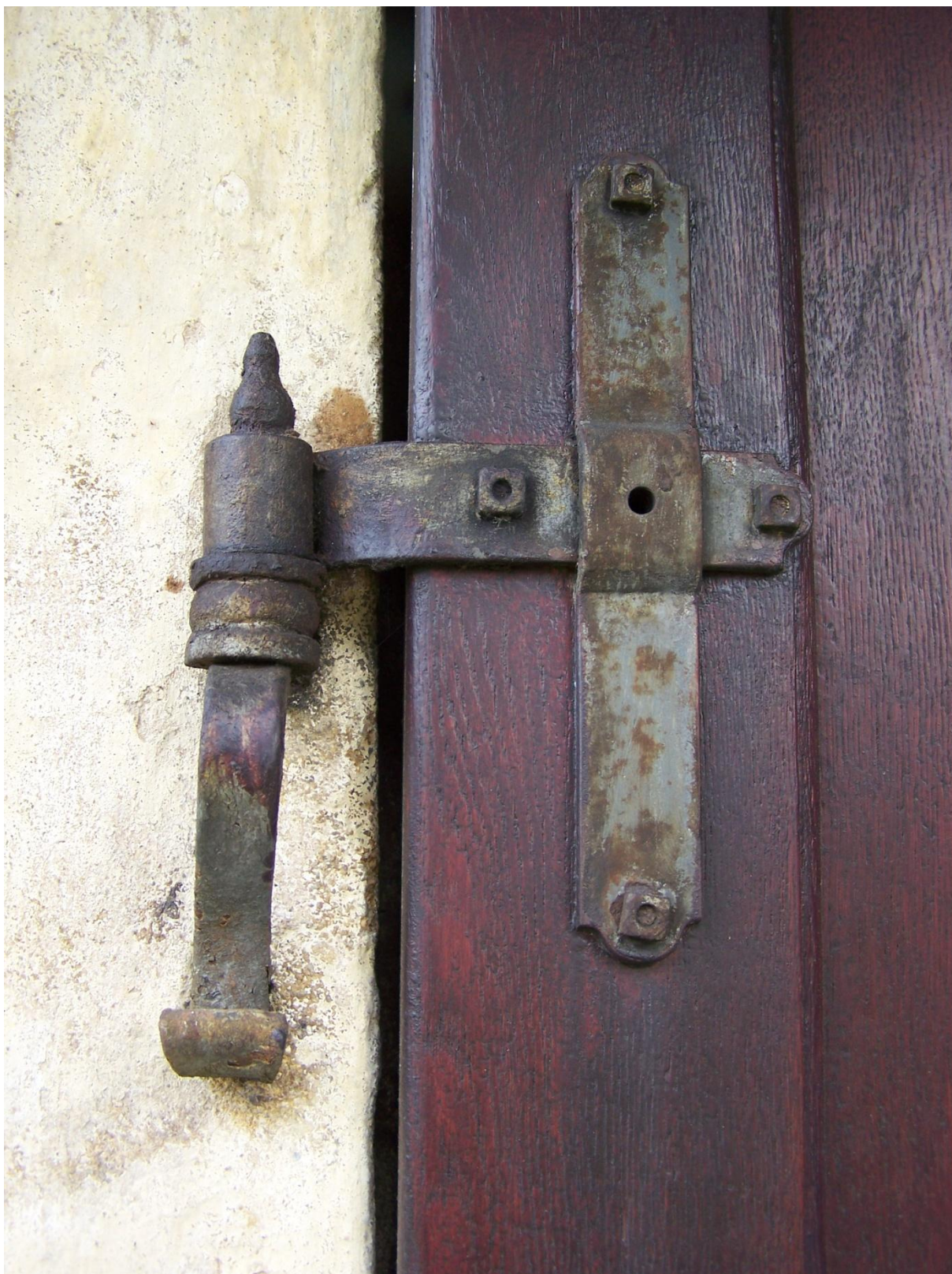
Obrázek 40 Vstupní dveře - detail závěsu a dveřního háku
