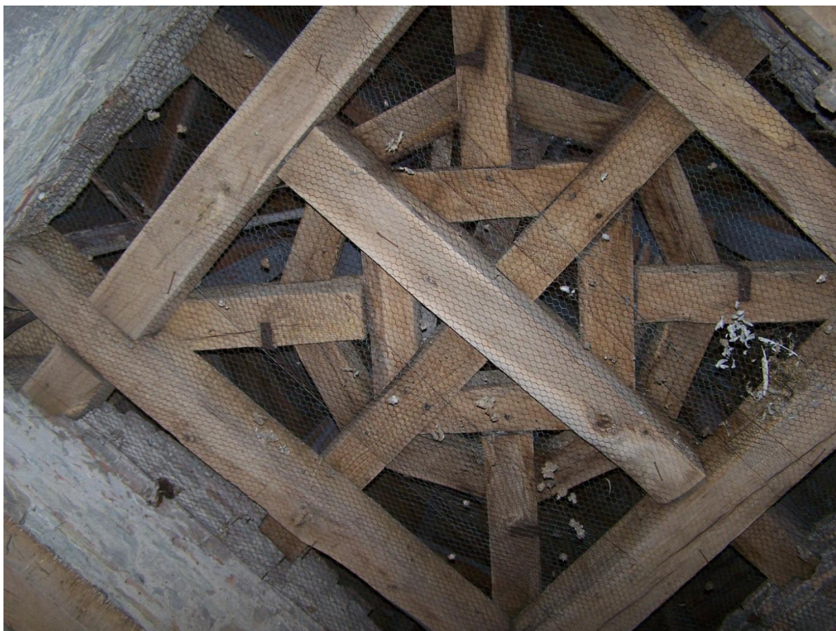
Obrázek 80 Základový rošt krovu u střechy věže
