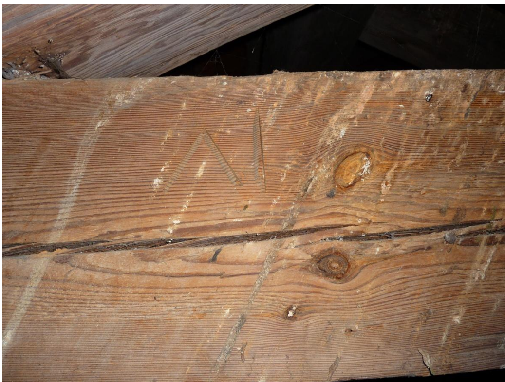
Obrázek 26 Tesařská značka v krovu nad hlavní lodí
