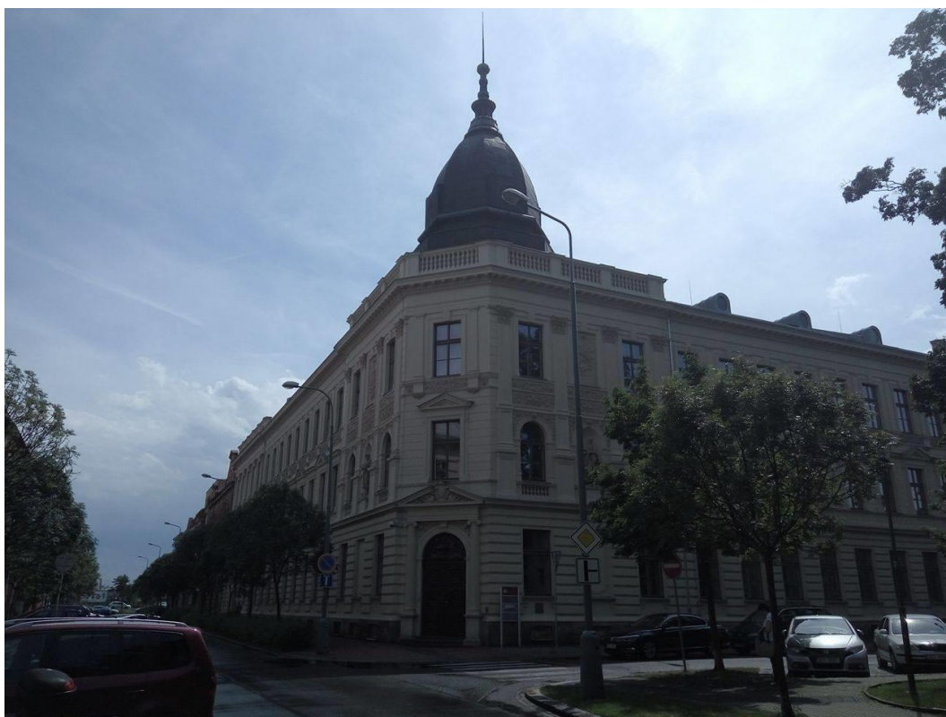
Obrázek 6 - Pohled na budovu bývalé Průmyslové školy v Pardubicích v současnosti
