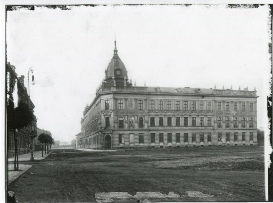
Obrázek 1 - Nově postavená budova Průmyslové školy v Pardubicích
