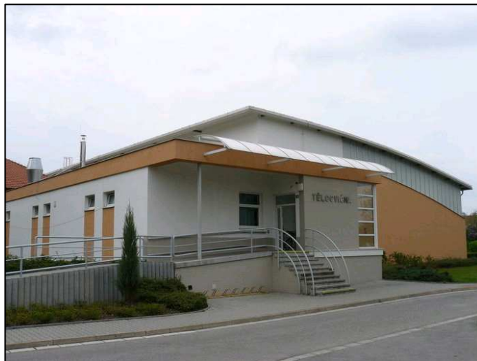
Obr.č.6: Tělocvična Chvaletice
