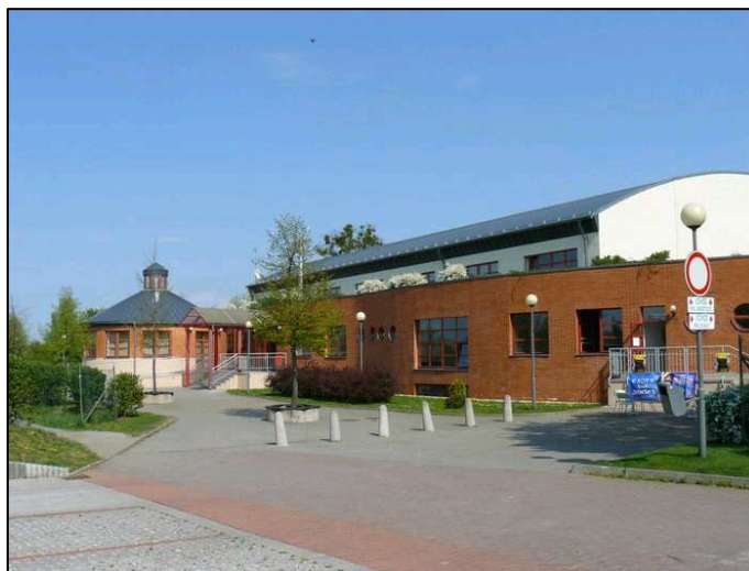
Obr.č.7: Sportovní hala Heřmanův Městec
