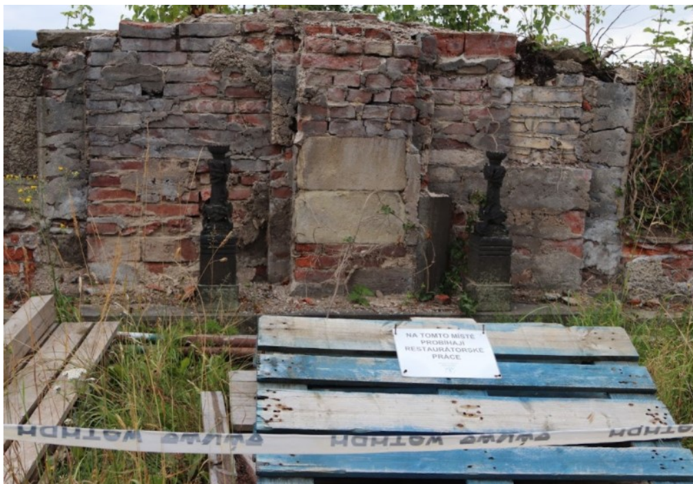
Obrázek 35 Králíky – městský hřbitov: hrob rodiny Walterovy – probíhající restaurátorské práce, stav k 8/2018 928
