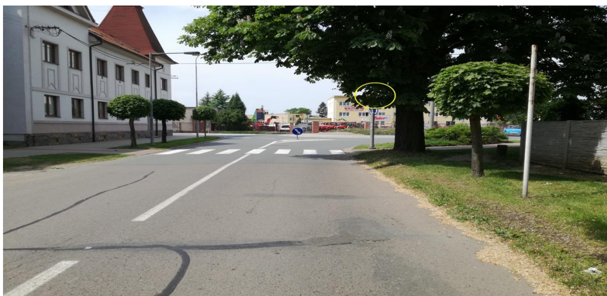
Obrázek 29: Přechod v ulici Nádražní
