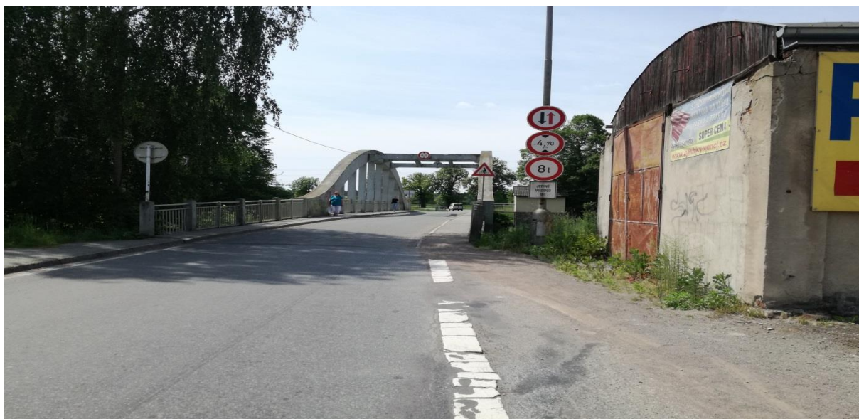
Obrázek 23: Most přes Orlici – směr Albrechtice nad Orlicí
