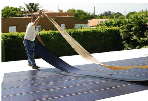
Obr. 3-20 Tenkovrstvý solární panel [18]
