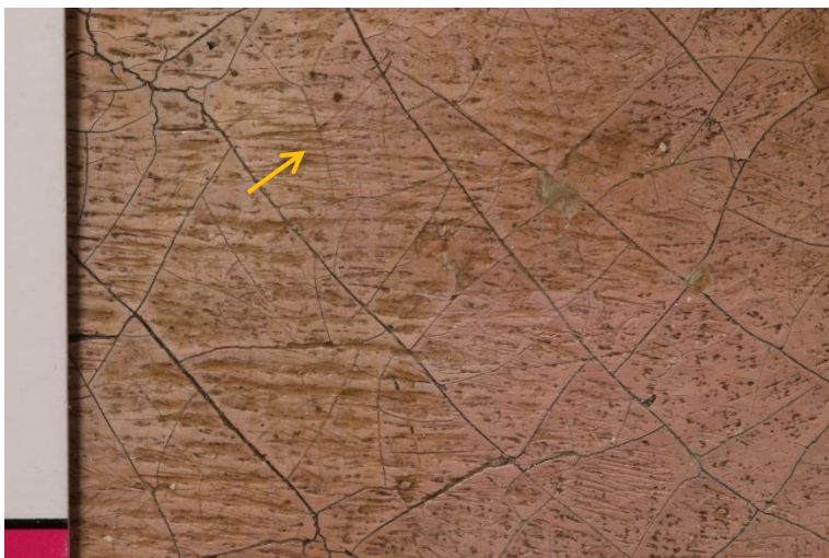
Obrázek 14 Detail mechanického poškození barevné vrstvy.
