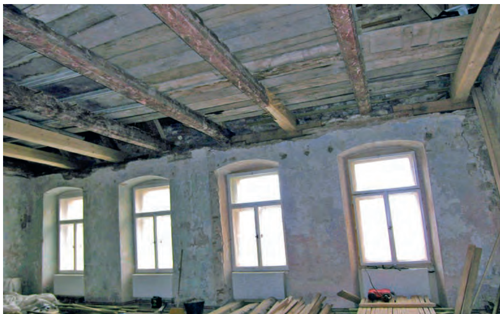
Obr. 3 Mělník, zámek, bývalý hostinec zvaný Peklo - č. p. 20, 1. patro, malované stropní trámy a zároveň vazné trámy krovu, stav po sejmutí záklopu (nabrázen manipulační podlahou) a tesařské sanaci krovu, která proběhla bez zájmu restaurátorky odpovědné za restaurování stropu. (Foto V. Jesenský, 2012)
