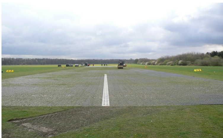
Obr. 26 Ukázka použití systému Terra-Grid E35 na letišti v Leverkusenu
