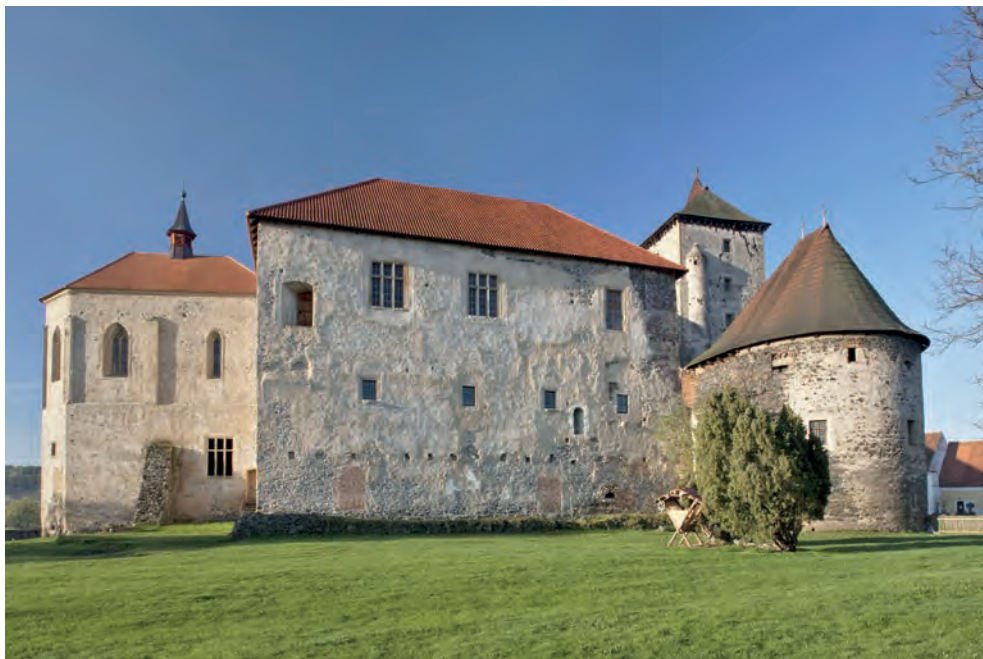
Obr. 3. Švihov, vodní hrad z konce 15. stol. – průčelí severního paláce a kaple po náročném zpevnění a konzervaci původních omítek a povrchů. (foto Gabriela Čapková)
