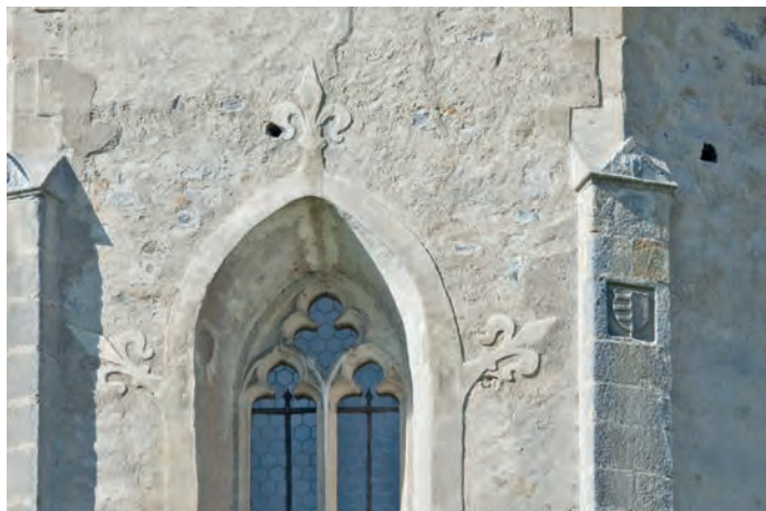
Obr. 5 Švihov, detail okna kaple s nenásilným zvýrazněním lilií ukončujících omítkové pasparty. (Foto Gabriela Čapková)
