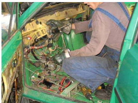
obrázek č.4 – Demontáž elektroinstalace
