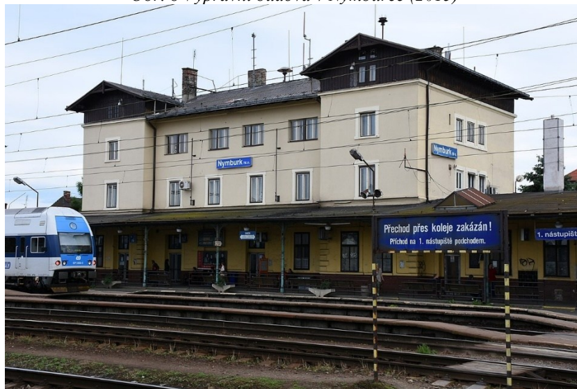
Obr. 8 Výpravní budova v Nymburce (2015)
