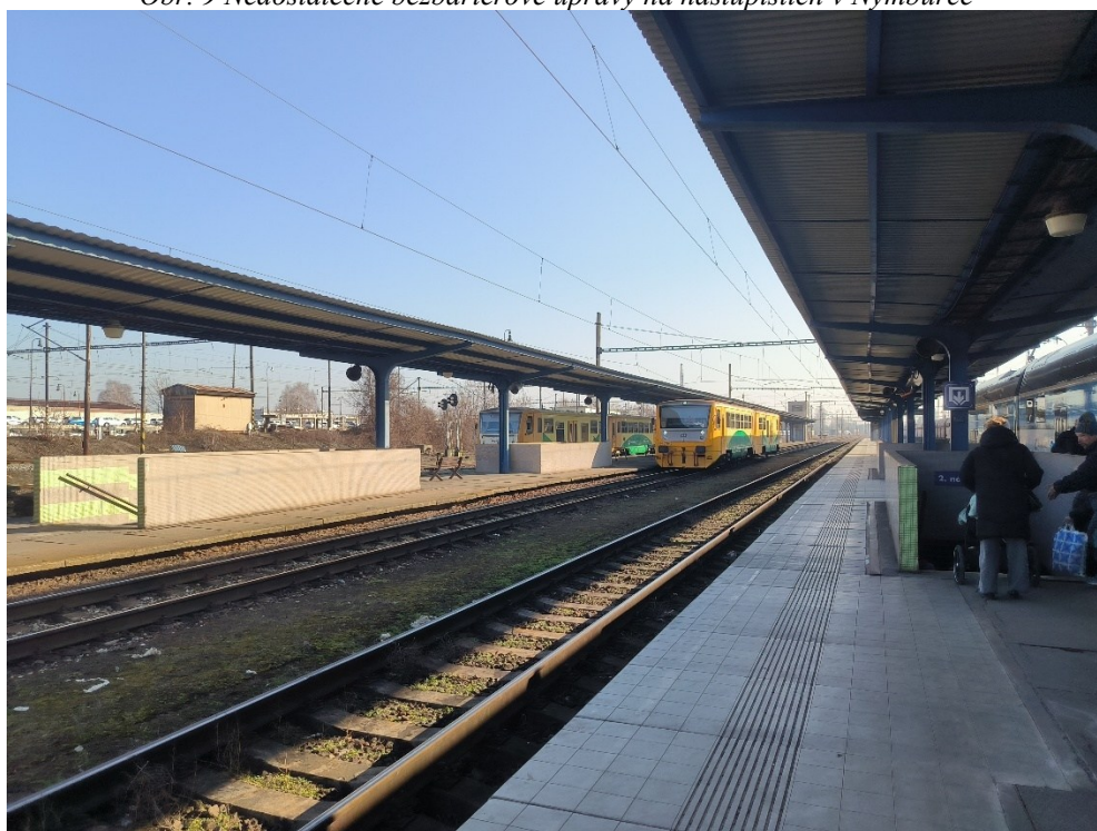
Obr. 9 Nedostatečné bezbariérové úpravy na nástupištích v Nymburce
