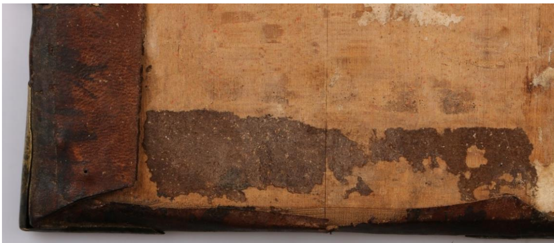
obr. 77 Detail spodní záložky – stav před restaurováním
