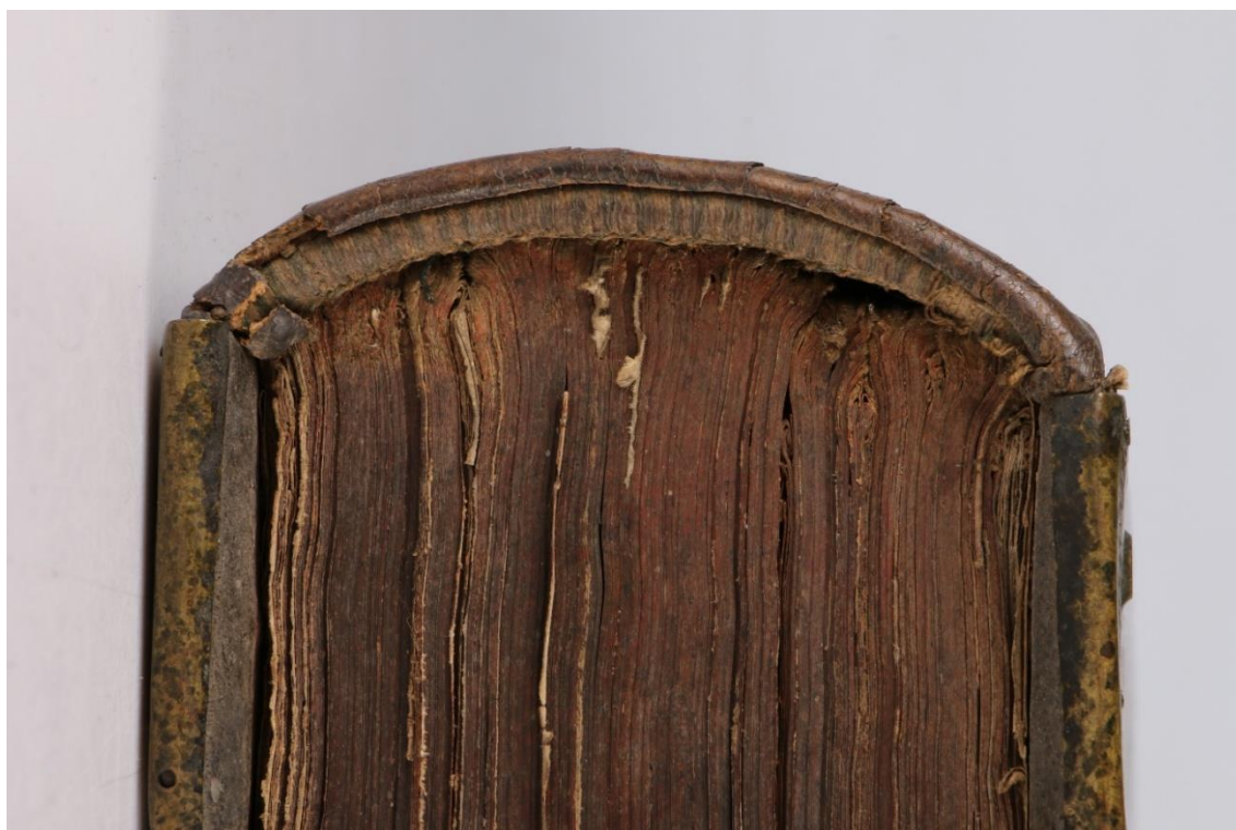
obr. 35 Detail hlavy s kapitálkem – stav před restaurováním
