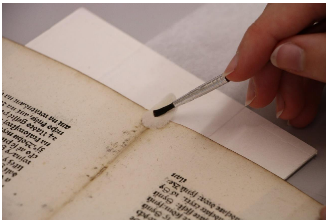
obr. 55 Vyspravování dvojlistů japonským papírem a záplatami z papíroviny
