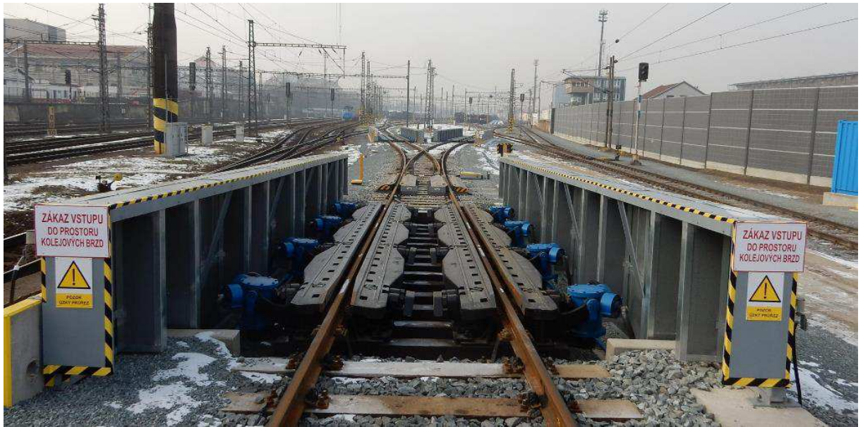
Obrázek 8: Kolejové brzdy s protihlukovými stěnami Praha-Libeň (16)
