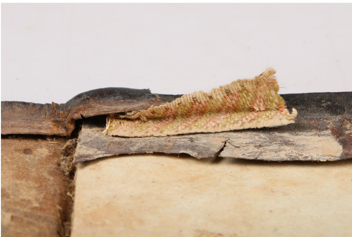
obr. 78 Fragment kapitálku u dolní hlavice – detail poškození
