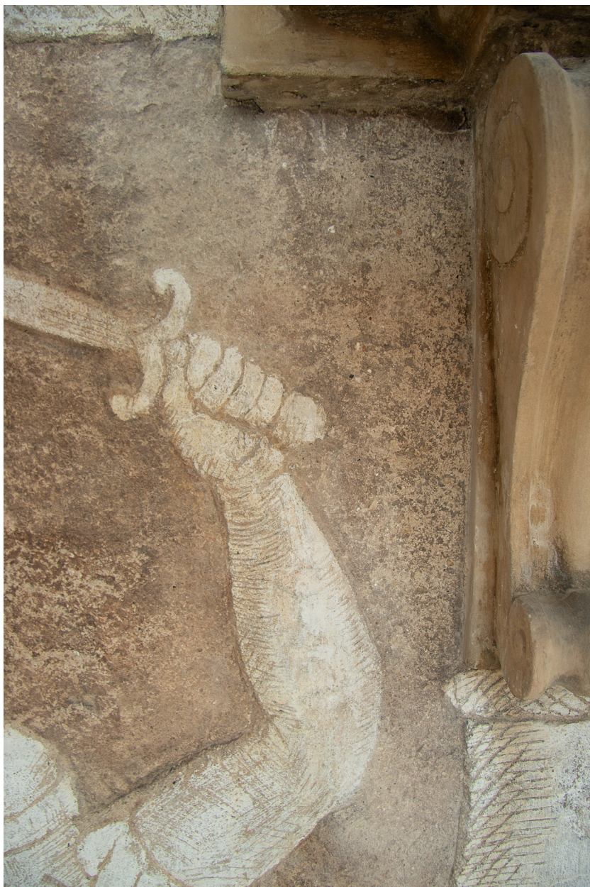
Obr. 29: Část výjevu v oblasti dešťového stínu. Stav po očištění sádrovcové krusty u hličitane mamonným.
