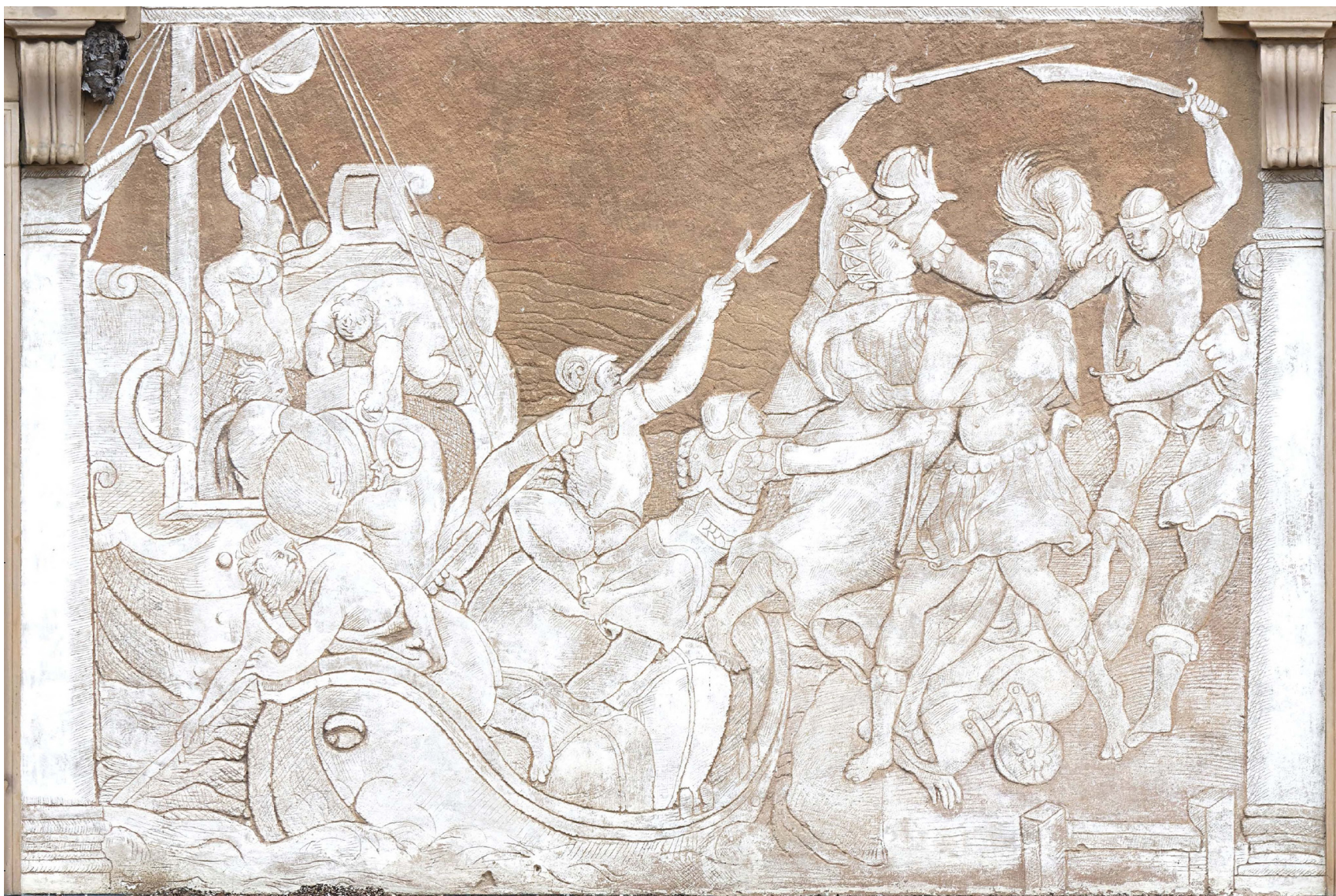
Obr. 09: Výjev Únos Heleny Trojské ve třetím figurálním pase severozápadní fasády II. nádvoří zámku Litomyšl. Stav před restaurováním.
