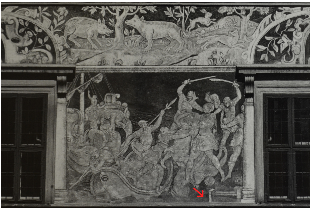
Obr. 05: Fotografie z roku 1976. Severozápadní fasáda II. nádvoří. Viditelná změna v kompozici ve spodní části výjevu. Druhotné tmelení podél oplechování okenní římsy z důvodu degradace původních materiálů způsobilo změnu např. u dřevěného zábradlí v pravém dolním rohu.
