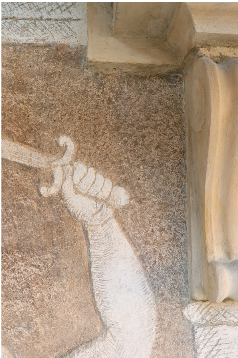
Obr. 37: Oblast deštinového stínu v stavu po restaurování.
