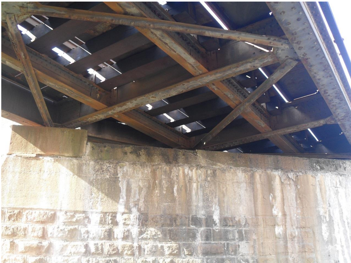
Obr. 7 – Spodní pohled na mostovku
