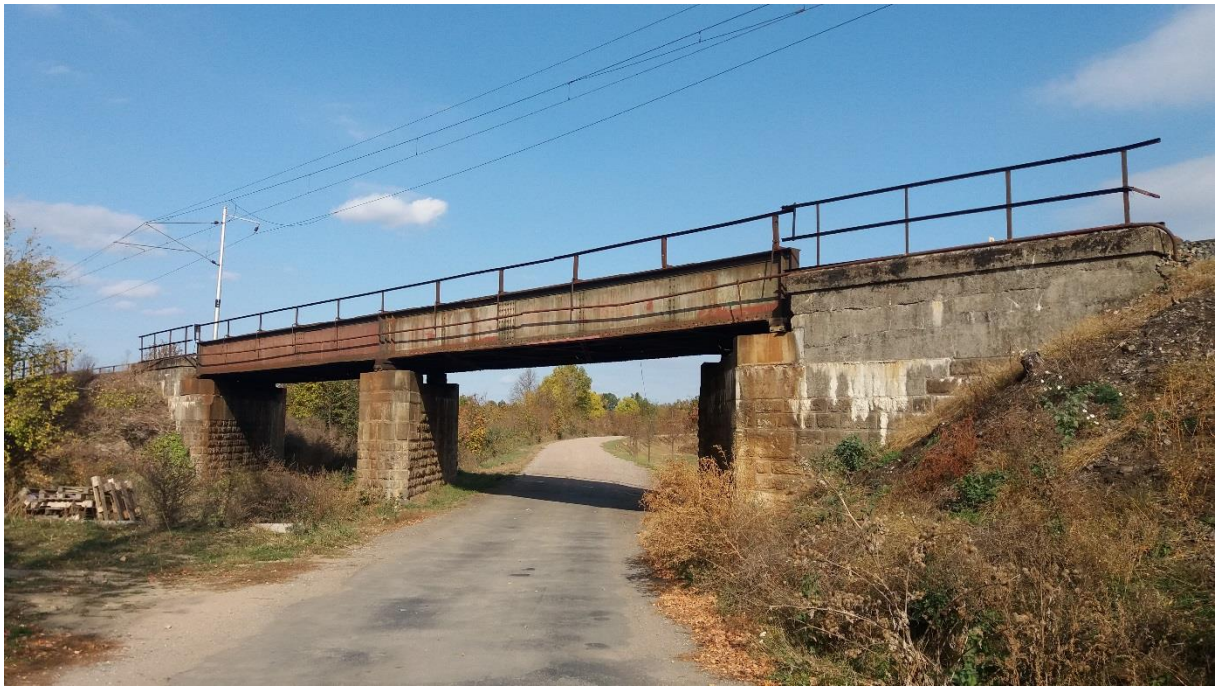
Obr. 1 – Boční pohled na objekt
