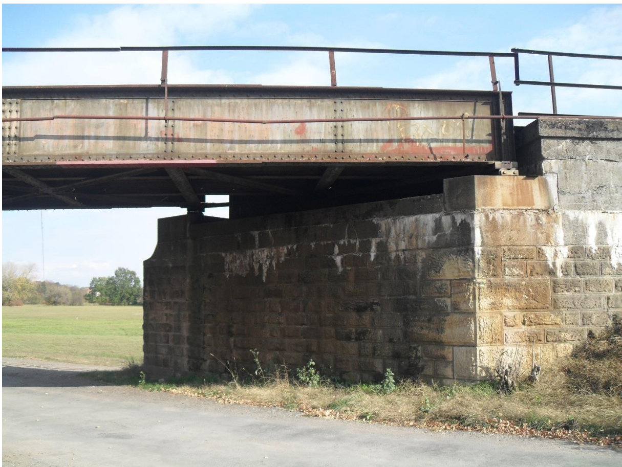
Obr. 2 – Detail opěry na hradecké straně
