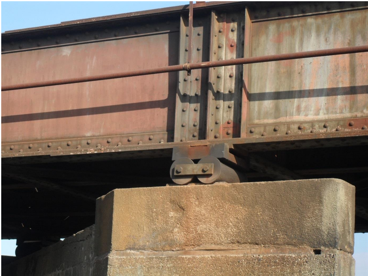
Obr. 12 – Detail pohyblivého ložiska na pilíři
