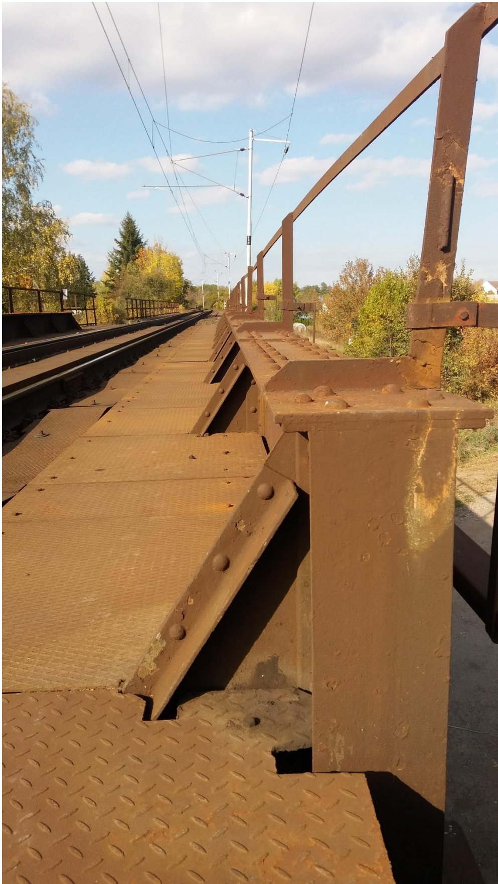
Obr. 11 – Detail příčných výztuh
