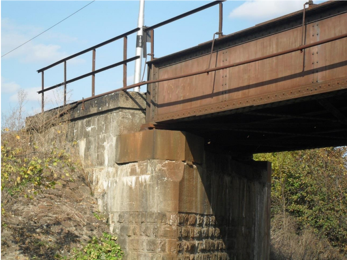
Obr. 4 – Detail úložného prahu na chlumecké opěře
