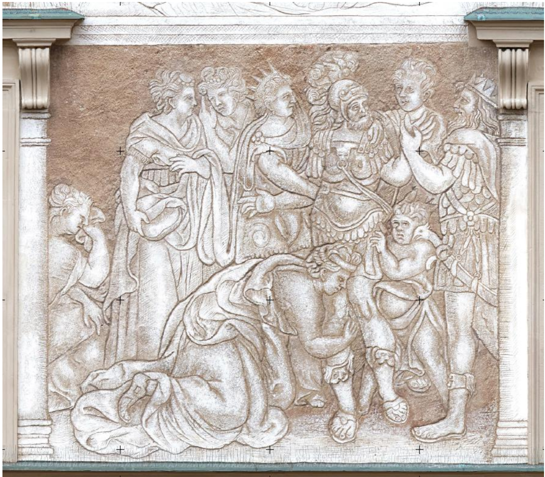
Obr. 2 - Výjev B5, stav po restaurování, výřez z fotogrammetrie – autor: Ing. Jiří Vidman.
