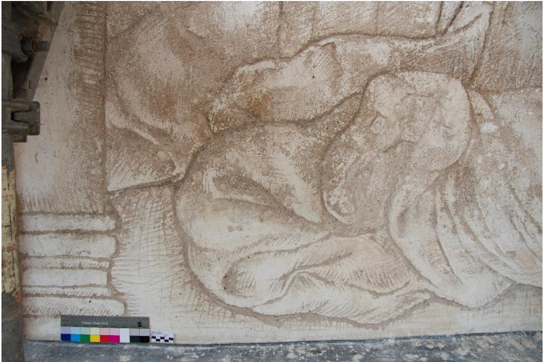
Obr. 20 - Spodní partie (draperie a sloup), levý úsek, výjev B5, stav po injektáži a čištění, denní světlo.
