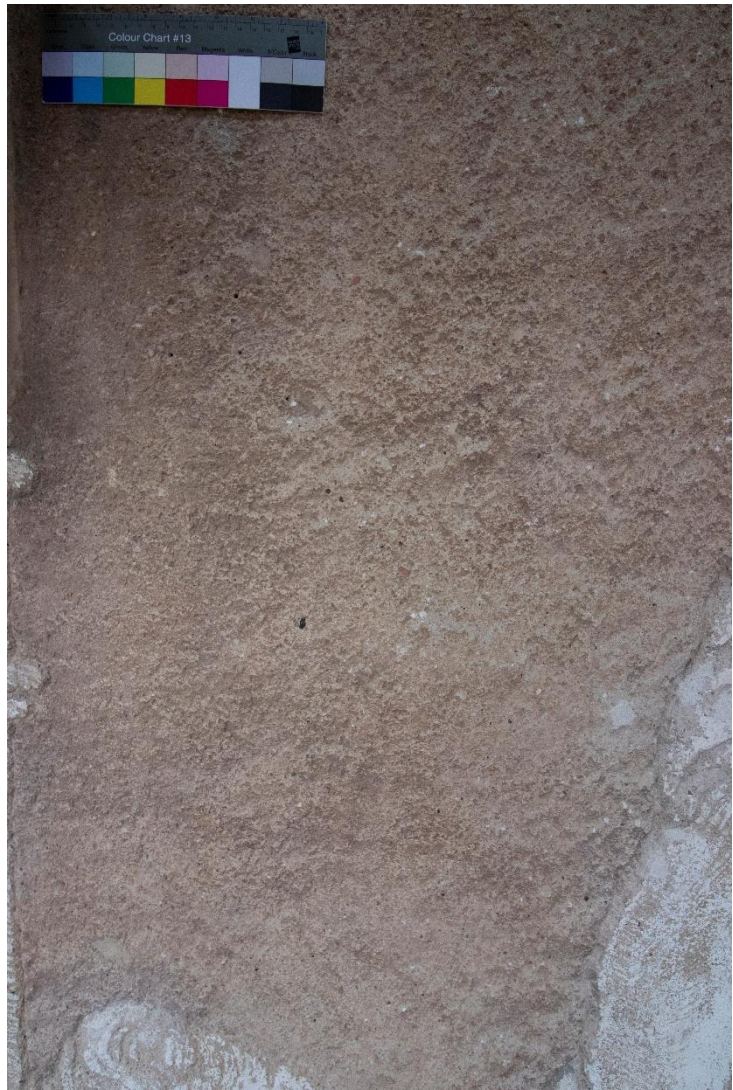
Obr. 25 - Horní partie (pozadí), levý úsek, výjev B5, stav po tmelení, denní světlo.
