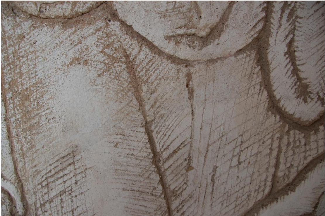
Obr. 8 - Ukázka druhotného zásahu – rozhraní rekonstrukce z 80. let a původní vrstvy intonaca, odlišná šrafura, stav před restaurováním, denní světlo.
