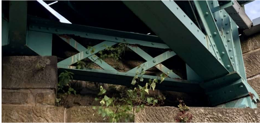
Obrázek 13: Šikmé ukončení nad opěrou O2 (viditelná část) – skutečný stav
