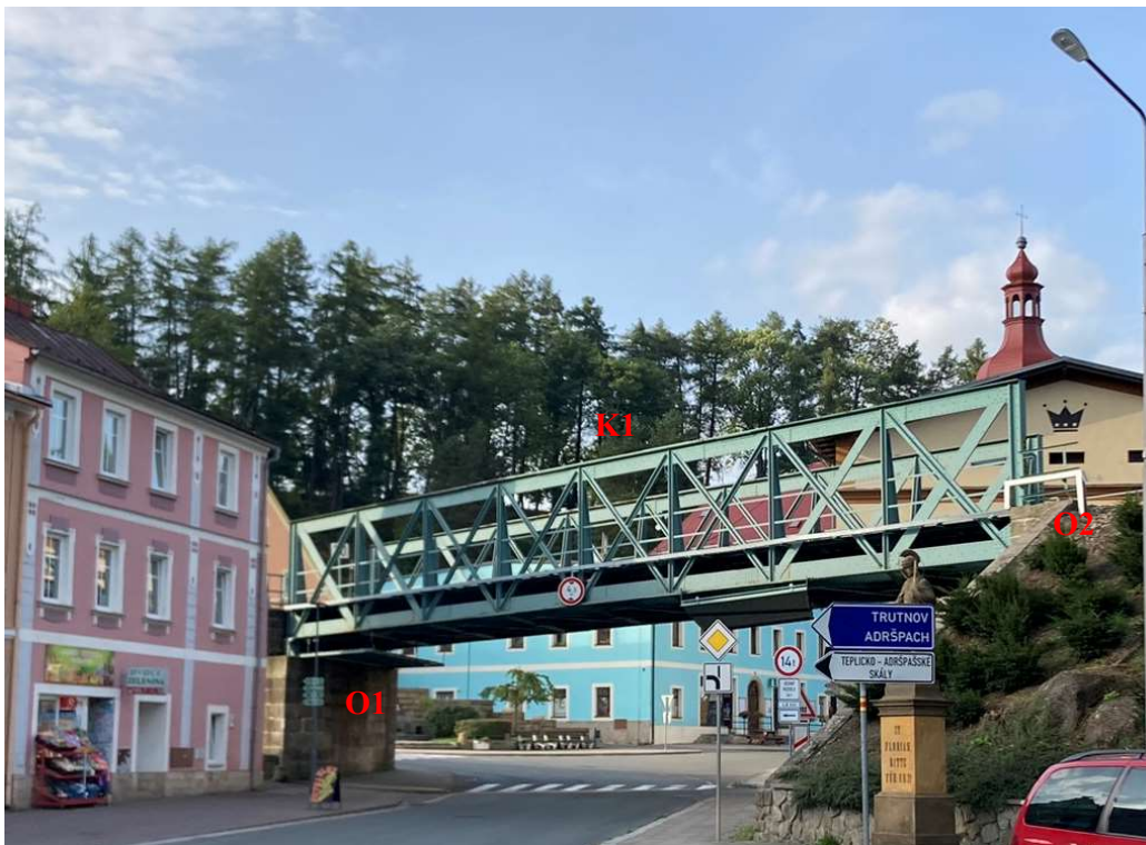
Obrázek 3: Posuzovaná mostní konstrukce (O1 a O2 opěry; K1 posuzovaná konstrukce)
