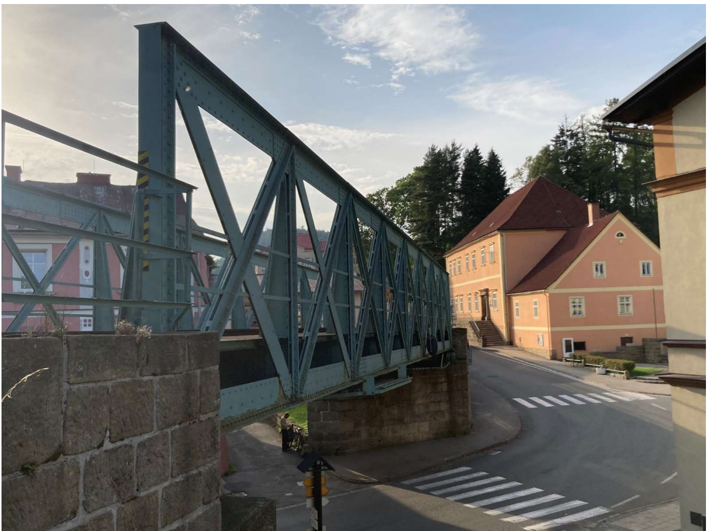
Obrázek 8: Boční pohled na mostní konstrukci [archiv autora]
