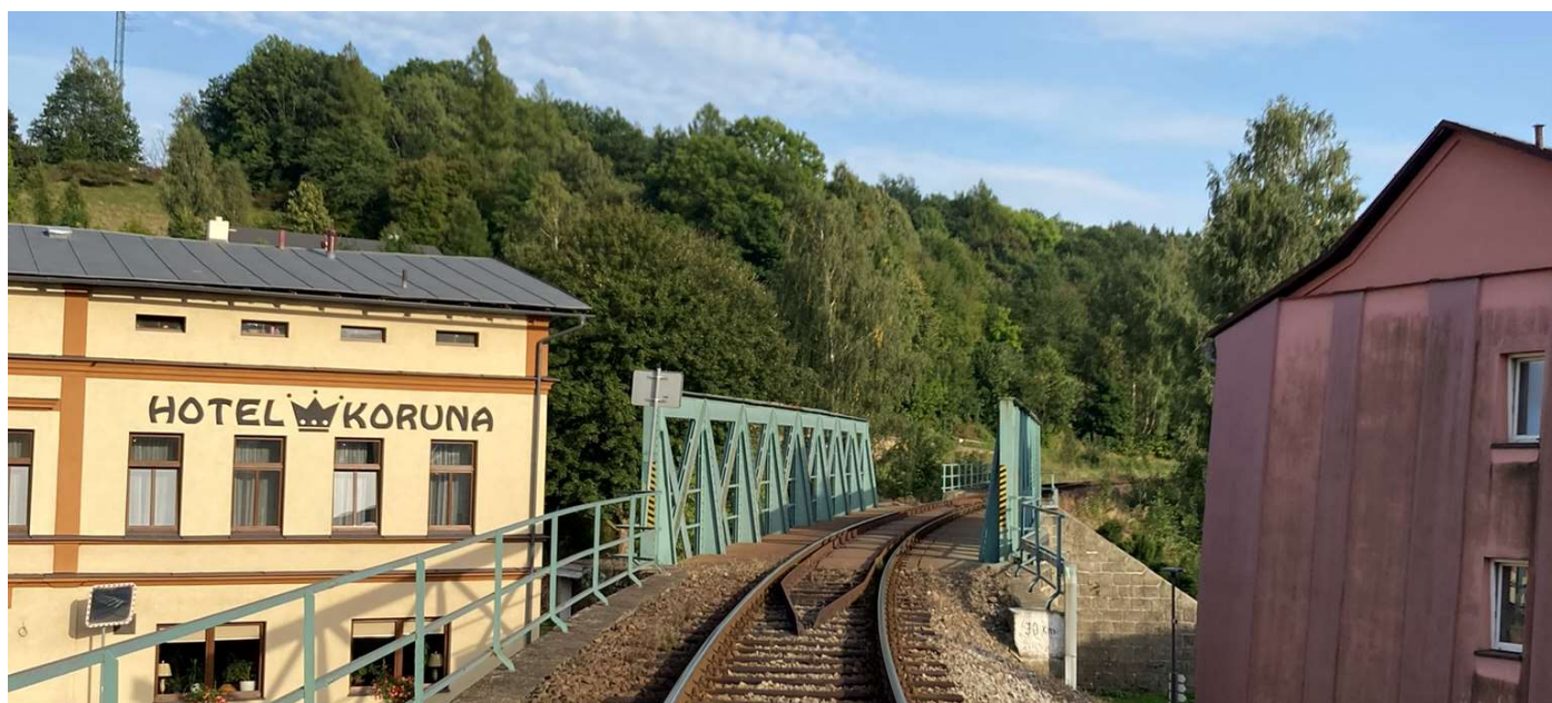
Obrázek 1: Pohled na mostní svršek [archiv autora]
