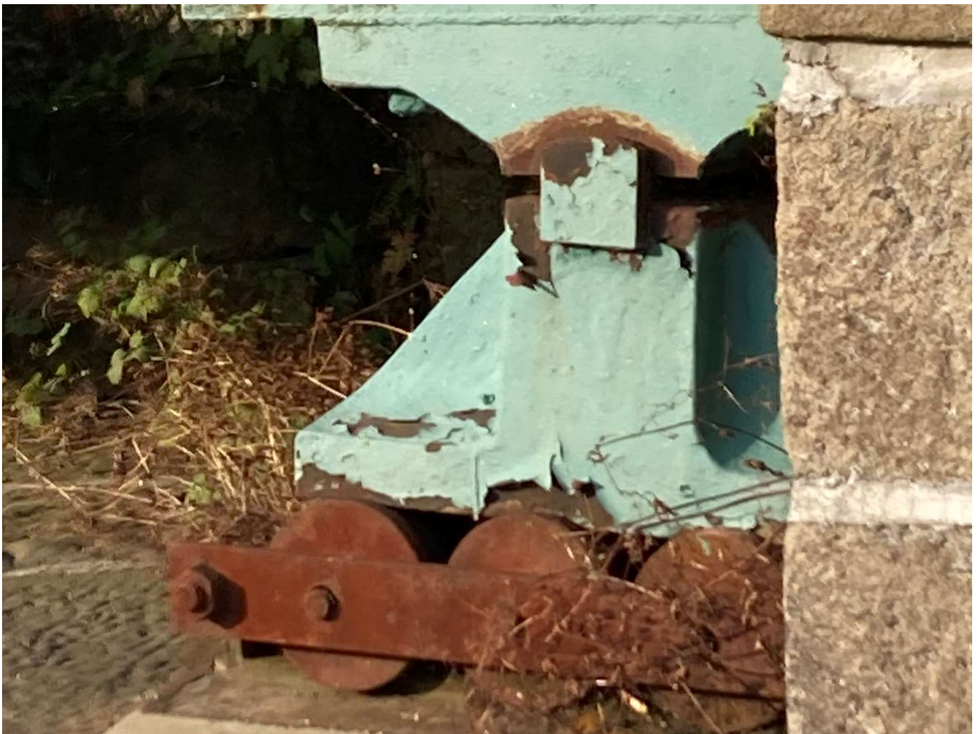
Obrázek 4: Detail pohyblivého ložiska na O2
