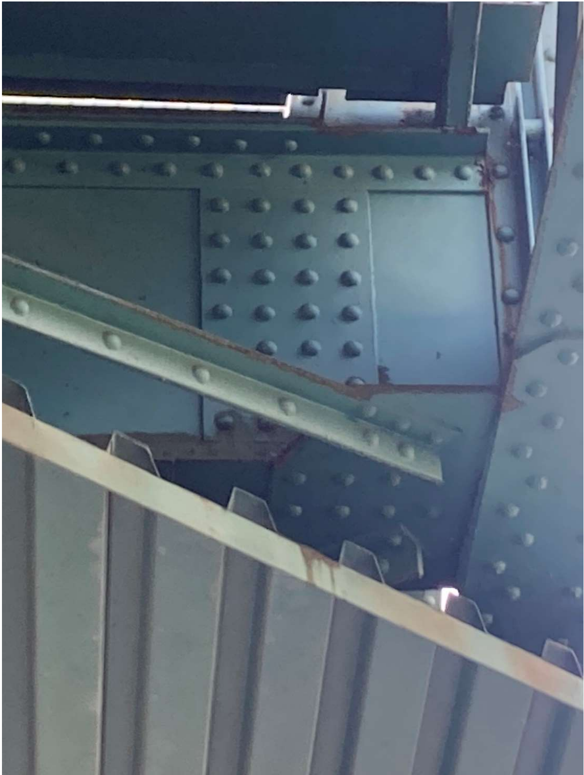
Obrázek 7: Detail napojení příčnicku [archiv autora]
