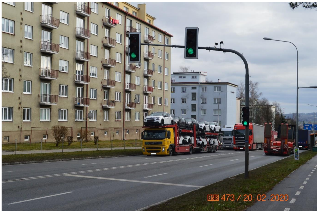
Obrázek 4 Zpomalovací světelné signalizační zařízení
