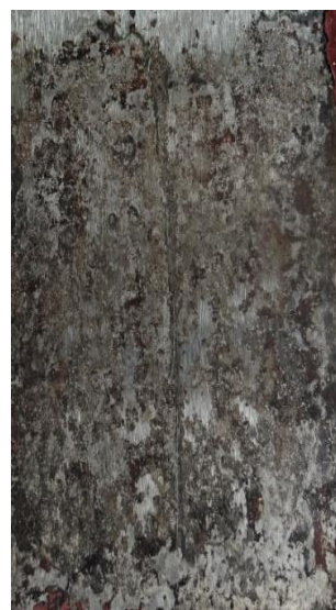
po odstranění nátěru
