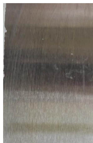
po odstranění nátěru
