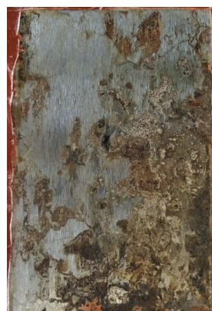
po odstranění nátěru
