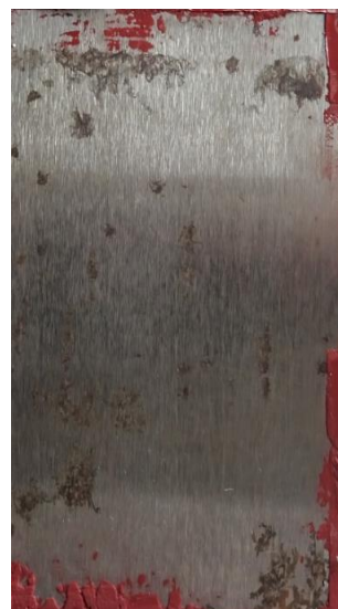
po odstranění nátěru
