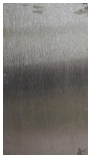
po odstranění nátěru
