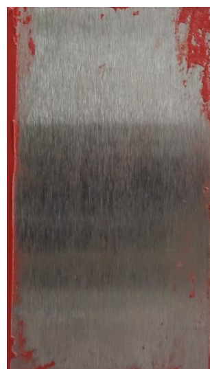
po odstranění nátěru
