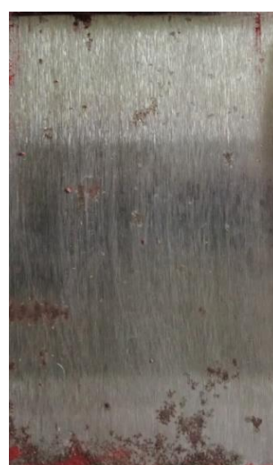
po odstranění nátěru
