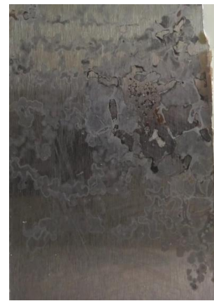
po odstranění nátěru
