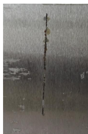
po odstranění nátěru
