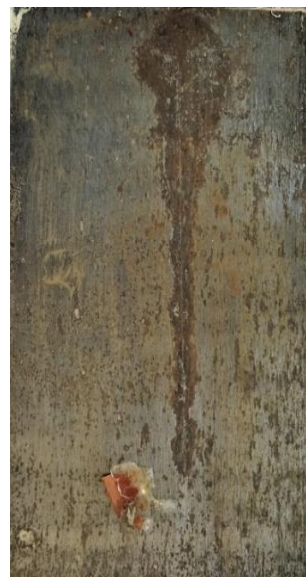
po odstranění nátěru
