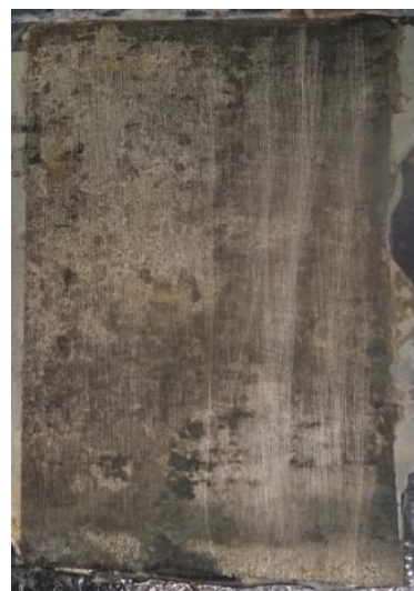
po odstranění nátěru
