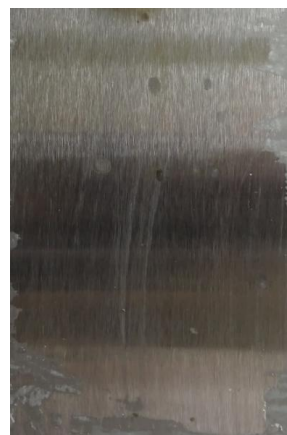
po odstranění nátěru
