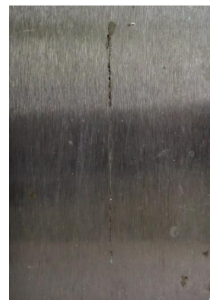
po odstranění nátěru
