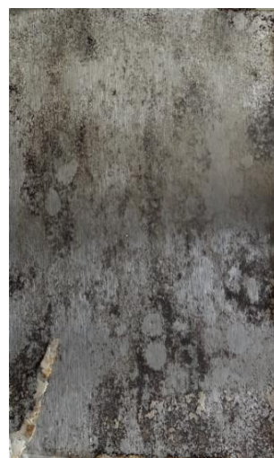
po odstranění nátěru
