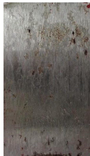
po odstranění nátěru
