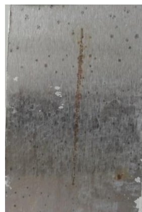
po odstranění nátěru
