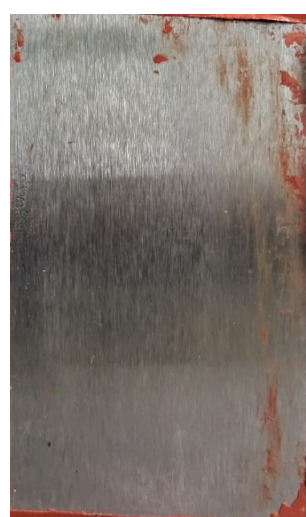
po odstranění nátěru
