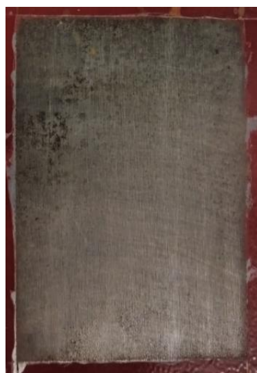
po odstranění nátěru
