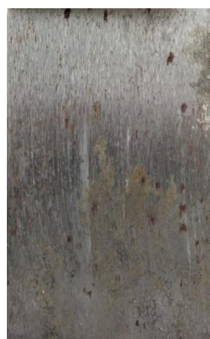
po odstranění nátěru
