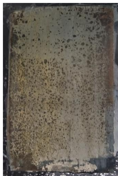
po odstranění nátěru
