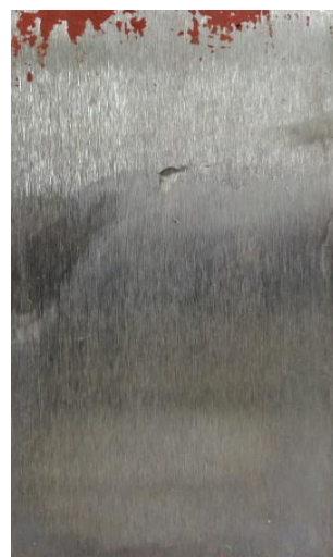
po odstranění nátěru
