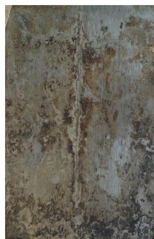
po odstranění nátěru
