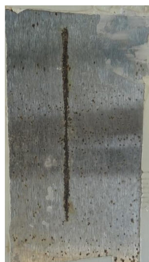
po odstranění nátěru
