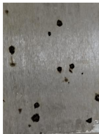
po odstranění nátěru
