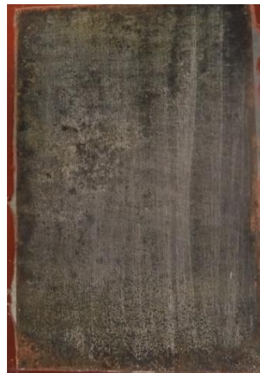
po odstranění nátěru
