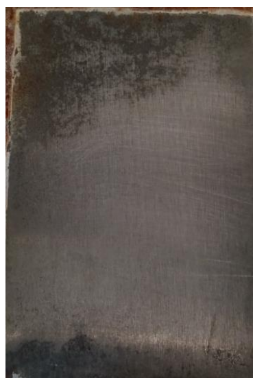
Po odstranění nátěru
