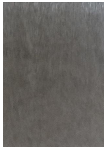
po odstranění nátěru
