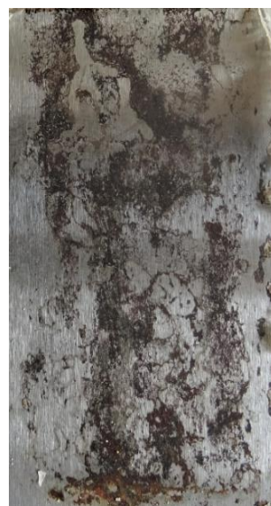
po odstranění nátěru
