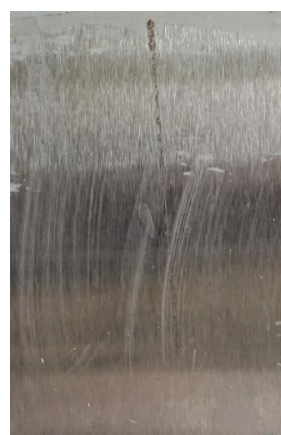
po odstranění nátěru
