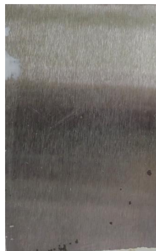
po odstranění nátěru
