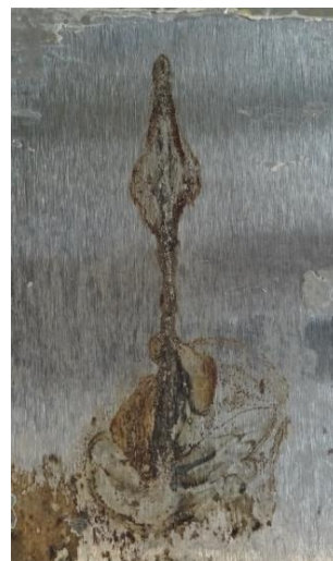
po odstranění nátěru
