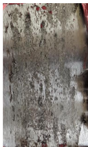
po odstranění nátěru
