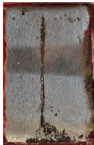
po odstranění nátěru
