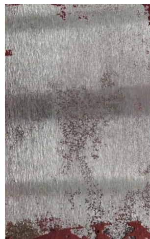
po odstranění nátěru
