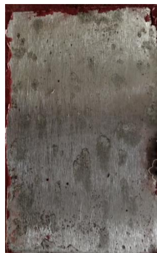
po odstranění nátěru
