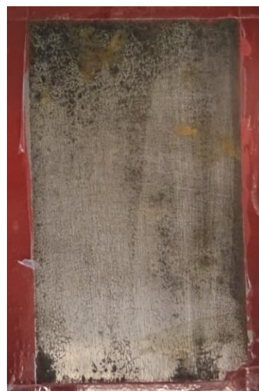
po odstranění nátěru
