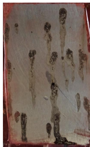
po odstranění nátěru
