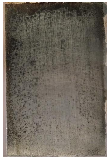
po odstranění nátěru
