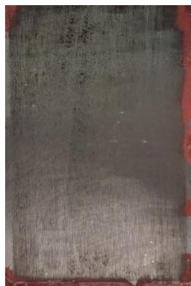
po odstranění nátěru
