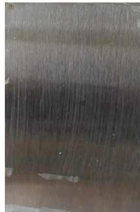
po odstranění nátěru
