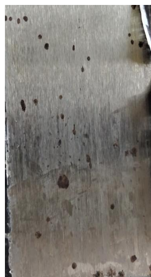
po odstranění nátěru
