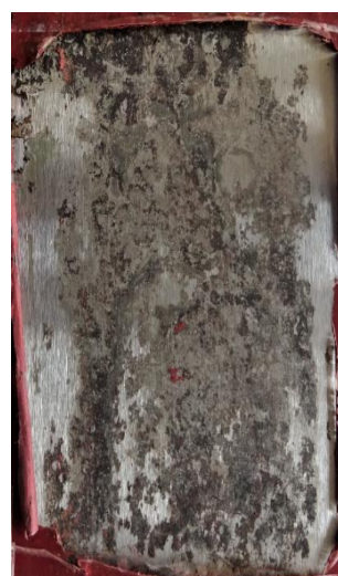
po odstranění nátěru
