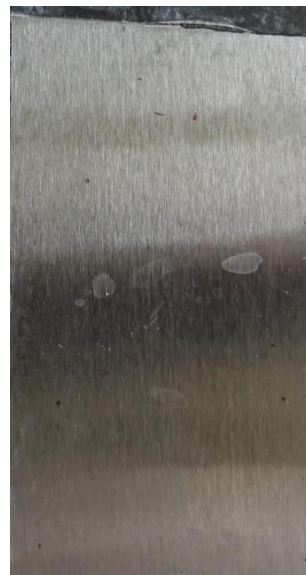
po odstranění nátěru
