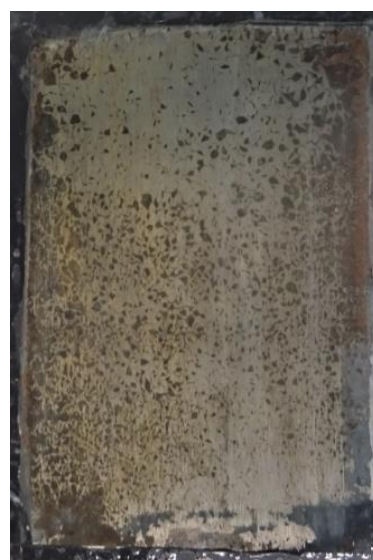
po odstranění nátěru
