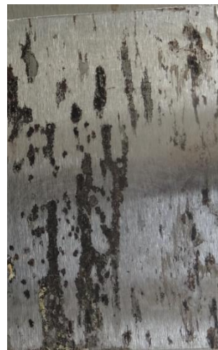
po odstranění nátěru
