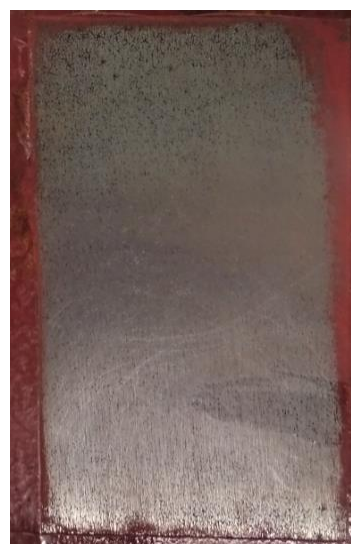
po odstranění nátěru
