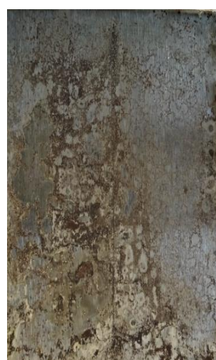
po odstranění nátěru
