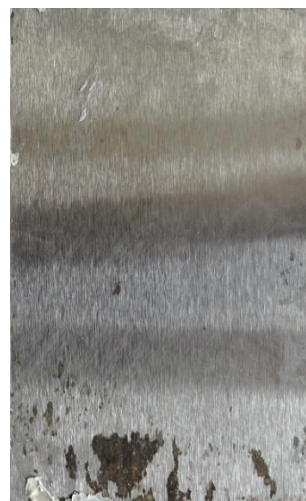
po odstranění nátěru
