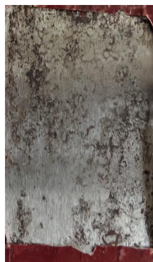
po odstranění nátěru
