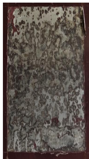
po odstranění nátěru
