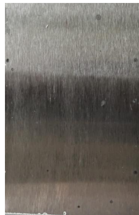
po odstranění nátěru
