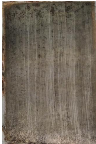
Po odstranění nátěru
