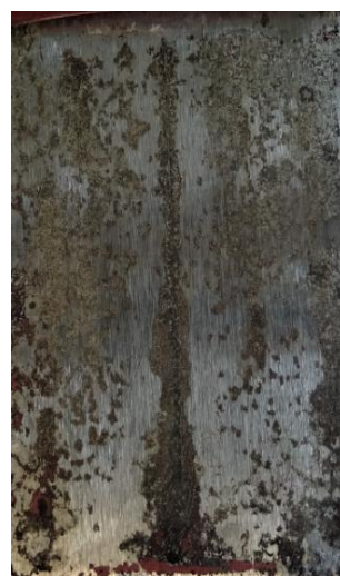
po odstranění nátěru
