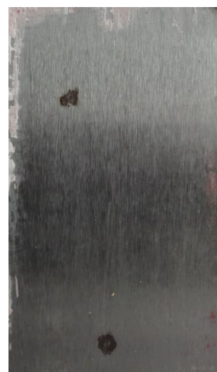
po odstranění nátěru
