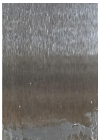
Po odstranění nátěru
