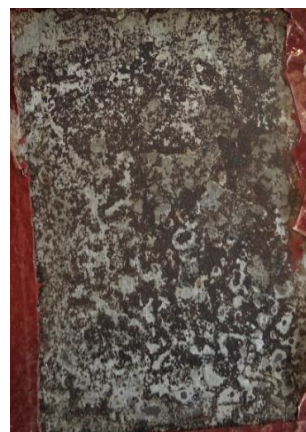
po odstranění nátěru
