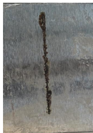
po odstranění nátěru
