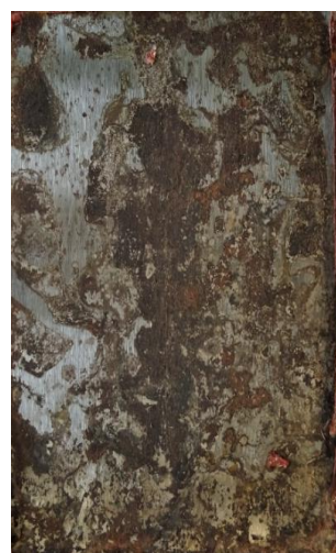
po odstranění nátěru
