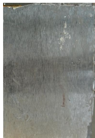
po odstranění nátěru
