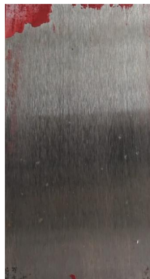
po odstranění nátěru
