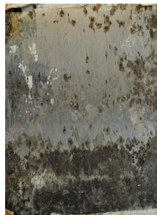
po odstranění nátěru
