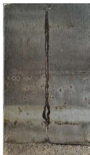
po odstranění nátěru
