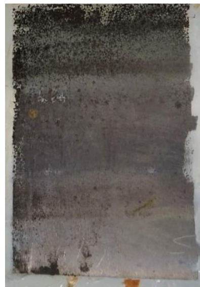
po odstranění nátěru
