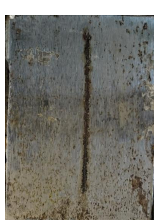
po odstranění nátěru
