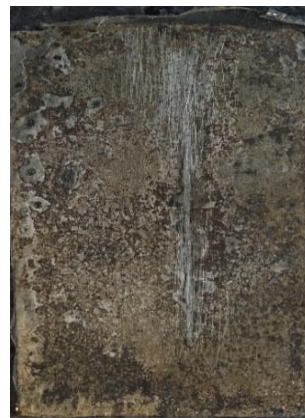
po odstranění nátěru
