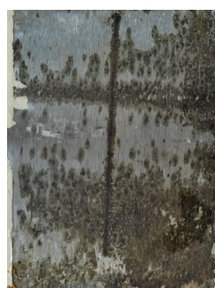
po odstranění nátěru
