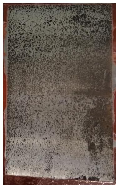
po odstranění nátěru
