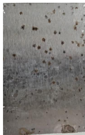
po odstranění nátěru
