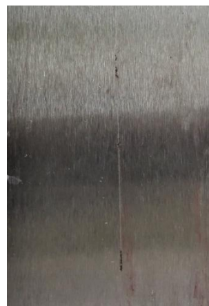
po odstranění nátěru
