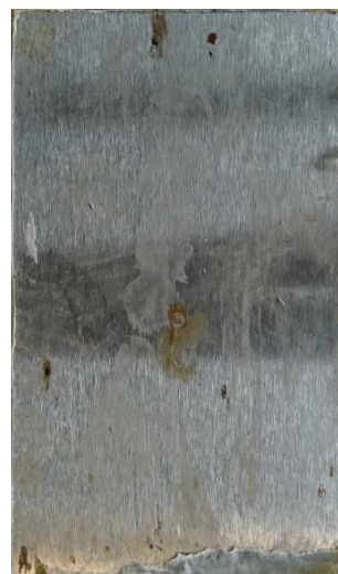
po odstranění nátěru
