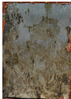
po odstranění nátěru
