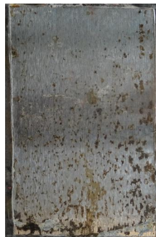
po odstranění nátěru
