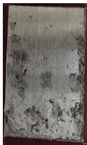
po odstranění nátěru
