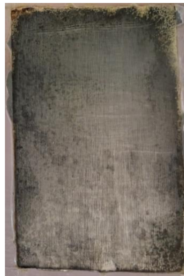
Po odstranění nátěru
