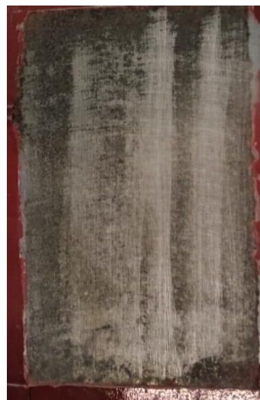
po odstranění nátěru
