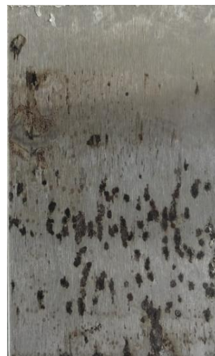
po odstranění nátěru
