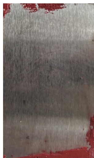
po odstranění nátěru
