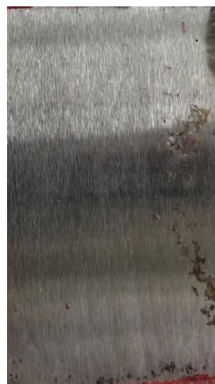
po odstranění nátěru
