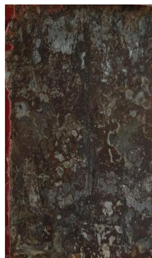
po odstranění nátěru
