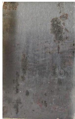
po odstranění nátěru
