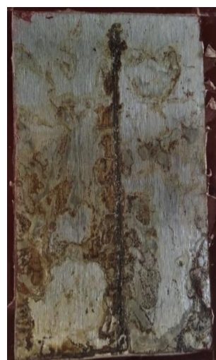
po odstranění nátěru
