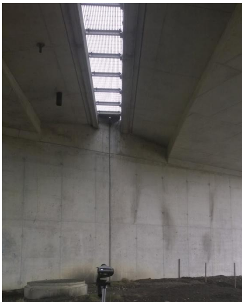
Obrázek č. 23 - Rošt na podchodu Chýšť spolu s jednou ze tří studní
