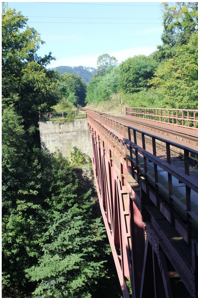
Obrázek 14 – Pohled na připravenou opěru pro přemostění v rámci druhé koleje.
