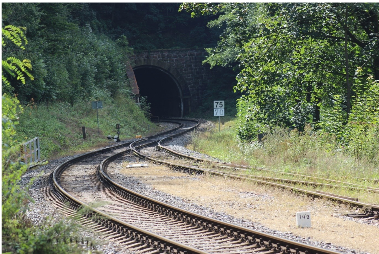
Obrázek 17 – Pohled na portál litického tunelu směrem na Douleby nad Orlicí
