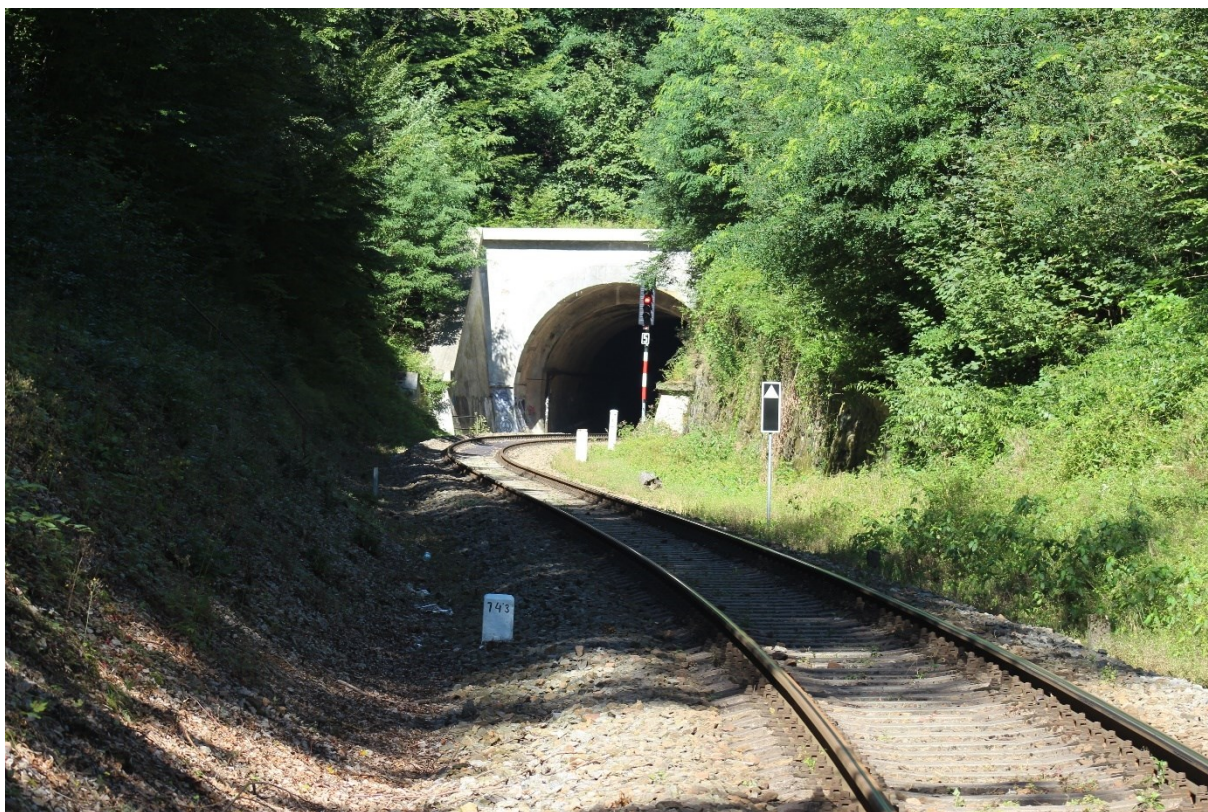
Obrázek 16 – Pohled na portál litického tunelu směr Letohrad
