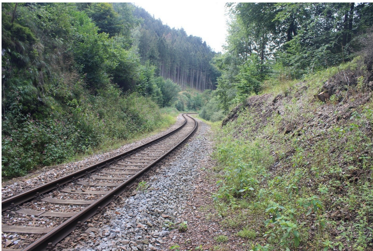
Obrázek 20 – Pohled na úsek ve skalních zářezech
