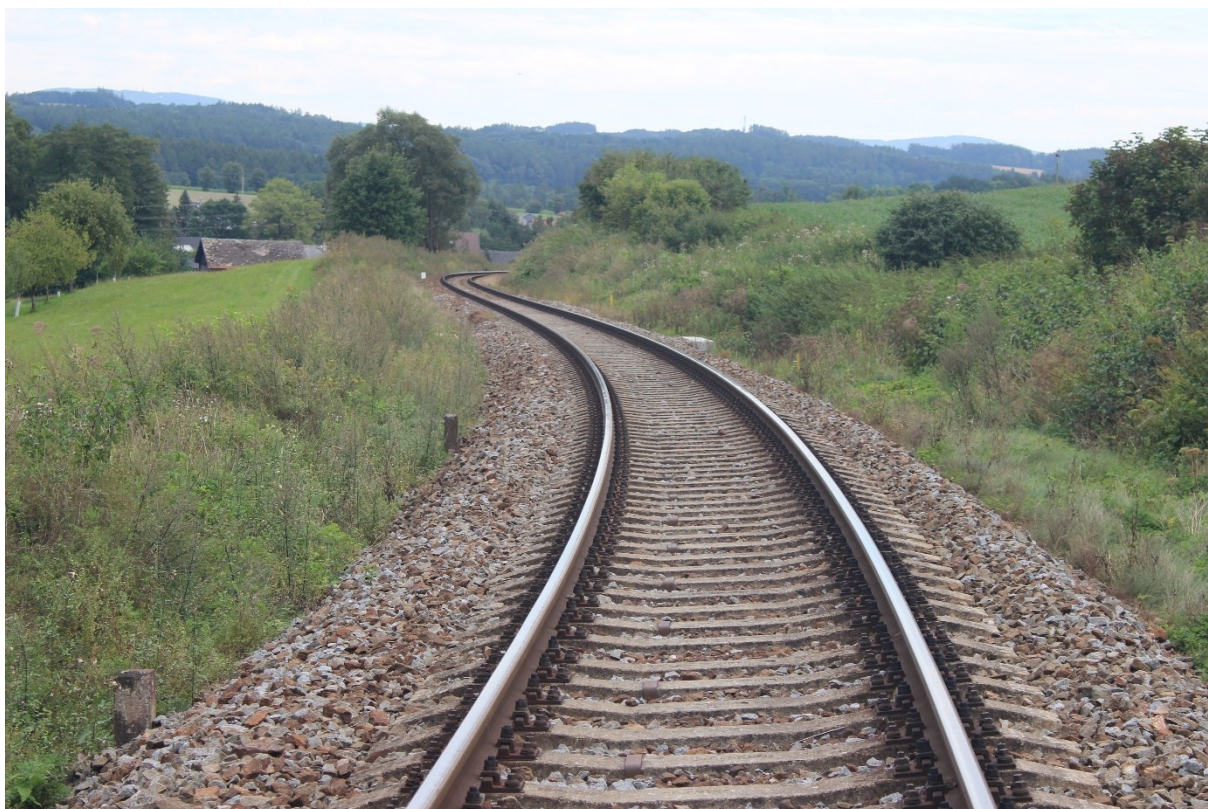
Obrázek 27 – Pohled na protisměrné oblouky před železniční stanicí Lukavice v Čechách
