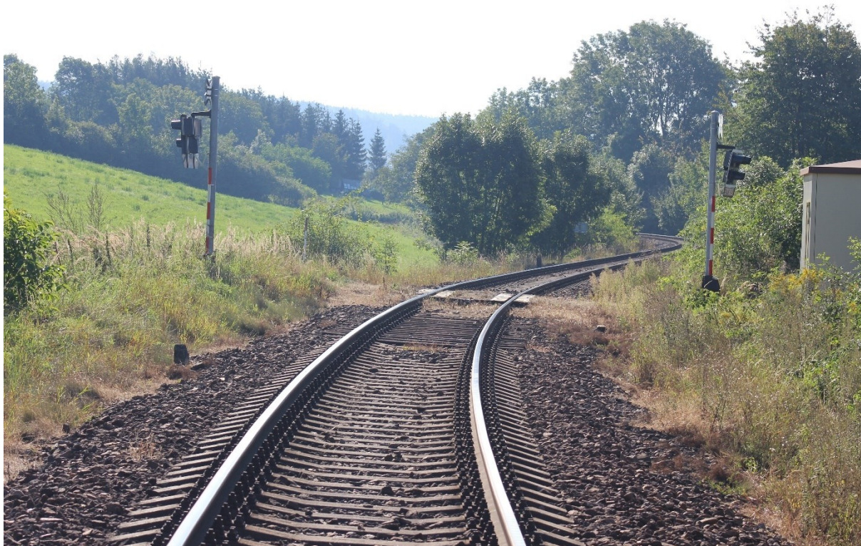
Obrázek 6 – Pohled na protisměrné oblouky a železniční přejezd v km 66,75
