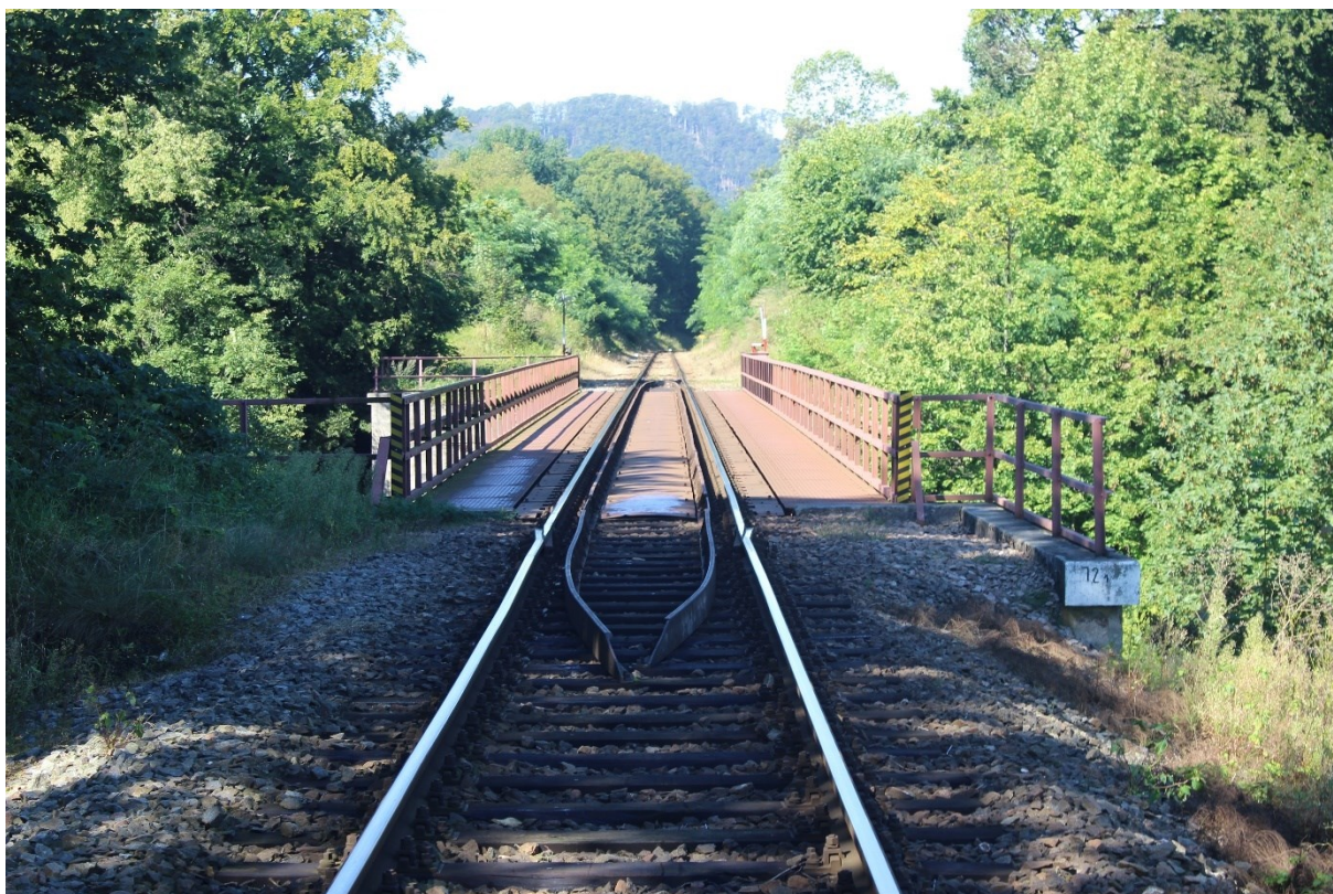
Obrázek 13 – Pohled na železniční most přes Divokou Orlici směr Doudleby nad Orlicí
