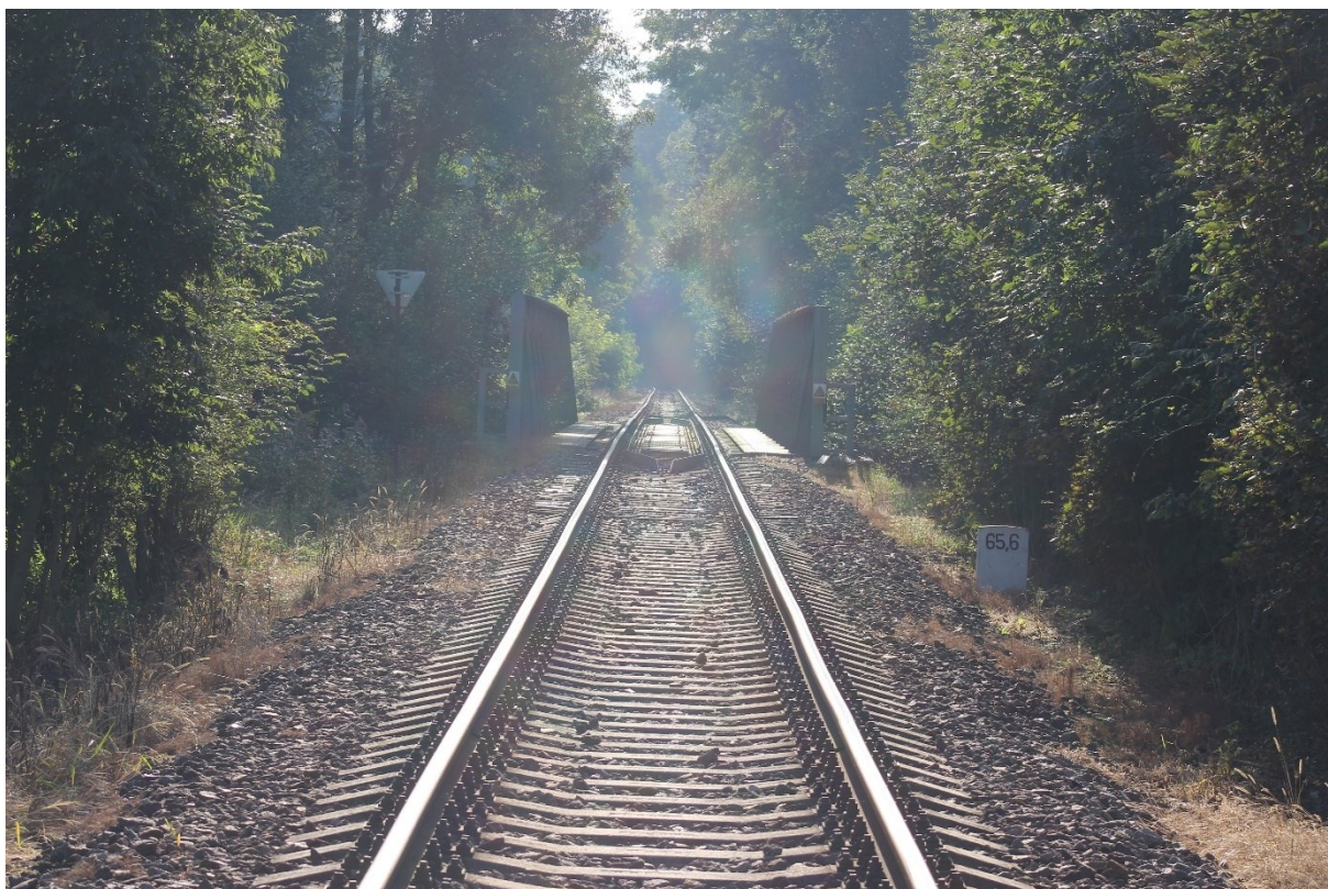
Obrázek 3 – Pohled na ocelový příhradový most ve směru na Letohrad
