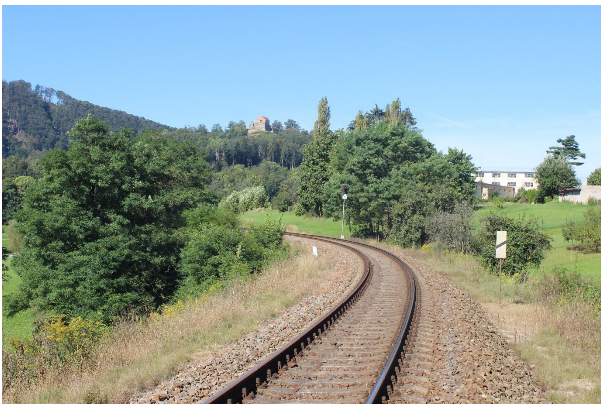
Obrázek 11 – Pohled na směrový oblouk pod zříceninou hradu Potštejn
