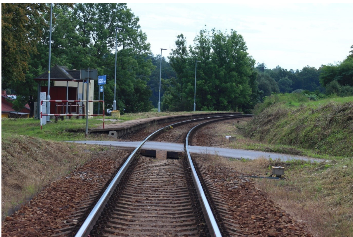
Obrázek 28 – Pohled na železniční stanici Lukavice v Čechách směrem na Letohrad
