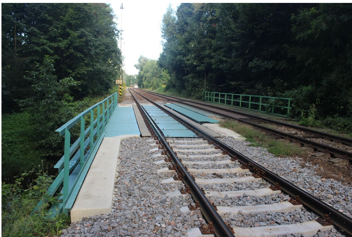
Obrázek 2 – Pohled směrem na začátek stanice Doudleby nad Orlicí
