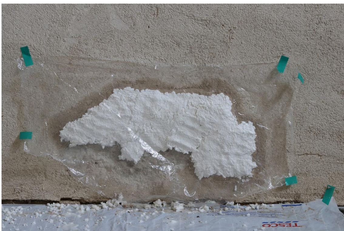
28. Východní stěna presbytáře, severní strana, spodní část – zábal s uhličitanem amonným.
