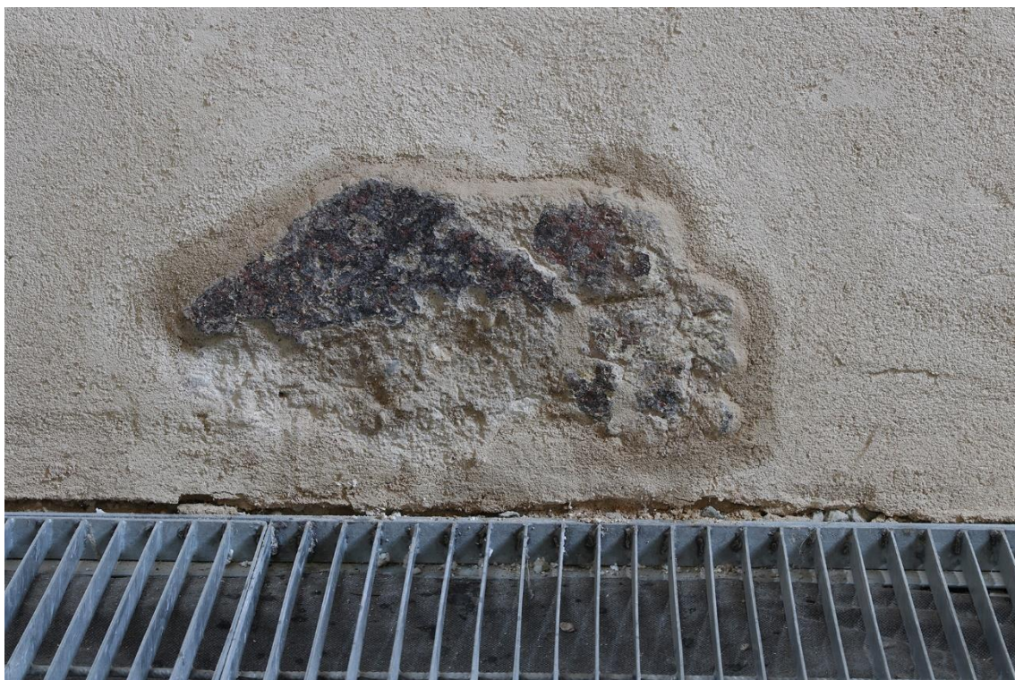
29. Východní stěna presbytáře, severní strana, spodní část – stav po čištění zábalem s uhličitanem amonným.
