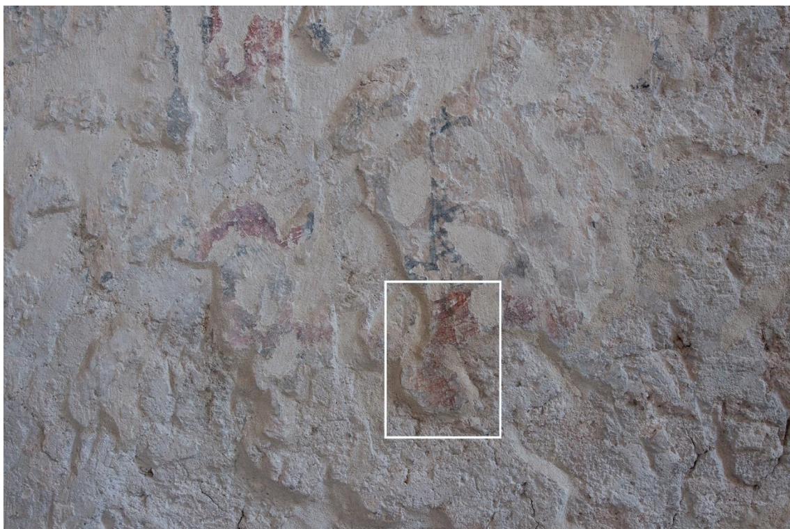
19. Východní stěna presbytáře, severní kout, střední část dolního pásu s postavami – výsledek zkoušky čištění vodou.
