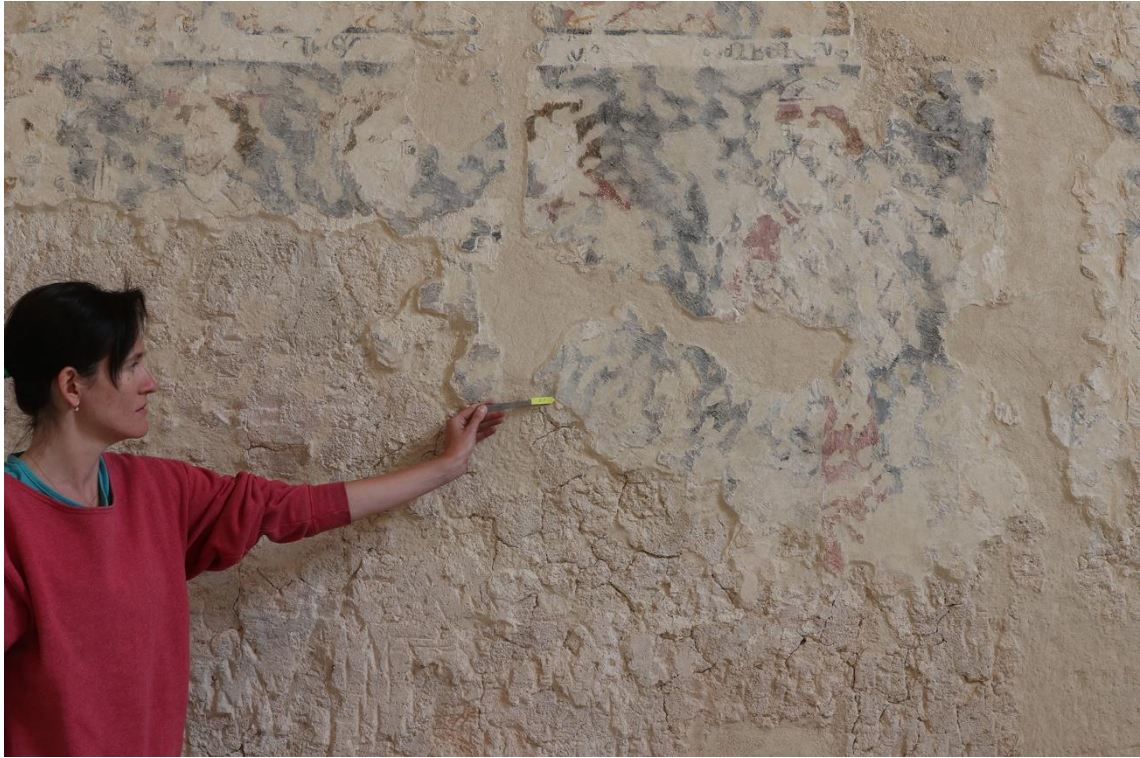
8. Označení místa odběru vzorku Z1 na východní stěně presbytáře.
