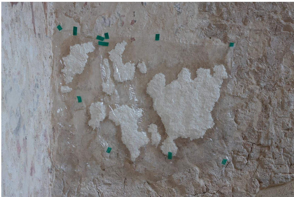
30. Východní stěna presbytáře, severní kout, spodní část dolního pásu s postavami – zábaly s uhličitanem amonným.
