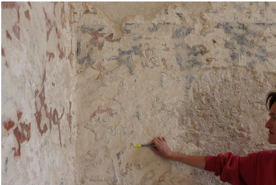
10. Označení místa odběru vzorku Z2 na východní stěně presbytáře.
