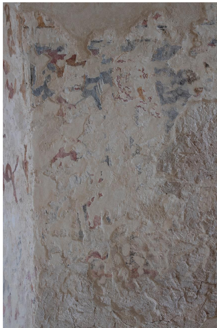
32. Severní část východní stěny presbytáře s dvojicí postav – stav po čištění a retuši.
