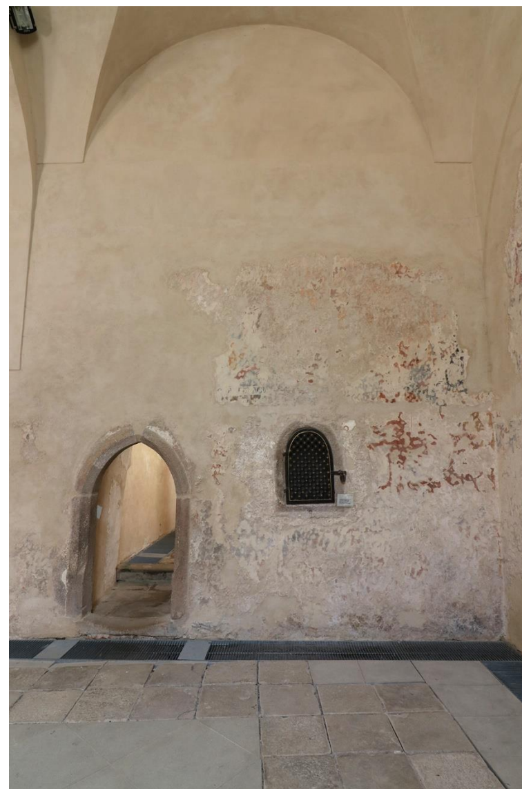
3. Pohled na severní stěnu presbytáře kostela sv. Víta v Zahradce
