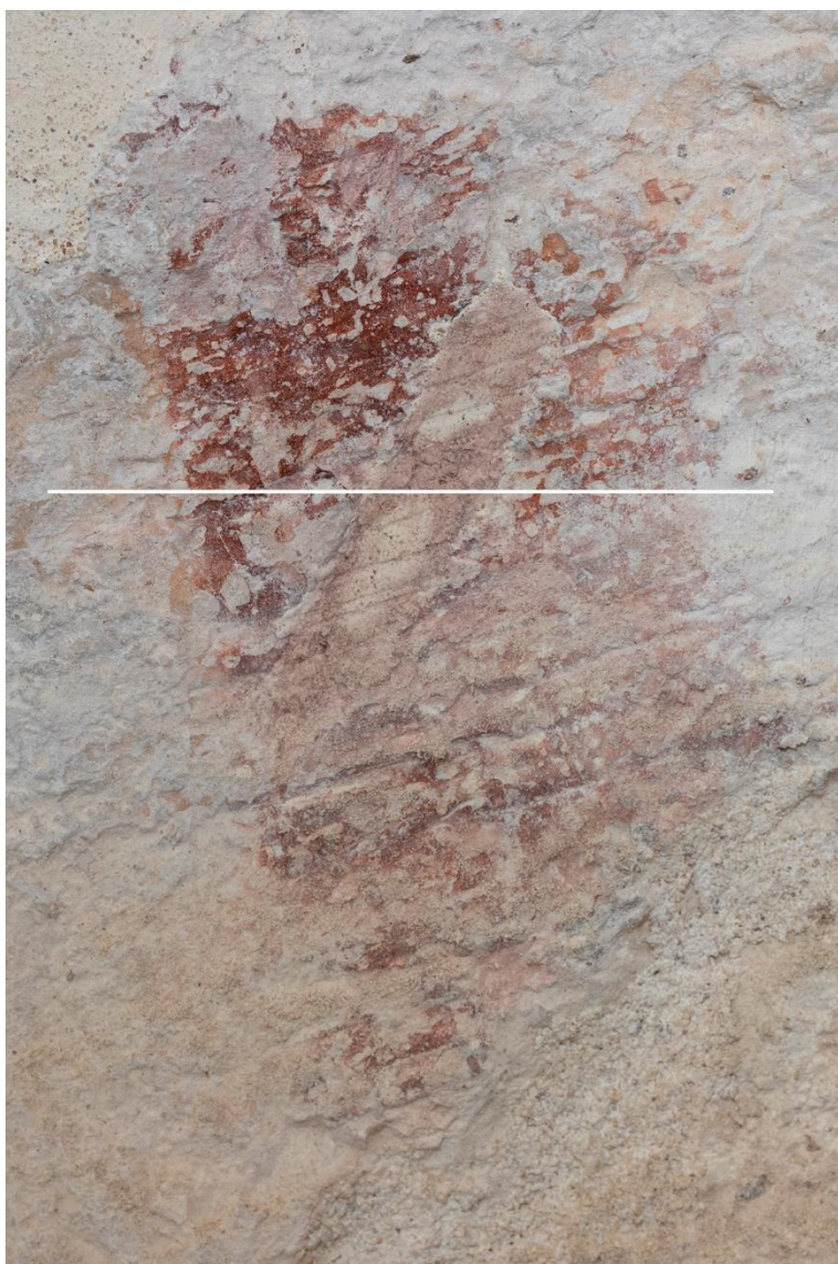
12. Severní stěna presbytáře – zkouška mechanického čištění.
