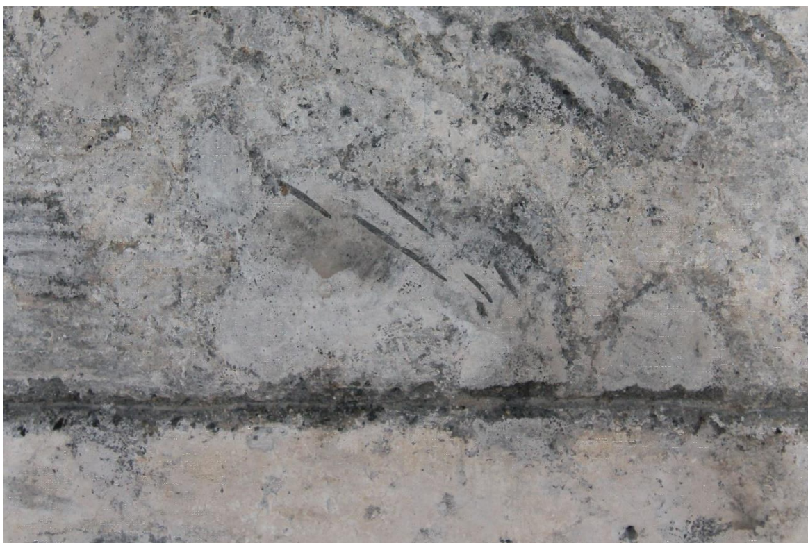
Obr. 28. Detail druhotného tmelu v oblasti originálu s pekáním, stav před restaurováním. Na tmelu je zřetelně vidět nahrazení ryté šrafury štětcovou malbou. Na fotografii je také dobře vidět rozdíl v tónu bílého nátěru mezi druhotnými doplňky.
