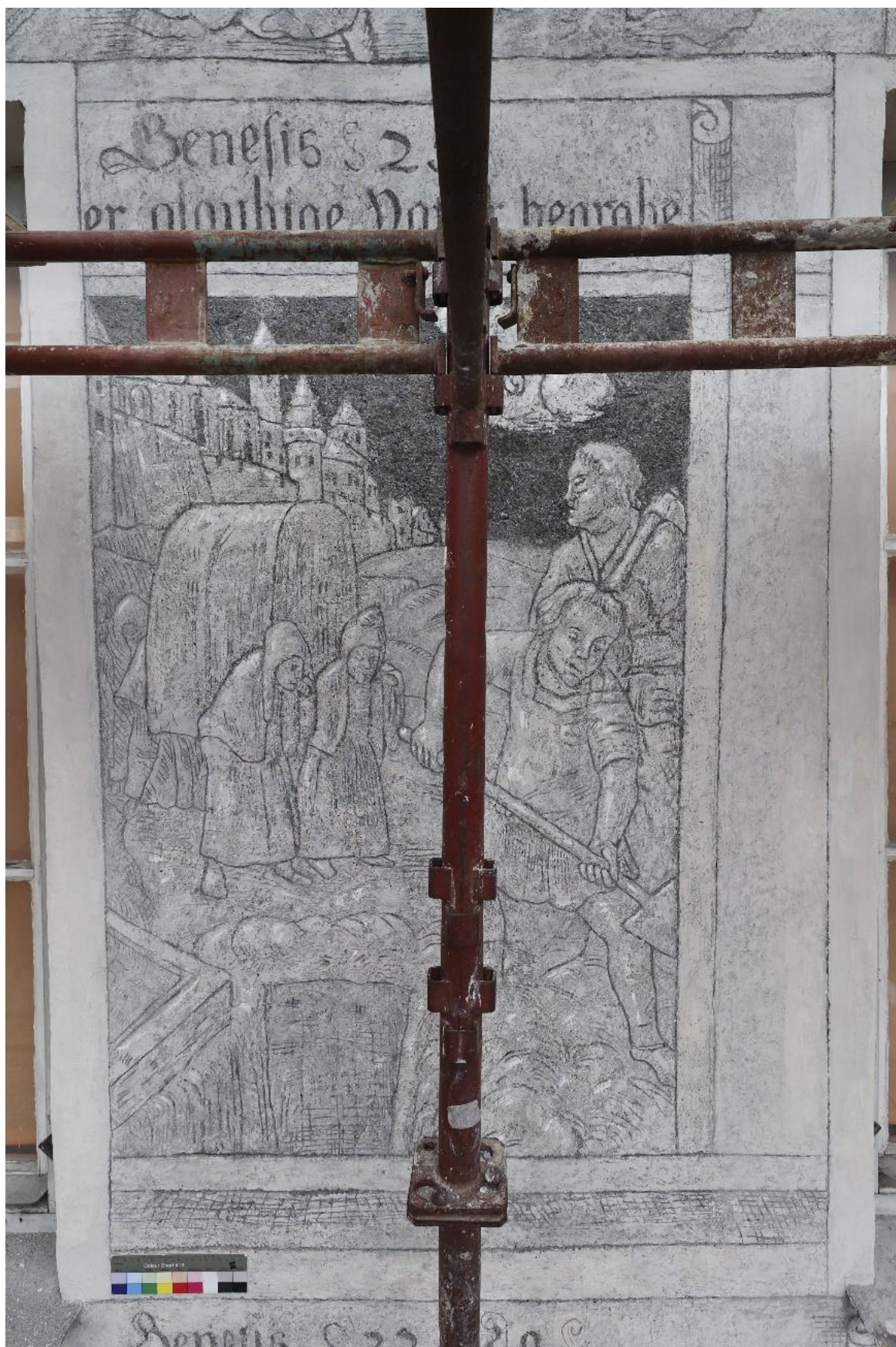
Obr. 70. Stav po restaurování.
