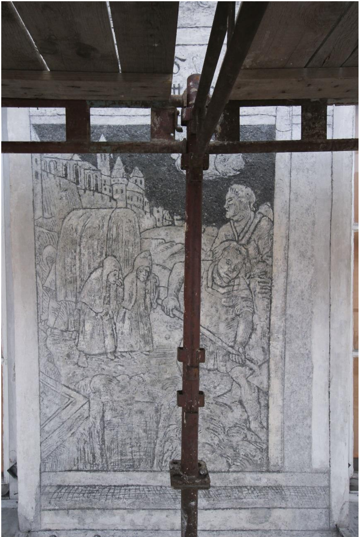
Obr. 67. Stav před restaurováním.
