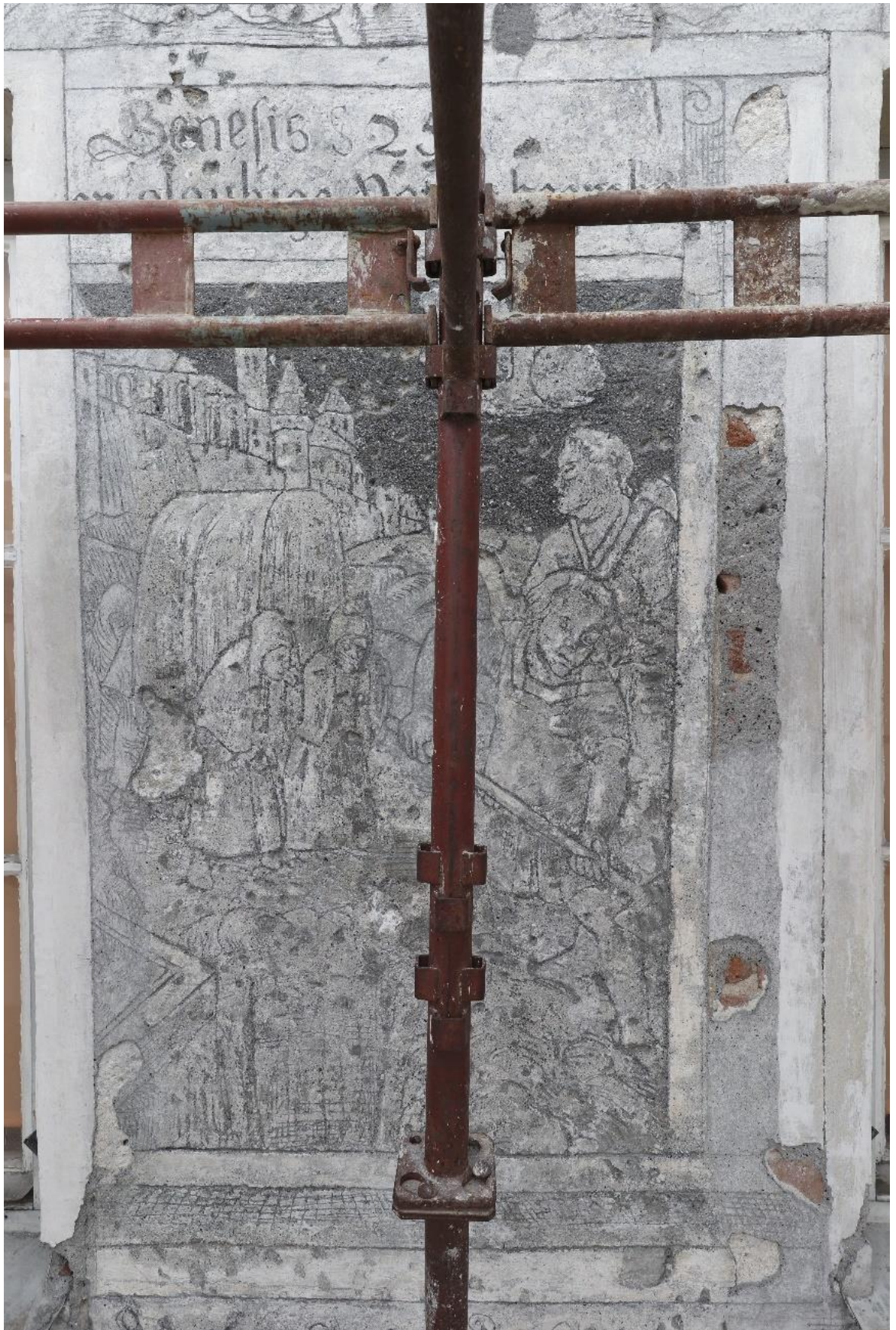
Obr. 68. Stav po odstranění nevhodných tmelů.
