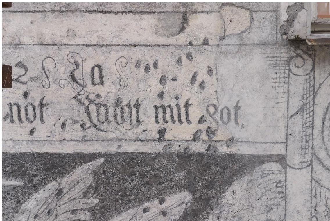
Obr. 40. Detail výjevu č 32, stav v průběhu odstraňování nevyhovujících tmelu.
