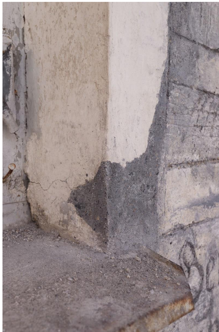
Obr. 44. Nahrazení starého nevhodného tmelu novým v oblasti okenního ostění výjevu č. 25.
