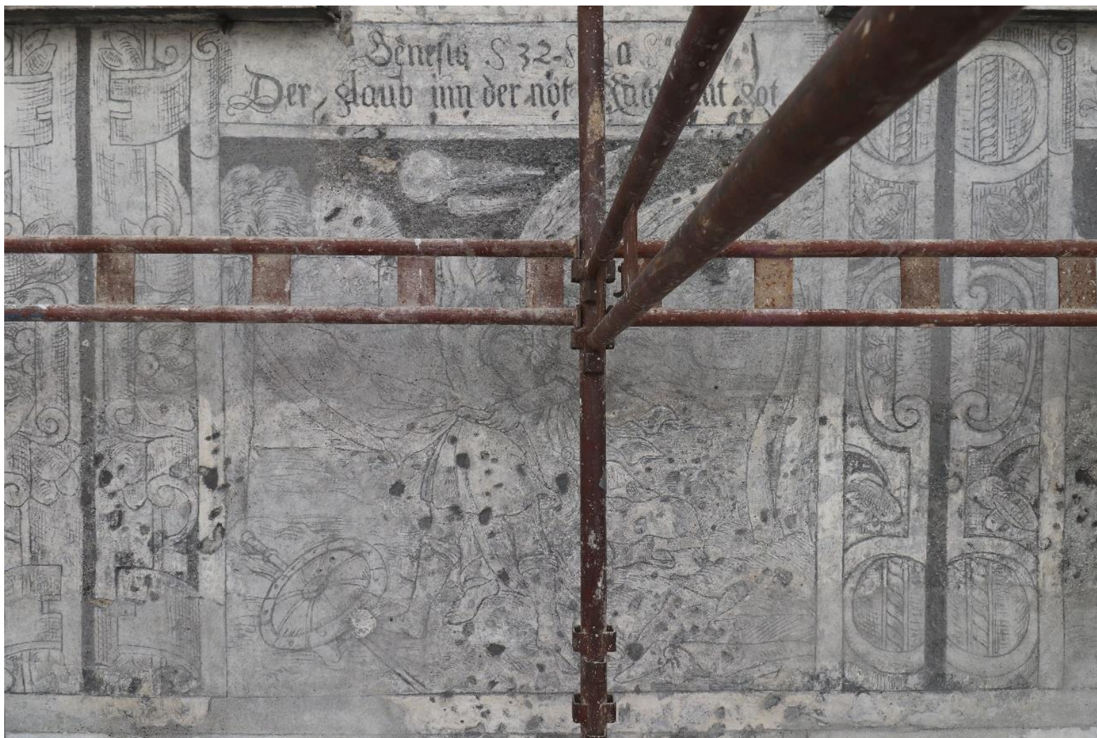
Obr. 72. Stav po odstranění nevhodných tmelů a provedení strukturální konsolidace.
