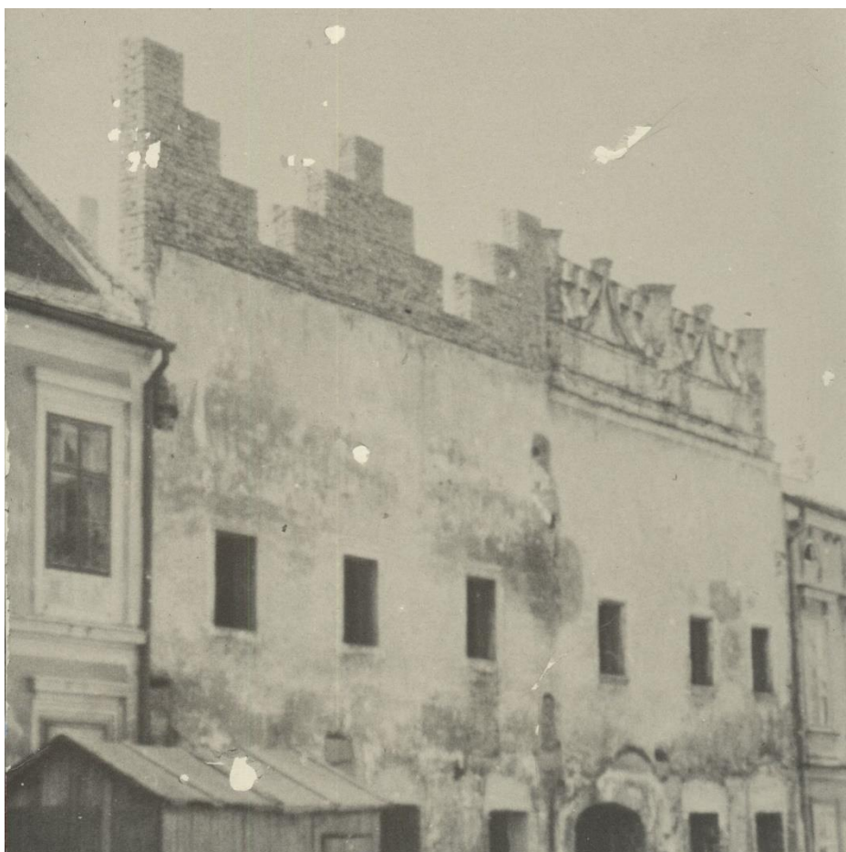
Obr. 8. Fotografie částečně zachycuje průčelí domu čp. 537 v během výstavby nového atikového štítu. Fotografie pochází přibližně z roku 1953 Zdroj: fotoarchiv města Slavonice, Městský úřad
