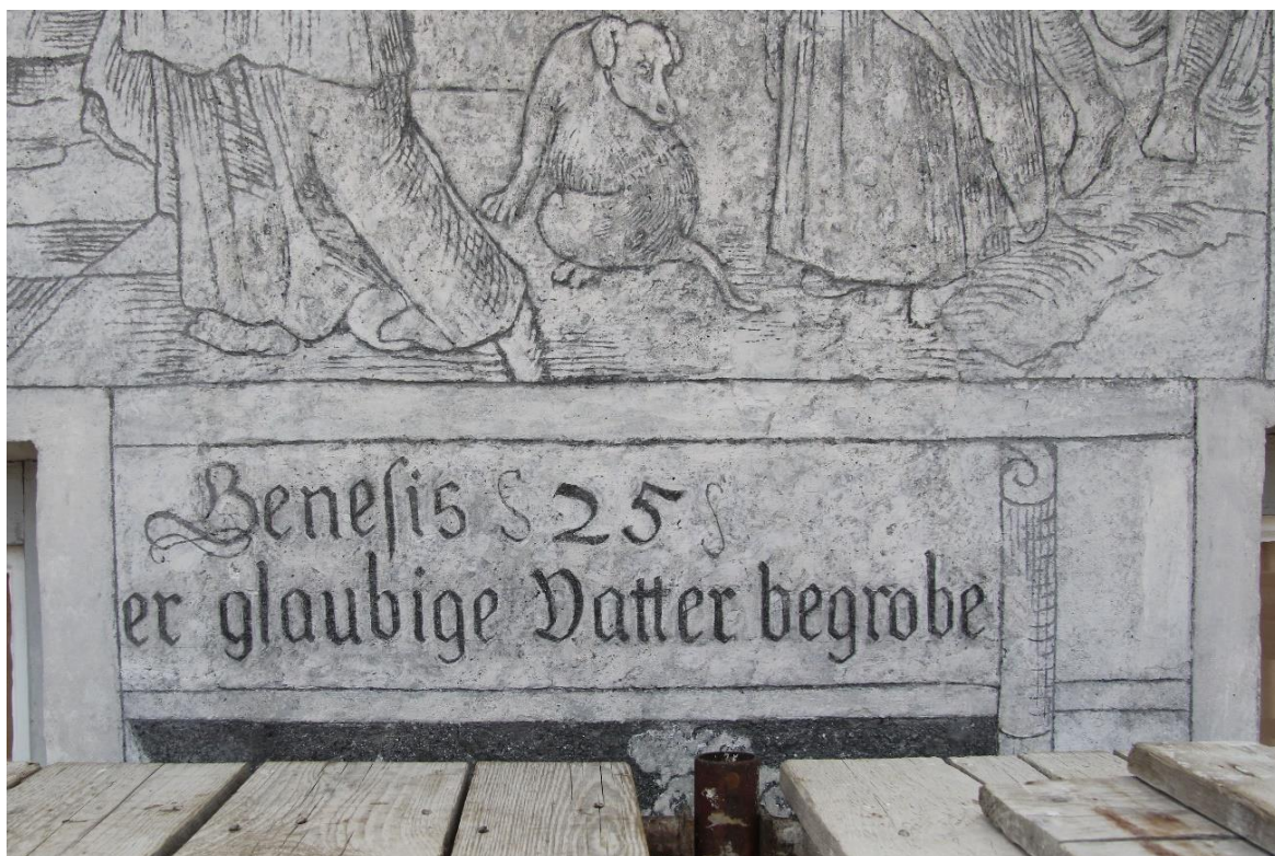
Obr. 64. Stav před restaurováním.
