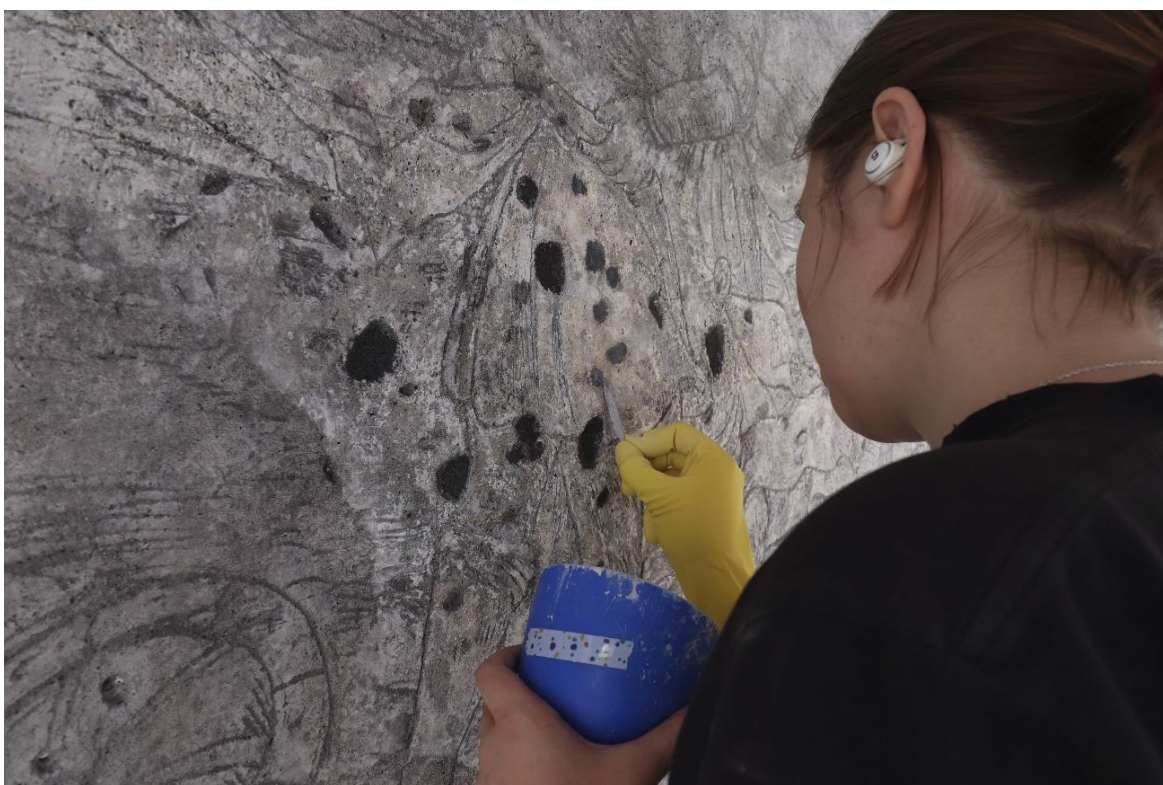
Obr. 46. Pracovní fotografie v průběhu tmelení
