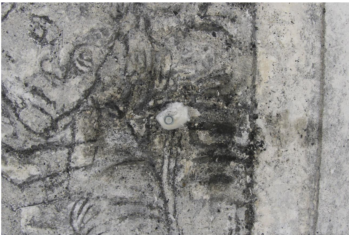
Obr. 36. Detail výjevu č. 25, stav v průběhu injektáže.
