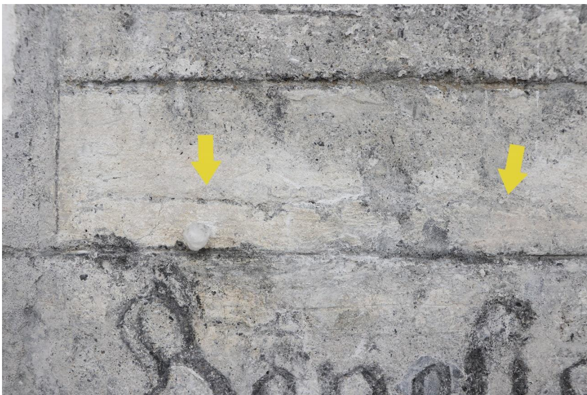
Obr. 26. Fragment levé horní části nápisu výjevu č. 32, stav v proběhu injektáže. Na fotografii je dobře vidět rozhraní denního dílu mezi výjevy. Z fotografie vyplývá, že sgrafitové díly byly nanášeny směrem shora dolů.
