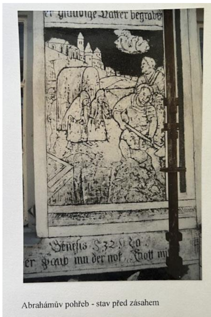
Obr. 12 Fotografie výjevu "Abrahámův pohřeb" č. 25 před provedením restaurátorských prací v letech 1998–1999. Zdroj restaurátorská dokumentace.
