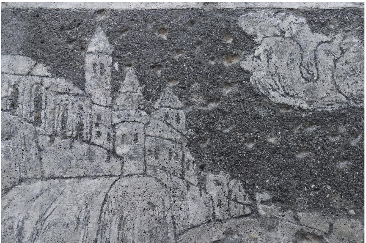
Obr. 51. Stav po odstranění nevhodných tmelů.
