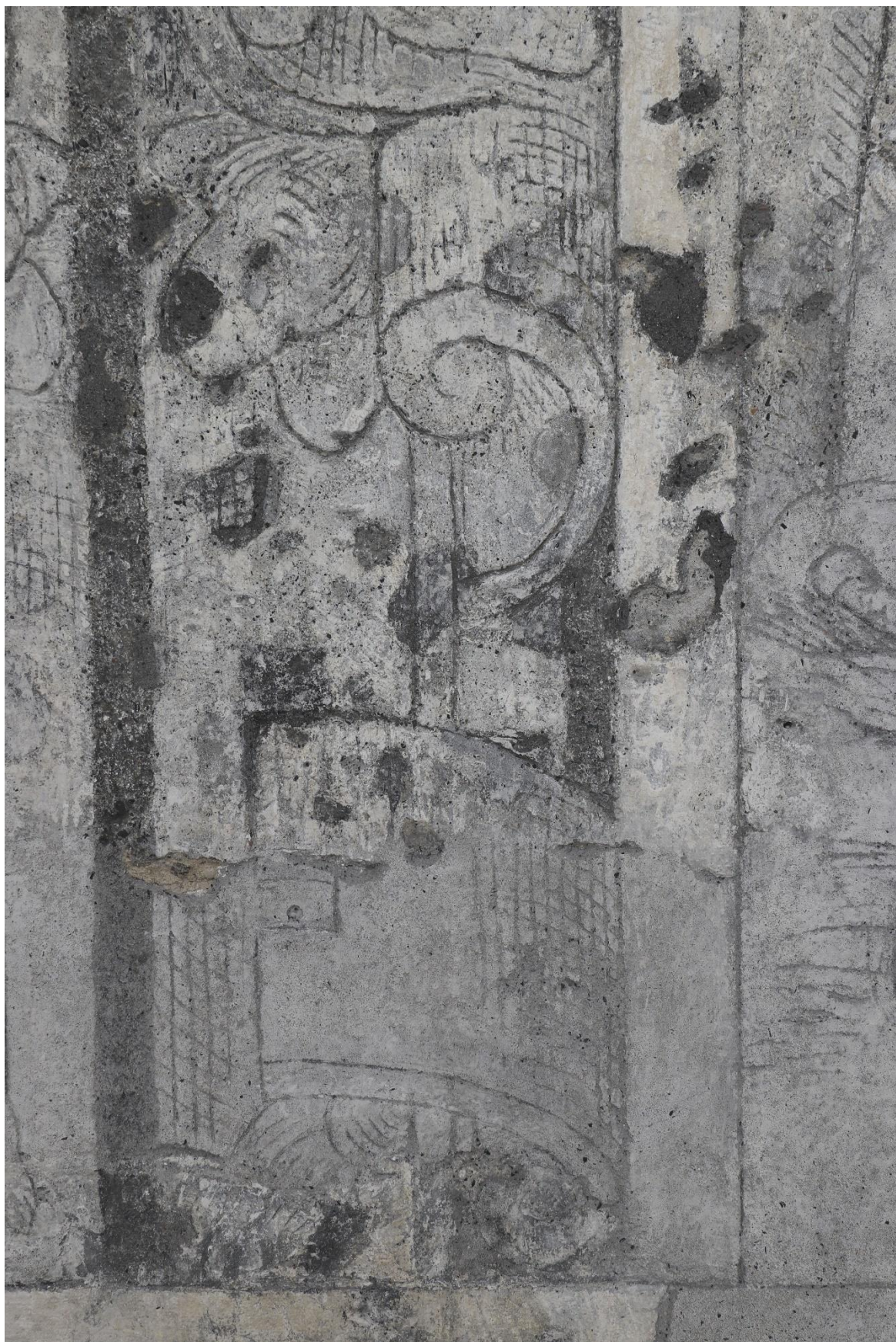
Obr. 41. Detail spodní části rolverkového ornamentu scény z levé strany č. 32, stav po odstranění nevhodných druhotných tmelu.
