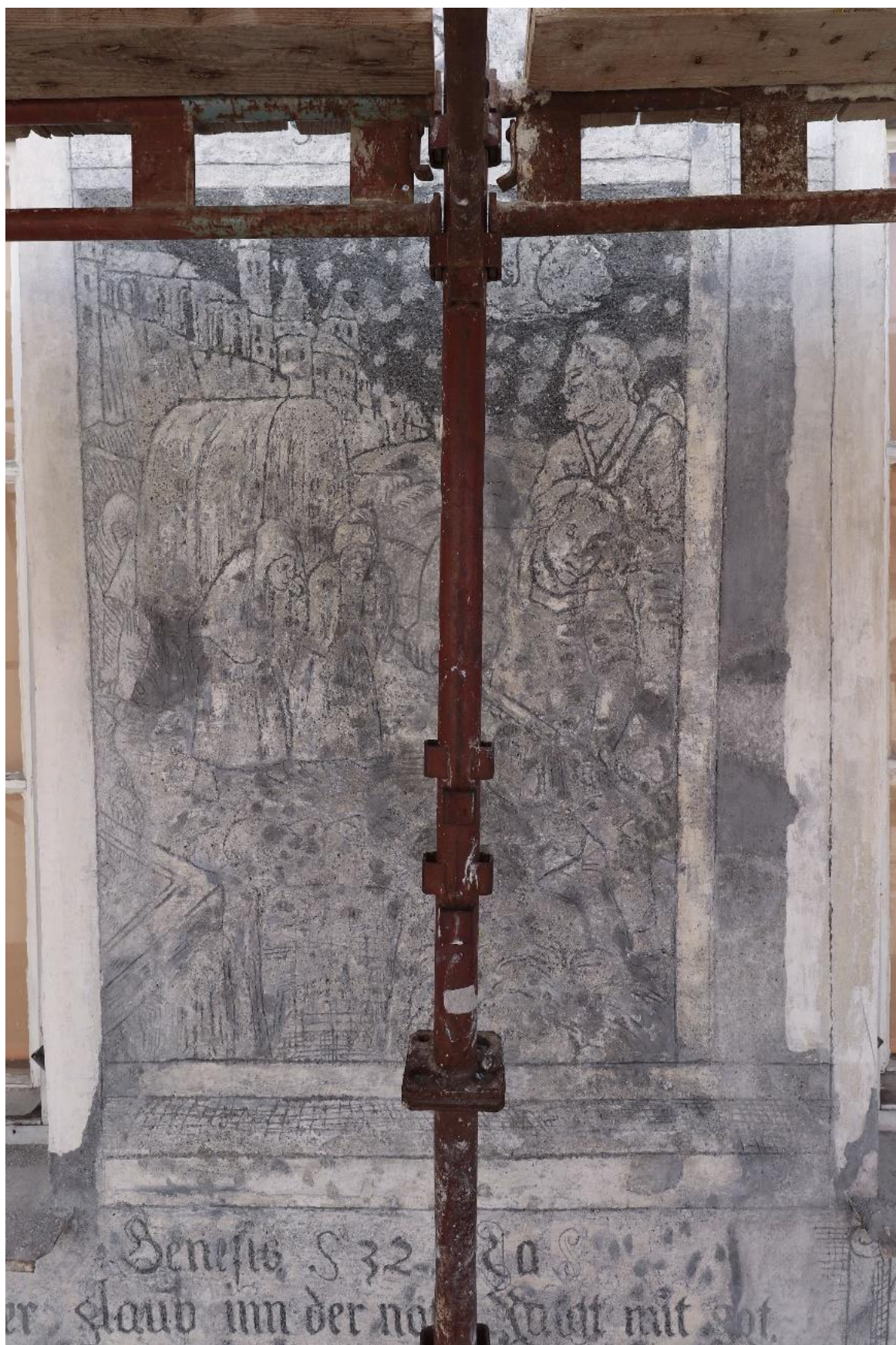
Obr. 69. Stav po vytmelení a úpravě povrchu nových tmelů.
