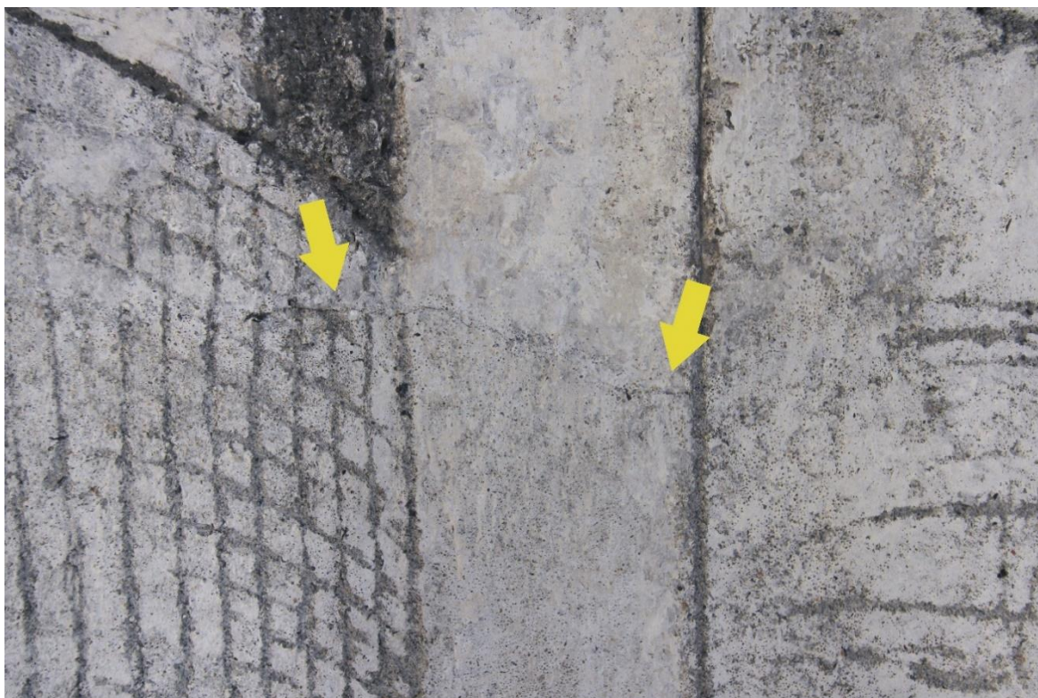
Obr. 29. Detail spodní části rolverkového ornamentu scény z levé strany č. 32, stav před restaurováním. Na fotografii je možné si všimnout praskliny na rozhraní druhotného tmelu a originálu.
