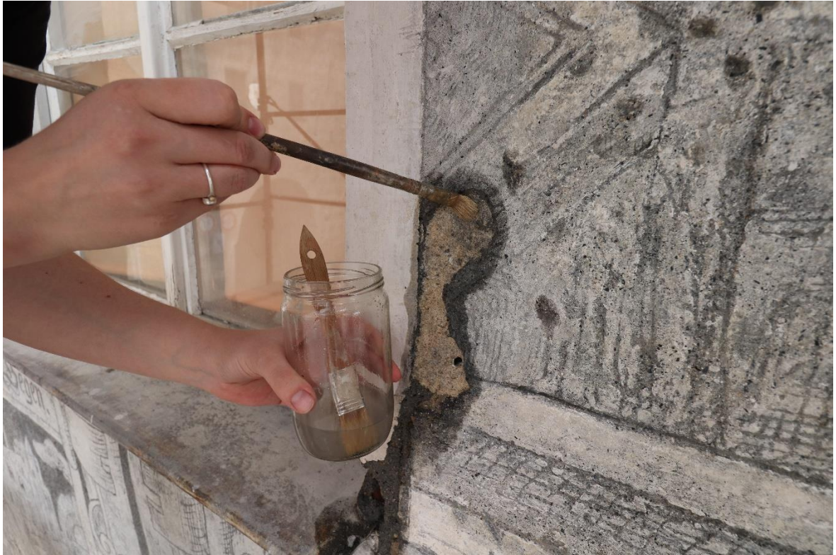
Obr. 42. Fragment dolní části výjevu č. 25. Pracovní fotografie provedení strukturální konsolidace odhalených defektů organokřemičitanem a následně vápennou nanosuspenzí.
