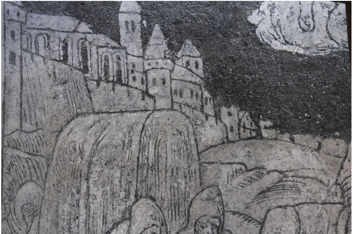
Obr. 50. Stav před restaurováním.
