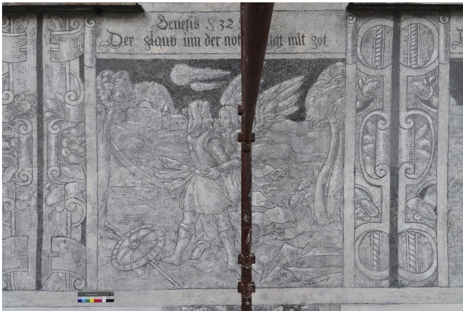
Obr. 74. Stav po restaurování.
