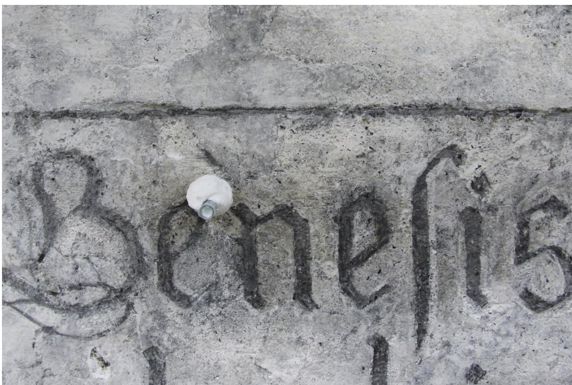
Obr. 37. Detail doprovodného citátu výjevu č. 25, stav v průběhu injektáže.
