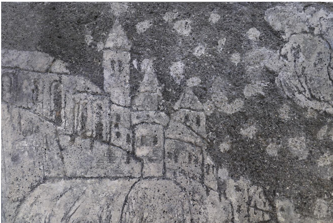
Obr. 52. Stav po vytmelení a úpravě povrchu nových tmelů.
