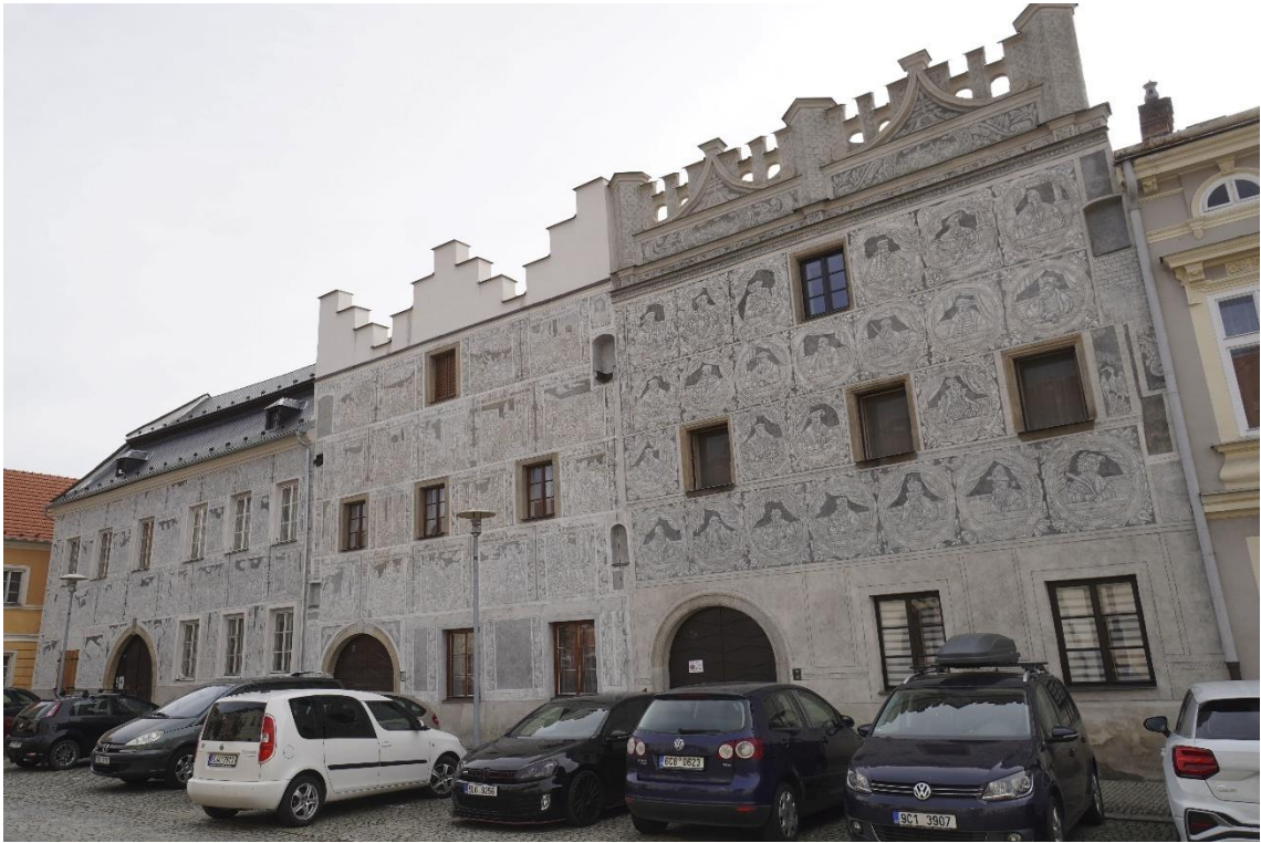
Obr. 19. Celkový pohled na fasádu bývalého pivovaru č.p. 538 a vedle stojící domy č.p. 537, č.p. 536. Stav po restaurování roku 2023. Autor fotografie: Jana Waisserová
