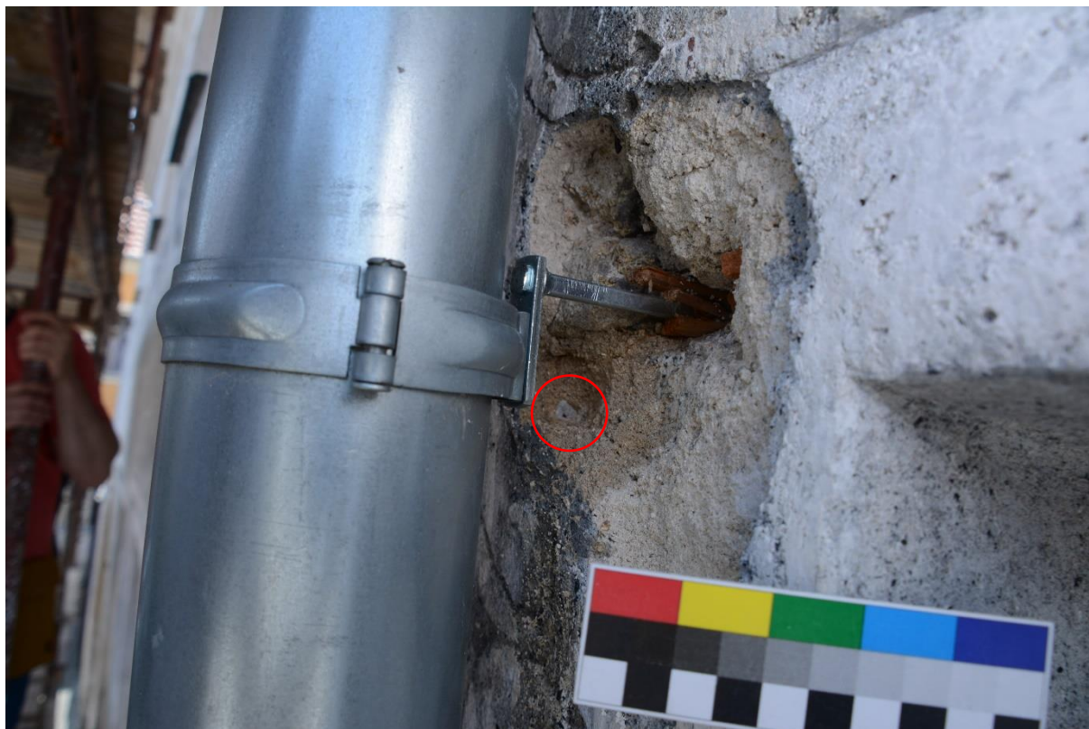
Umístění vzorku SPIV 3 v jádrové omítce (DSC_6105)
