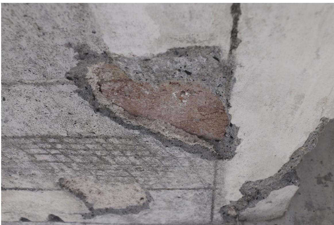
Obr. 27. Detail pravého dolního rohu výjevu č. 25, stav v průběhu odstraňování druhotných tmelu. Na fotografii odhaleného defektu v oblasti rekonstrukce je dobře vidět vrstvení sgrafita: na cihlové zdivo byla nanášena jádrová vrstva, na kterou byla následně aplikována probarvená vrstva a poté byl nanesen bílý nátěr.
