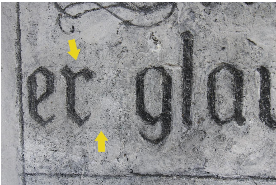
Obr. 24. Detail levé části nápisu výjevu č. 25, stav před restaurováním. Na fotografii jsou zobrazeny pomocné linie, které se používaly k udržení výšky přenášených písmen. Znečištění ptačím trusem (oblast nad písmenem „g“)
