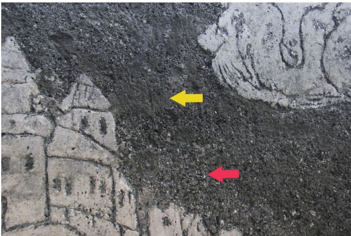
Obr. 34. Detail pozadí výjevu č. 25, stav před restaurováním. Na fotografii je dobře viditelný rozdíl ve struktuře sekundárních doplňků a originální omítky. Žlutá šipka – druhotný tmel, červená šipka – originální omítka
