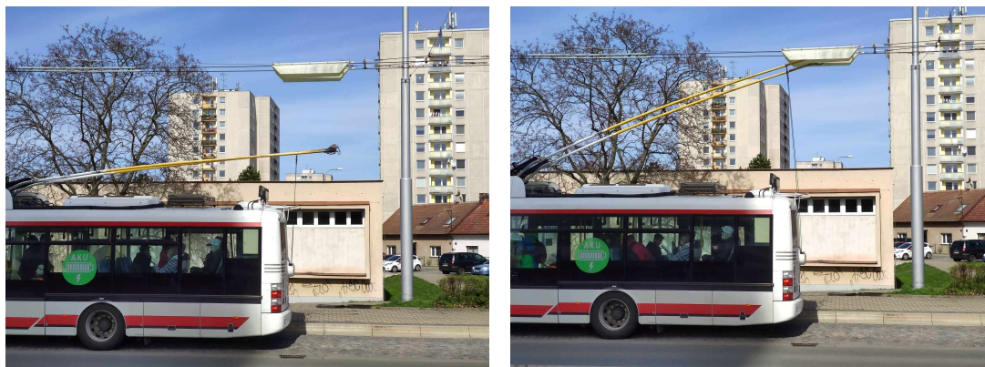
Obr. 2 Zdvžení sběrače trolejbusu a navedení pomocí stříšek (foto autor)
