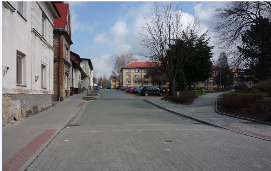
Obr. č. 8 Místní komunikace ve výborném stavebně-technickém stavu (MK Šafaříkova)
