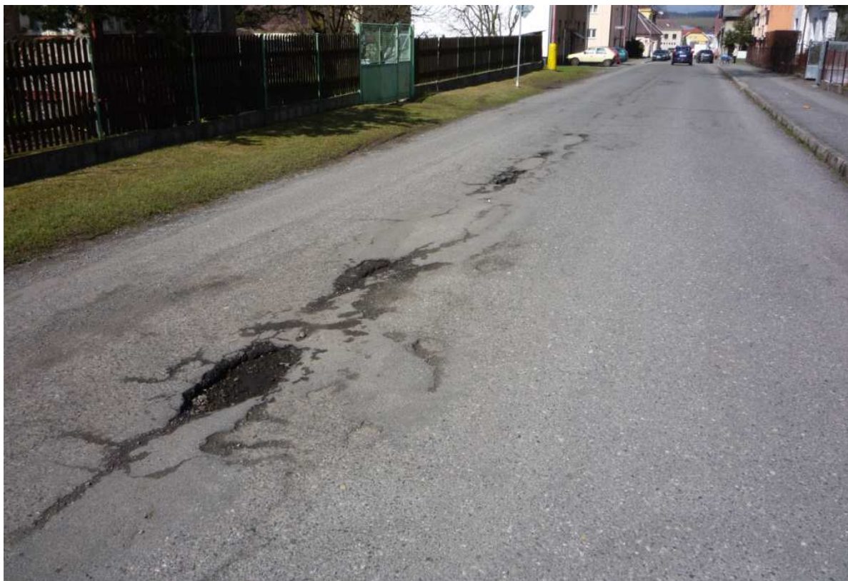
Obr. č. 10 Místní komunikace ve vyhovujícím stavebně-technickém stavu (MK Taussigova)
