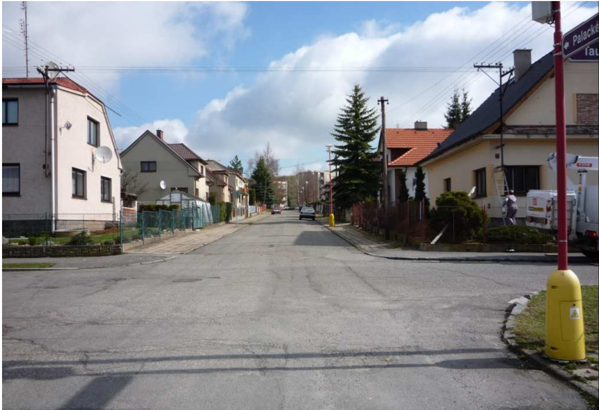
Obr. č. 9 Místní komunikace v dobrém stavebně-technickém stavu (MK Palackého)
