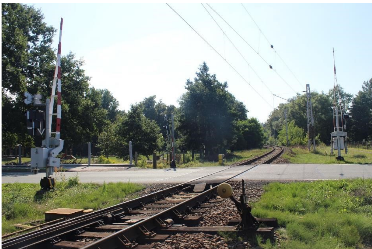
Fotografie 8: Přejezd P4876. Na fotografii je zachycen železniční přejezd v ulici Husova, stávající přilehlý směrový oblouk a městský park s dětským hřištěm ve vnitřní straně oblouku. Fotografie je pořízena proti směru staničení.
