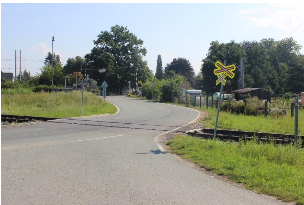
Fotografie 10: Přejezdy v ulici Husova. Na fotografii se nachází přejezd P5079 na holické trati zabezpečený pouze výstražnými kříži a přejezd P4876 zabezpečený světelnou signalizací se závorami.
