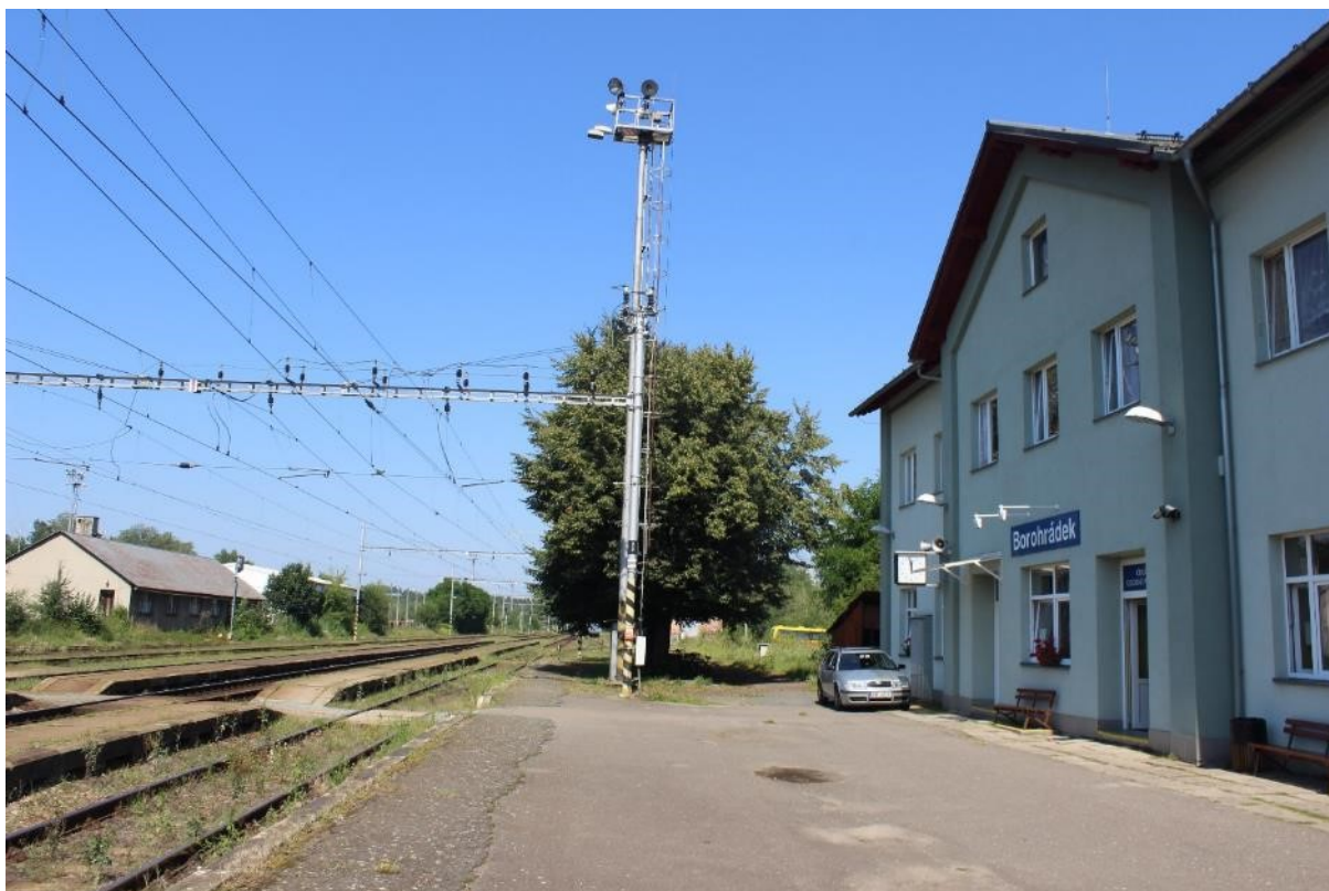
Fotografie 17: Prostor před výpravní budovou. Pohled ve směru staničení.
