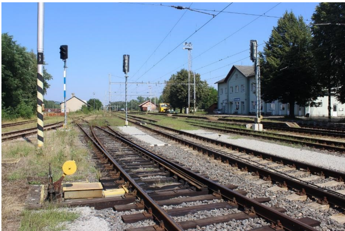
Fotografie 15: Prostor před výpravní budovou. V prostoru před výpravní budovou se nachází 4 úrovňová nástupiště. V levé části fotografie je vidět kolejová křižovatka vleček. V přední části fotografie je stávající výhybka č. 8.
