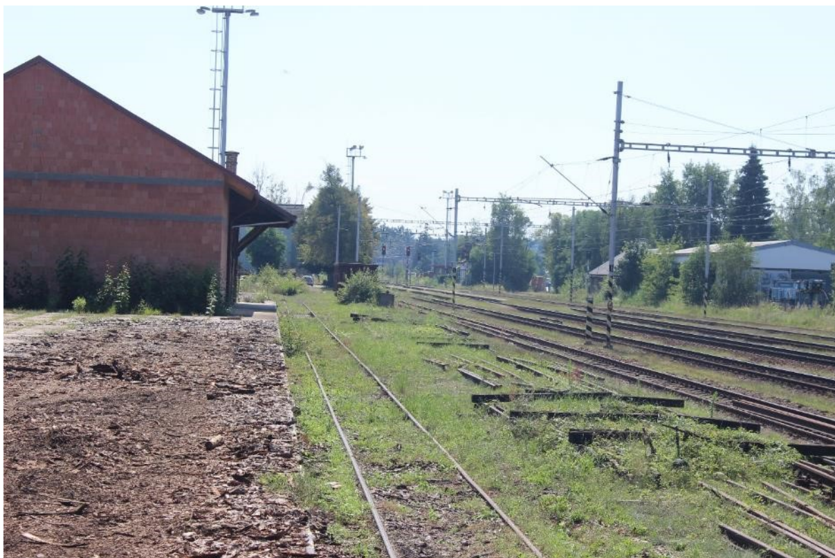
Fotografie 21: Boční rampa. Boční rampa využívaná pro nakládku dřeva. Dále je zachycen sklad. Pohled je proti směru staničení.
