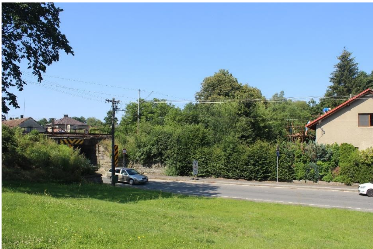
Fotografie 3: Rodinný dům s č. p. 248. Fotografie zachycuje polohu rodinného domu s číslem popisným 248 vůči železniční trati 026.
