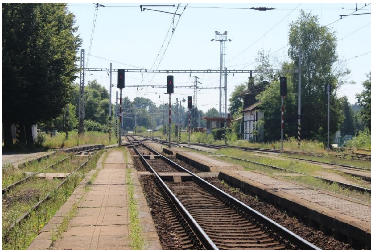
Fotografie 18: Úrovňová nástupiště. Na fotografii také zachyceno choceňské zhlaví a odjezdová návěstidla ze stávající žst. Borohrádek.
