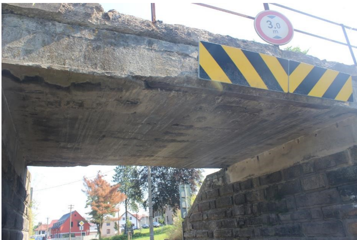
Fotografie 6: Stav nosné konstrukce mostu k 7.8.2020. Maximální povolená výška dopravním značením vozidla projíždějícího pod mostním objektem je 3,0 m.
