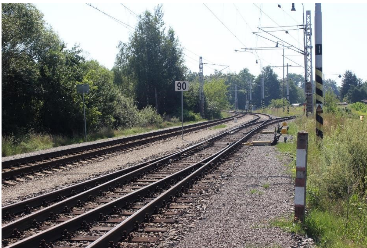
Fotografie 14: Zapojení holické trati ke stanici. Trať z Holic a Moravan je ke stanici zapojena výhybkou č. 2.
