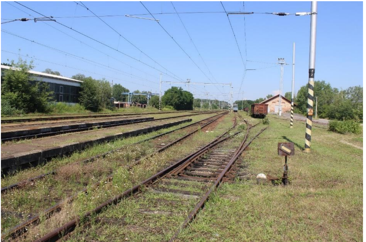
Fotografie 19: Výhybka č. 11. Na fotografii je zachycena výhybka č. 11 a odstavený nákladní vůz na koleji č. 4a.
