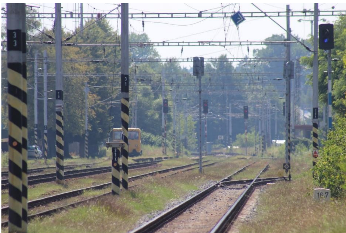
Fotografie 22: Výhybka č. 19. Pohled proti směru staničení na vzdálenou výhybku č. 19 v liché skupině kolejí.
