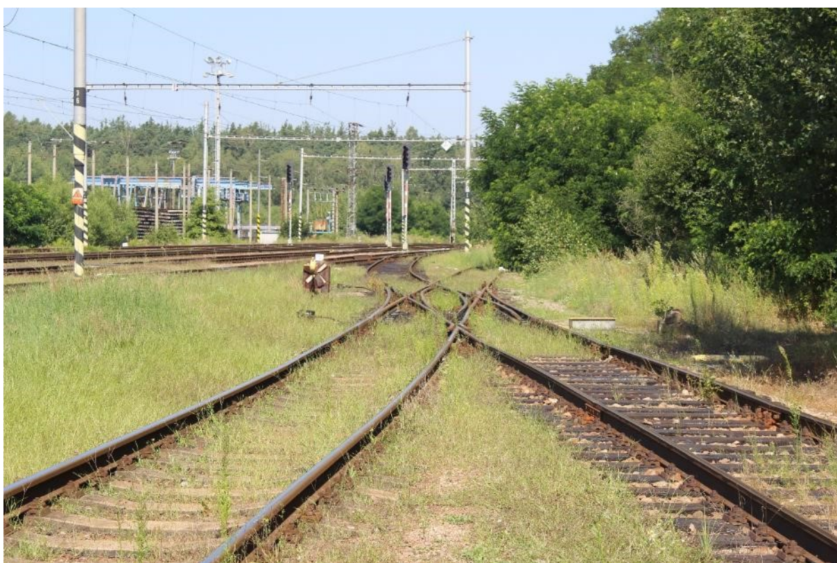
Fotografie 24: Křižovatková výhybka. Křižovatkovou výhybkou jsou do stanice zaústěny dvě vlečkové koleje. Zarůstající vlečka vzdalující se ze středu fotografie patří Wotan Forest, a.s.
