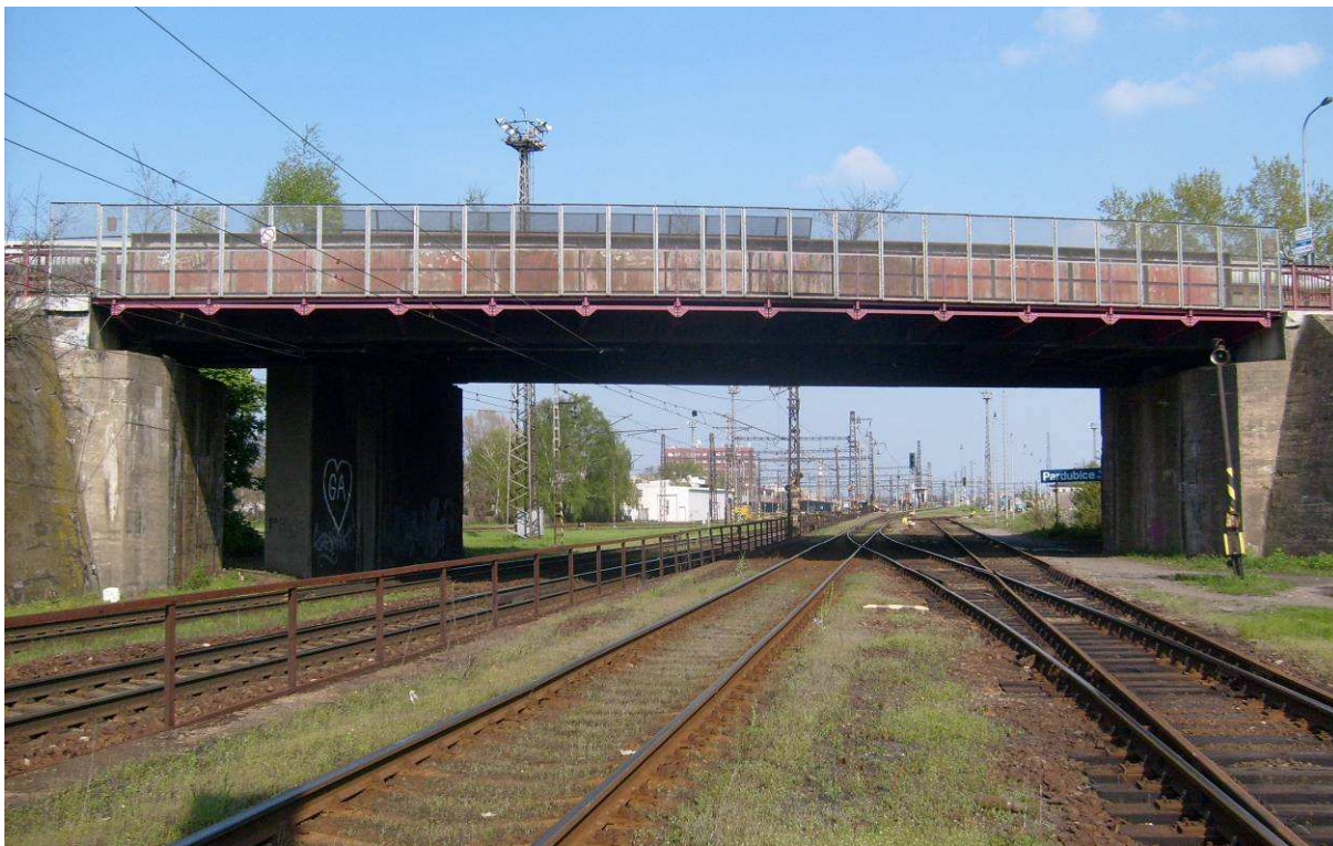
Obrázek 2- Čelní pohled na most
