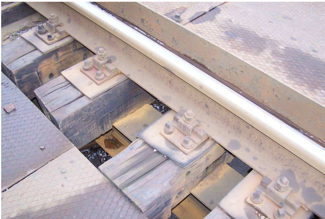
Obrázek 9 - Upevnění kolejnice na mostnice 1
