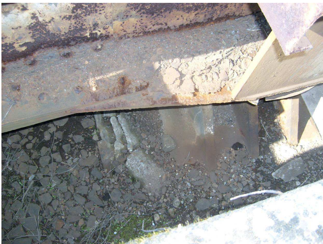
Obrázek 15 - Pevné ložisko
