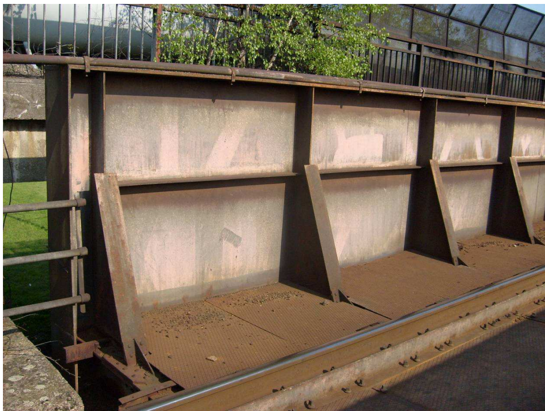
Obrázek 6 - Ztužení hlavního nosníku
