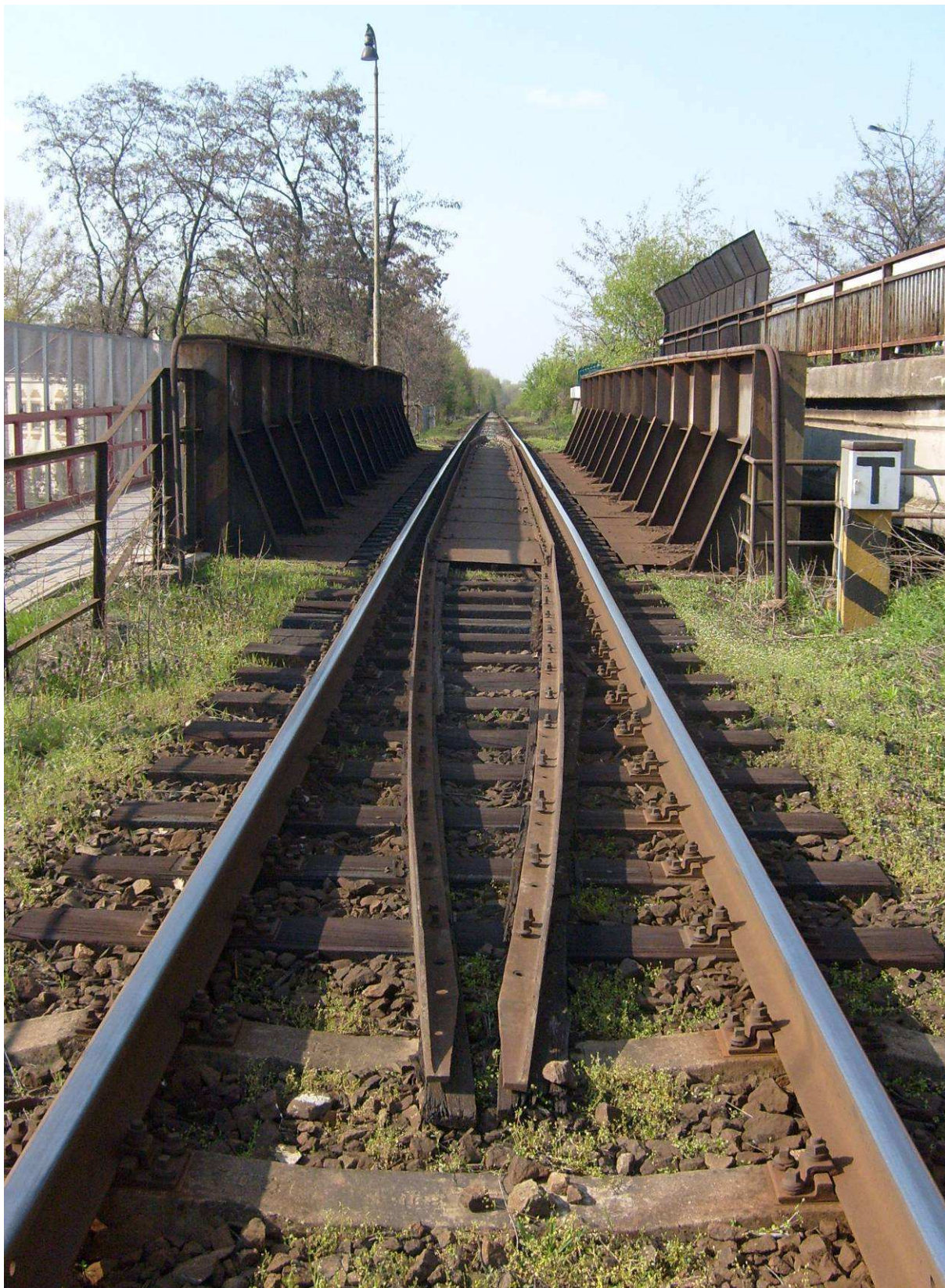
Obrázek 4 - Pohled na most směr Rosice nad Labem
