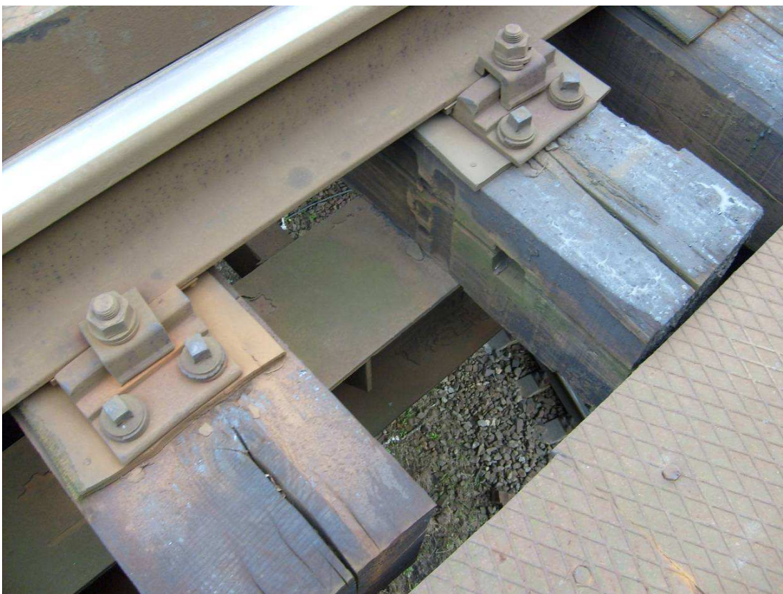
Obrázek 10 - Upevnění kolejnice na mostnice 2
