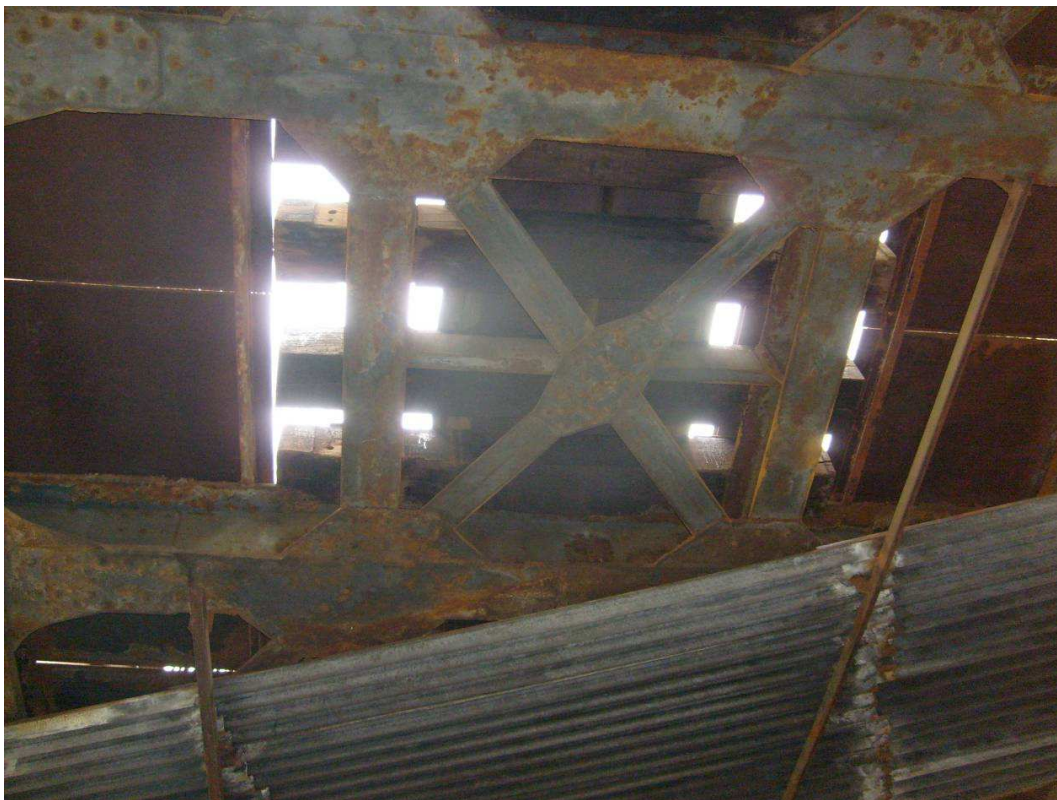
Obrázek 12 - Detail zavětrování
