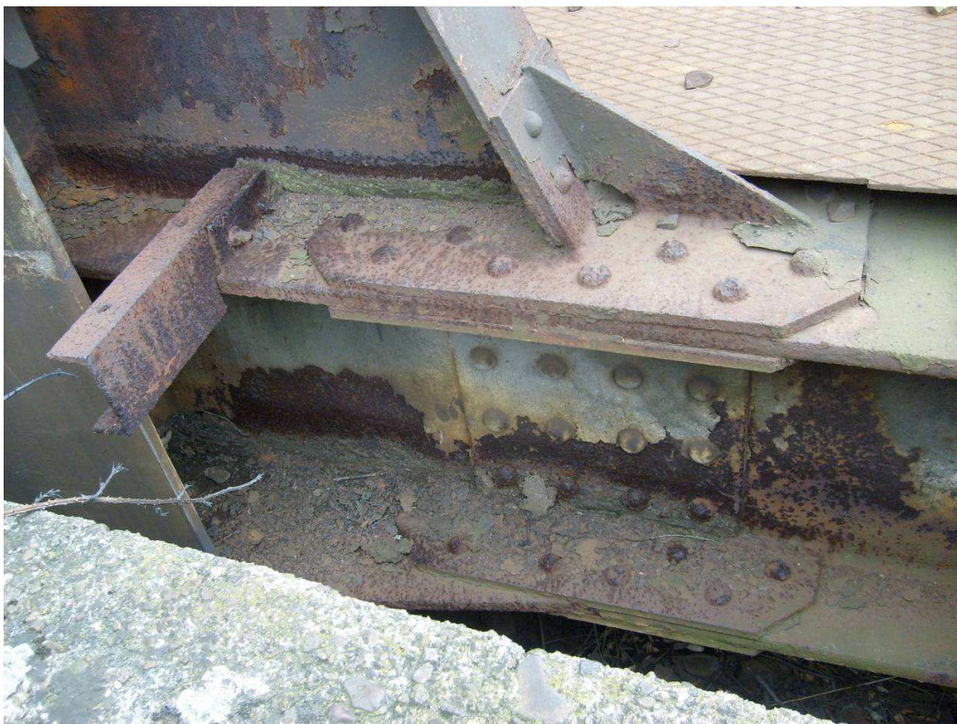
Obrázek 13 - Připojení příčníku na hlavní nosník
