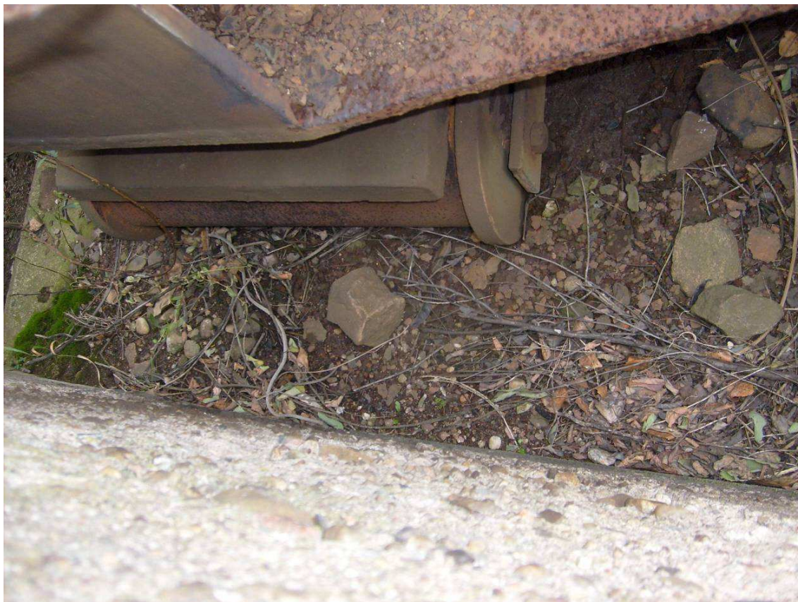
Obrázek 14 - Pohyblivé ložisko
