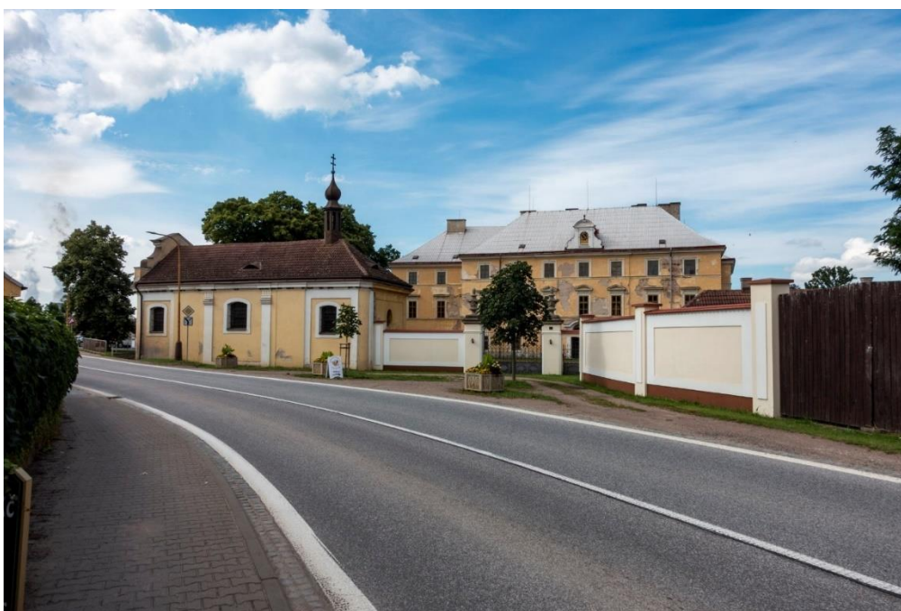
Obr. 72 celkový pohled na areál zámku, v přední části vlevo barokní kaple umístěna v jihozápadní části čestného dvora 15.7. 2021 (foto Petr Růžička- mapy.cz)
