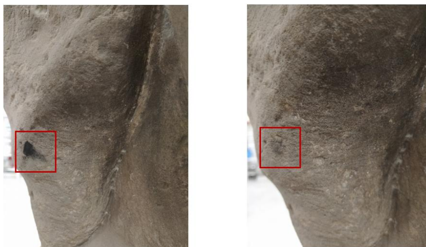
Obr. 15 fotografie před čištěním a po očištění sazové skvrny
