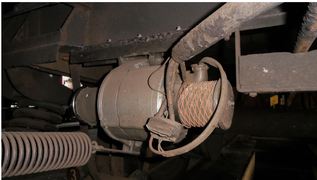
Obrázek 14 - Zavěšení alternátoru pod vozem č. Clm5-2345. Fotografie: autor práce
