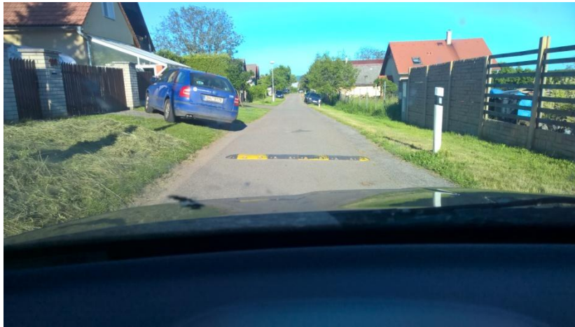
Obrázek 2 Samostatný zpomalovací práh z plastových dílů v obytné zóně v obci Jeníkovice
