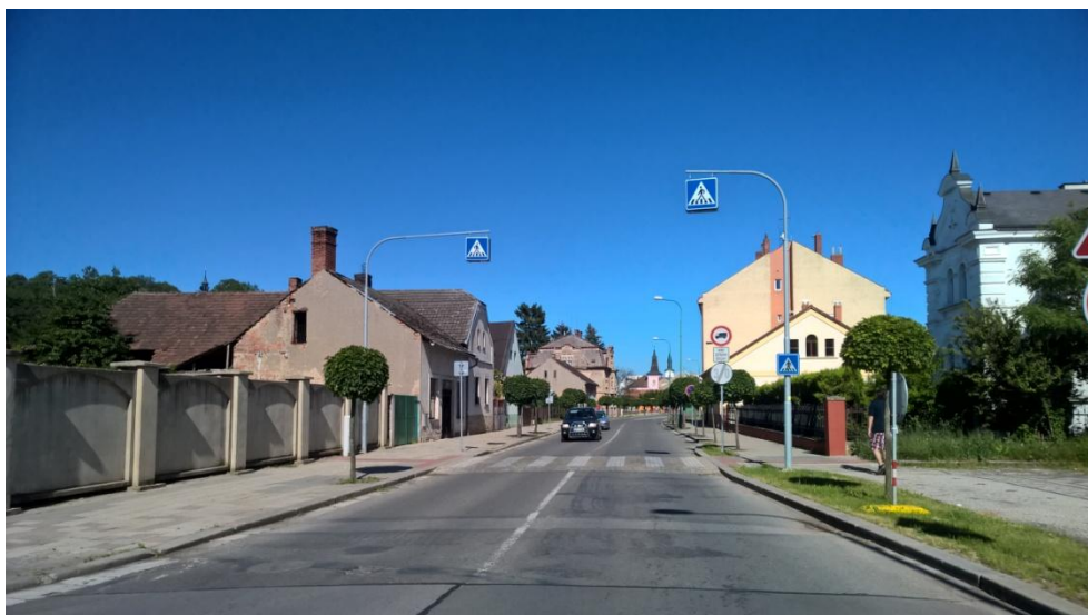
Obrázek 3 Zpomalovací práh s přechodem pro chodce, ze žulových kostek v Třebchovicích pod Orebem
