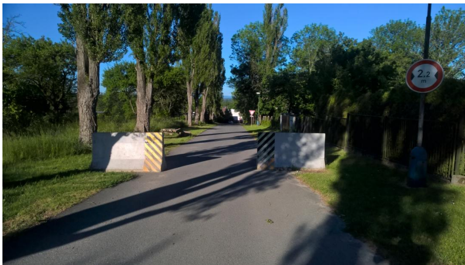
Obrázek 8 komunikace zúžená betonovými bloky v Třebechovicích pod Orebem
