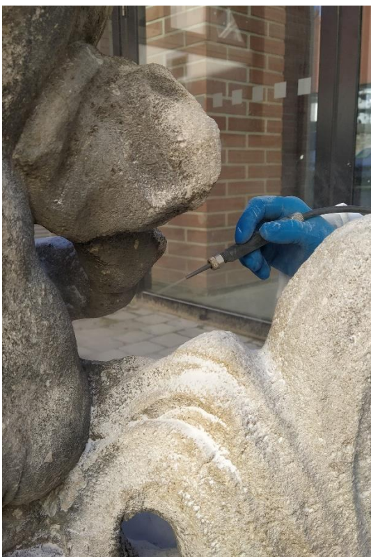
Obrázek 75 Čištění díla metodou mikropískování
