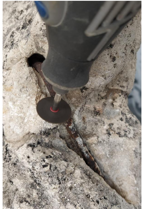
Obrázek 78 Odstraňování železné armatury v části draperie
