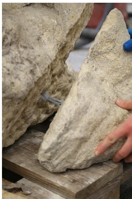
Obrázek 88 Lepení části nohy na čep
