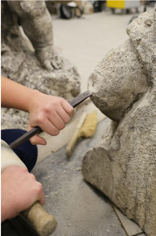
Obrázek 77 Odstraňování nevyhovujících tmelů, pomocí kamenického nářadí
