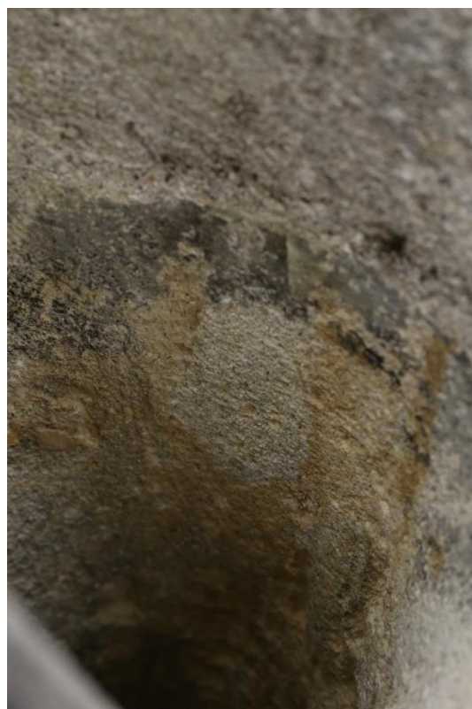
Obrázek 86 Zkouška odstranění rzi z povrchu kamene
