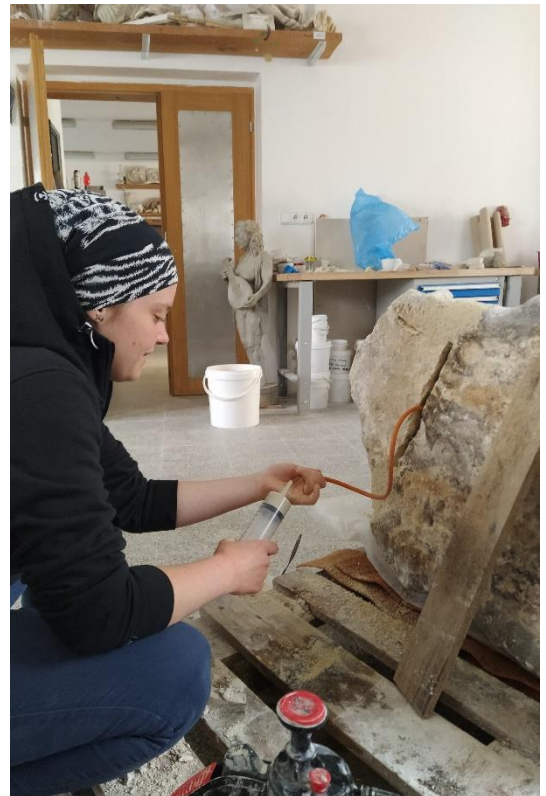
Obrázek 90 Položené dílo na bok a vyplnění spáry tmelem
