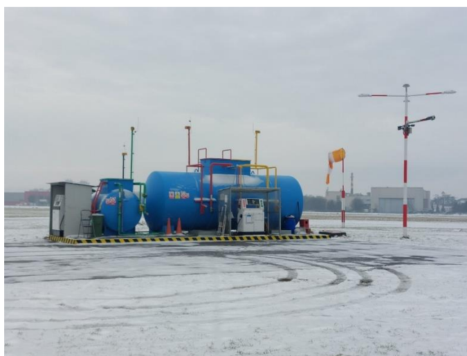
Obrázek 6: Čerpací stanice LKLT
