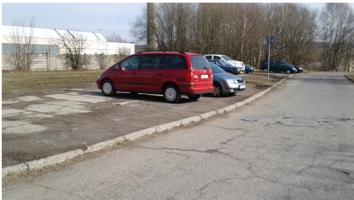
Obrázek 16 – Pohled na stávající stav, začátek propojovací komunikace
