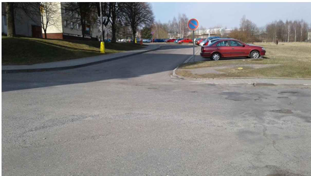
Obrázek 7 – pohled na stávající komunikaci, částečné rušení a uzavření
