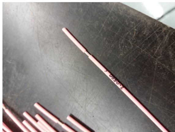
Zdroj: Autorka Obrázek č. 4 – označení kabelů
