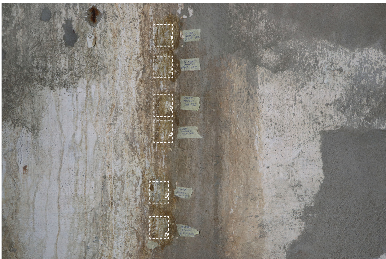
Obr. 45: Zkouška čištění stěny pomocí latexové houby. Severovýchodní stěna skladu munice v 1. podzemním podlaží. 1) Akapad hard a 2) Akapad flexible.
