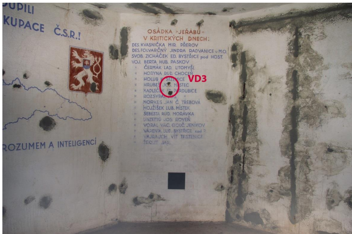
Obr. 32 Místo odběru vzorku VD3 v místnosti s nástěnnou malbou ve vojenské pevnosti Dobrošov u Náchoda, bunkr „Jeřáb“.
