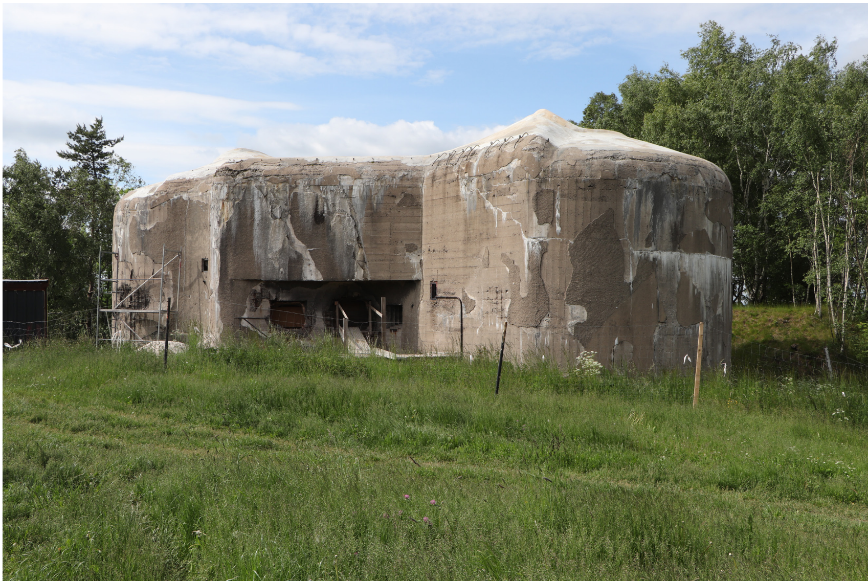
Obr. 01: Pohled z jihovýchodu na nadzemní exteriérovou část pěchotního srubu N-S 73 Jeřáb.
