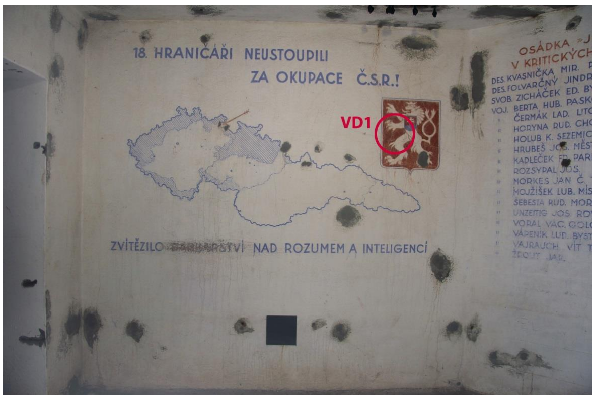
Obr. 28 Místo odběru vzorku VD1 v místnosti s nástěnnou malbou ve vojenské pevnosti Dobrošov u Náchoda, bunkr „Jeřáb“.
