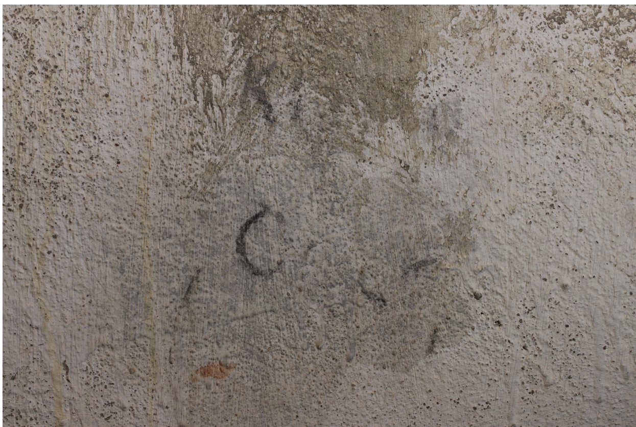
Obr. 24: Detail krasového jevu v pravém horním rohu výjevu s mapou Československa. Jihovýchodní stěna ve skladu munice v 1. podzemním podlaží. Stav před restaurováním.
