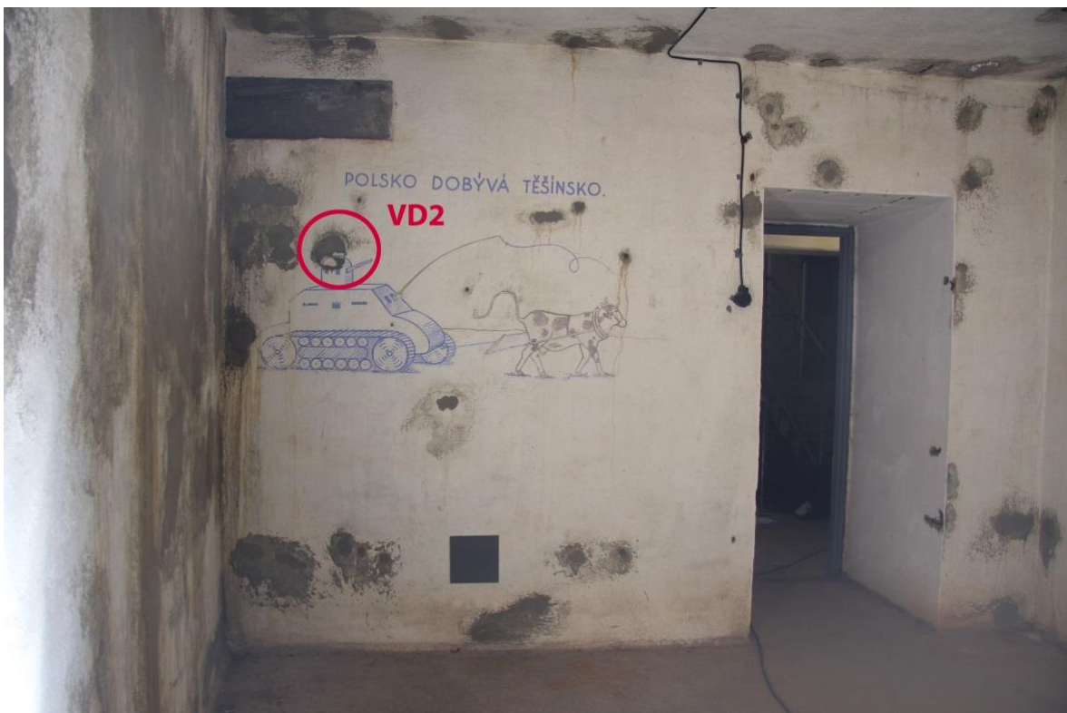
Obr. 30 Místo odběru vzorku VD2 v místnosti s nástěnnou malbou ve vojenské pevnosti Dobrošov u Náchoda, bunkr „Jeřáb“.
