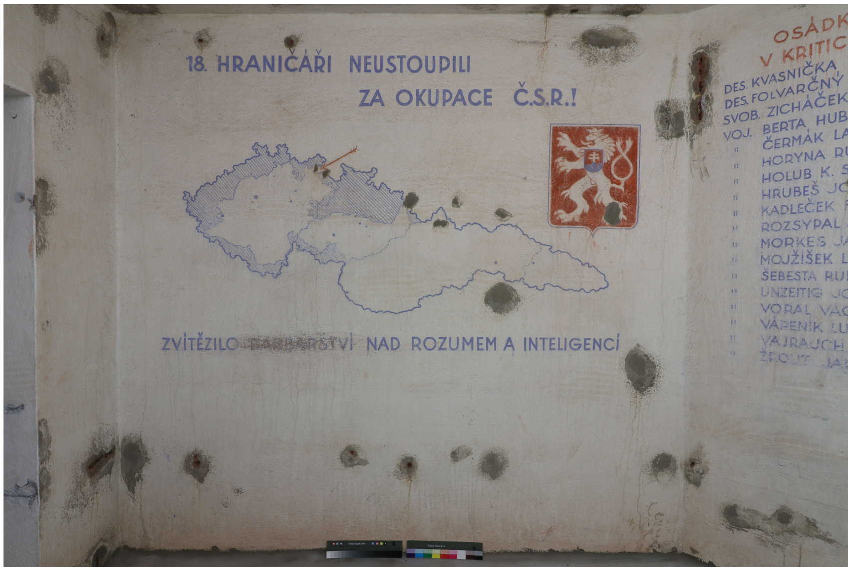
Obr. 06: Sklad munice v 1. podzemní podlaží: celkový pohled na jihovýchodní stěnu, výjev s mapou. Stav před restaurováním.
