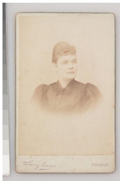
Obr. 53 Stav po restaurování – líc, př. č. 5986
