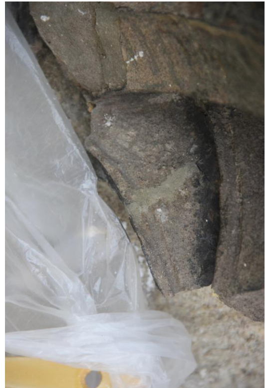
Obr. č.89 – Zajišťující tmelení
