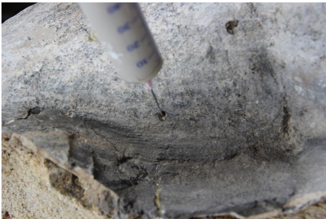
Obr. č. 85 - Injektáž dutin
