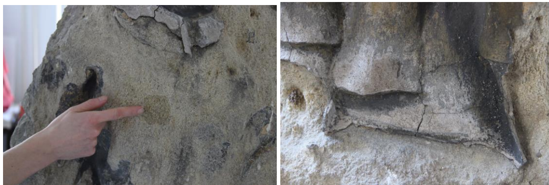
Obr. č. 56;57 - Ilustr. místa měření nasákavosti
