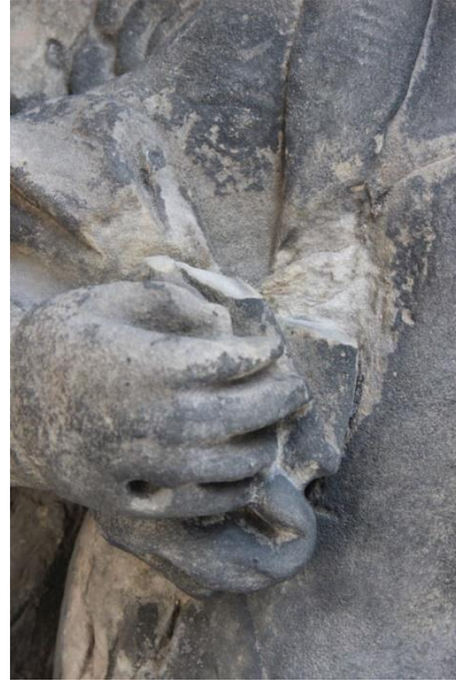
Obr. č. 30 - Stav po odstranění starších vysprávek - detail ruky
