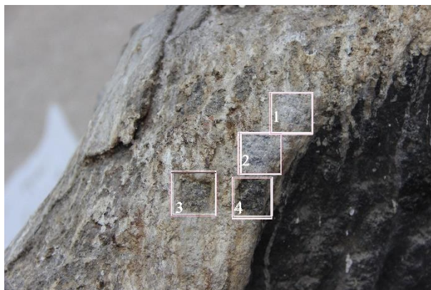
Obr. č.63 - Ilustr. Zkoušky čištění
