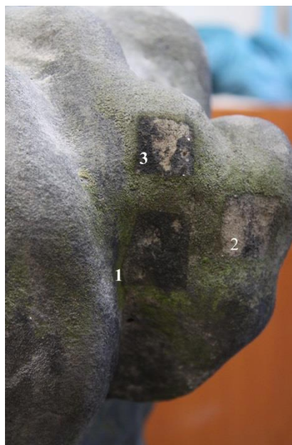
Obr. č. 19 - Ilustr. zkoušky čištění
