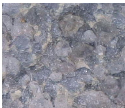
P6 – Čištění kombinované - zkouška
