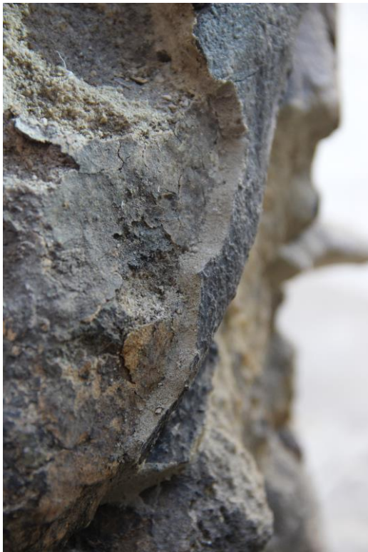
Obr. č. 88 – Zajišťující tmelení
