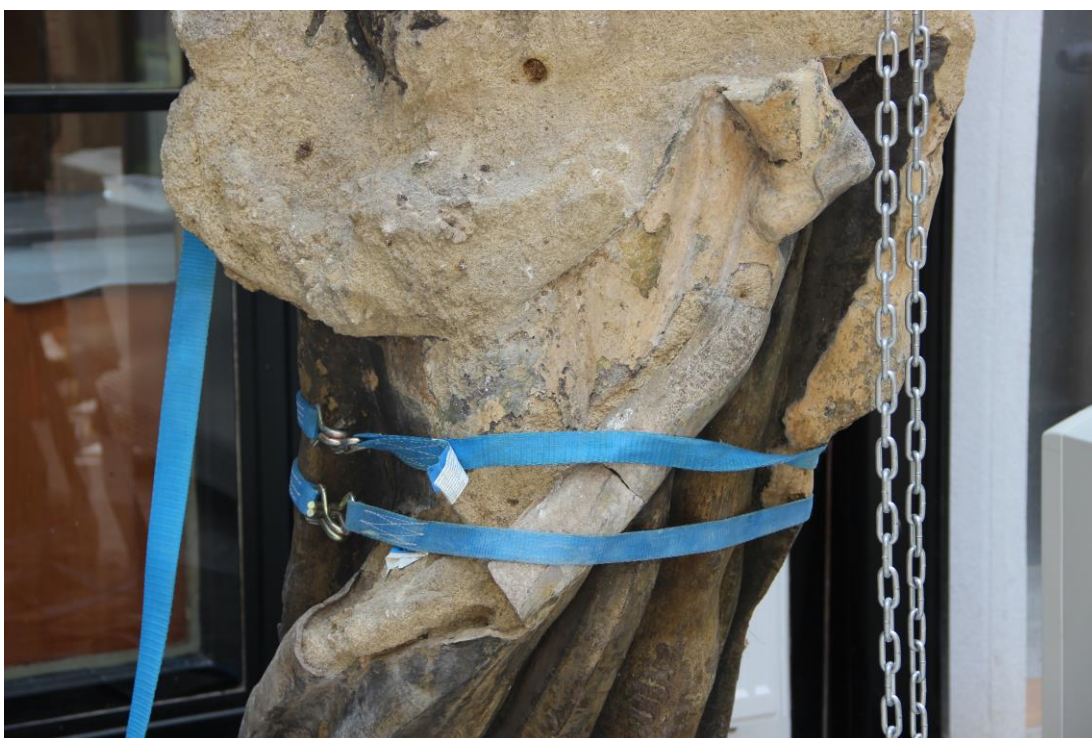
Obr. č. 83 – Lepení odpadlých fragmentů
