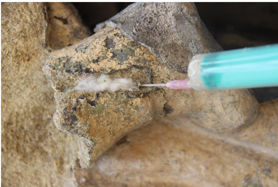
Obr. č. 84 - Injektáž prasklin
