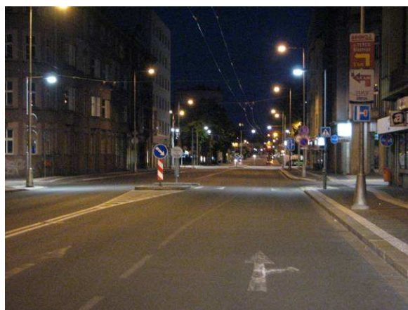
Střední dělicí ostrůvky na křižovatkách Gočárovy třídy s ulicemi K. H. Máchy a Šafaříkova (noční pohled – patrné přisvětlení přechodu pro chodce odlišnou barvou světla)
