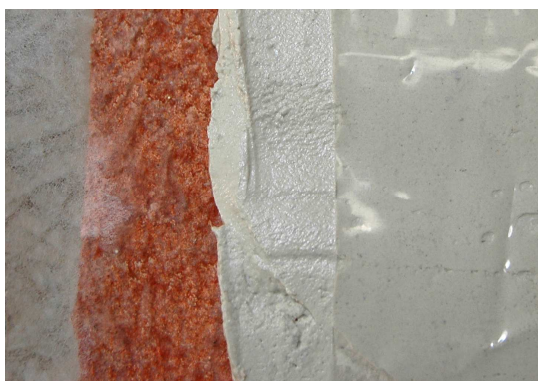
Obr.18 Postup při aplikaci obkladu buničiny / kaolínu
