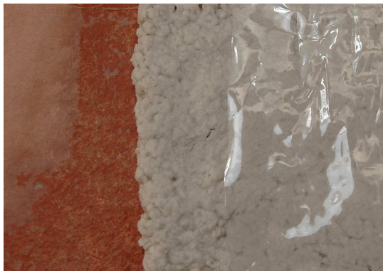
Obr.17 Postup při aplikaci obkladu buničiny (Arbocel) na omítku
