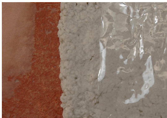
Obr.21 Postup při aplikaci obkladu buničiny (Arbocel)
