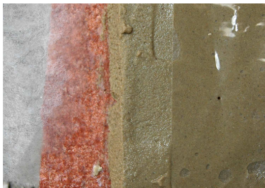
Obr.19 Postup při aplikaci obkladu Funcosil Entsalzungskomprese
