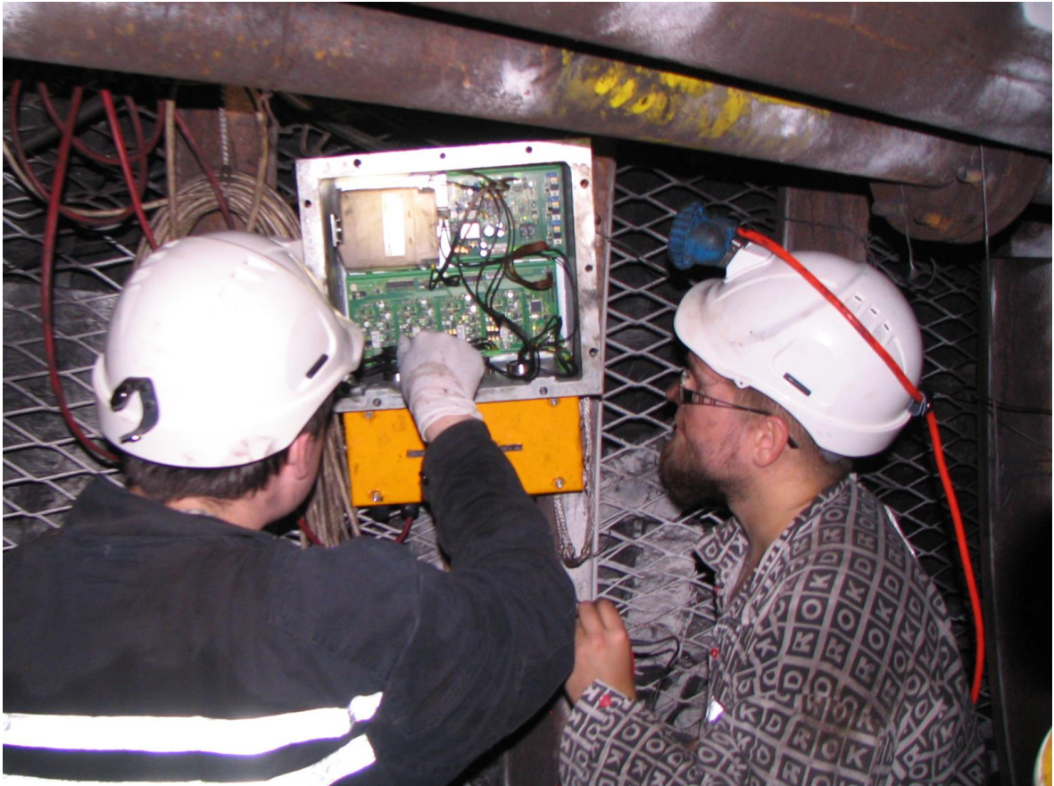
Obr. 15 Datový koncentrátor systému ISI navržený a montovaný autorem disertace (zdroj autor)
