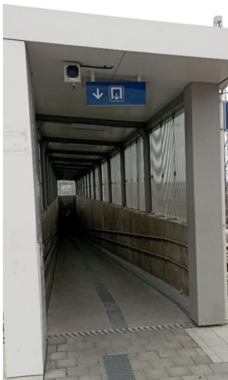
Obrázek 16 Podchod ve stanici Šakvice
