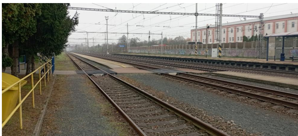
Obrázek 10 Úroňový přístup k prvním dvěma nástupištím ve stanici Modřice
