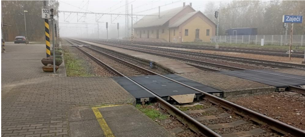
Obrázek 17 Úrovňový přístup k prvnímu nástupišti ve stanici Zaječí
