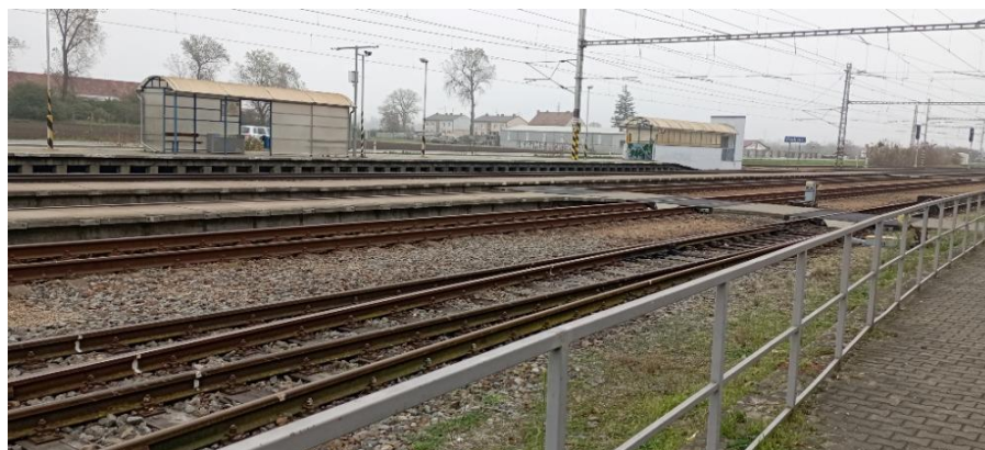
Obrázek 20 Úrovnový přístup k prvním a druhým nástupištím ve stanici Podivín
