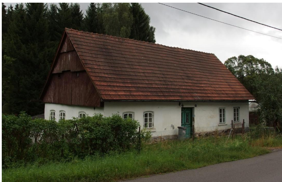
Příloha č. 15 Chalupnická usedlost čp. 41 (foto archiv autorky, stav srpen 2016)
