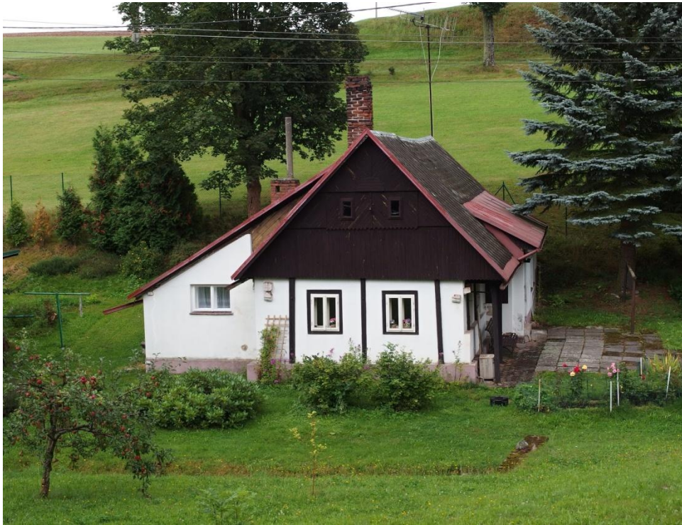
Příloha č. 16 Původně domkářské stavení čp. 99 (foto archiv autorky, stav srpen 2016)
