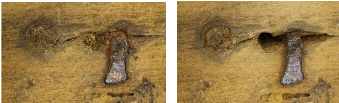
Obrázek 104 Čištění kovových prvků – vlevo stav před zásahem, vpravo po zásahu (detail)
