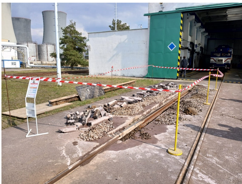
Obrázek 6 Průběh opravy lomu kolejnice před remízou lokomotiv (Autor, 2025)
