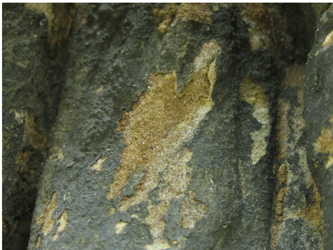
Obr.53- odlupující se vrchní vrstva kamene
