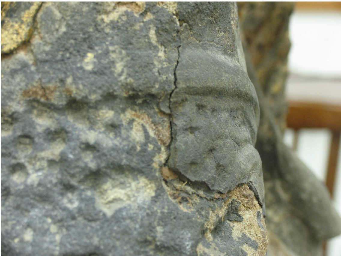
Obr.61 - praskliny kolem star. tmelů
