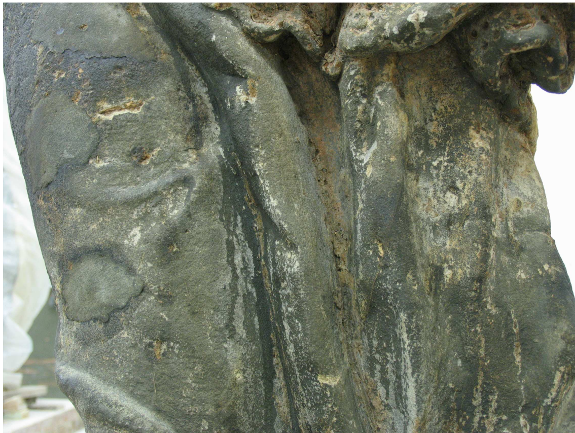
Obr.17 - Zkouška čištění většího povrchu mikropískov., stav před čištěním
