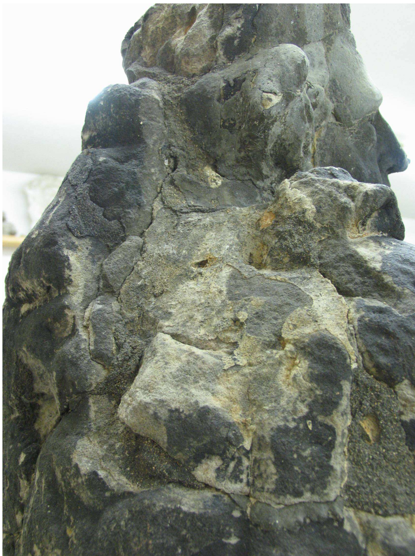
Obr.53- odlupující se vrchní vrstva kamene
