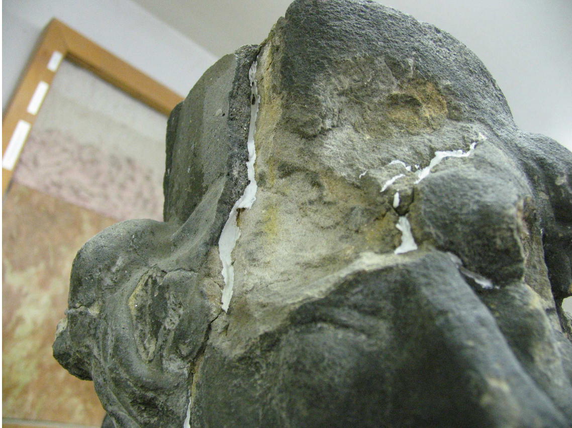
Obr.66 - injektování prasklin
