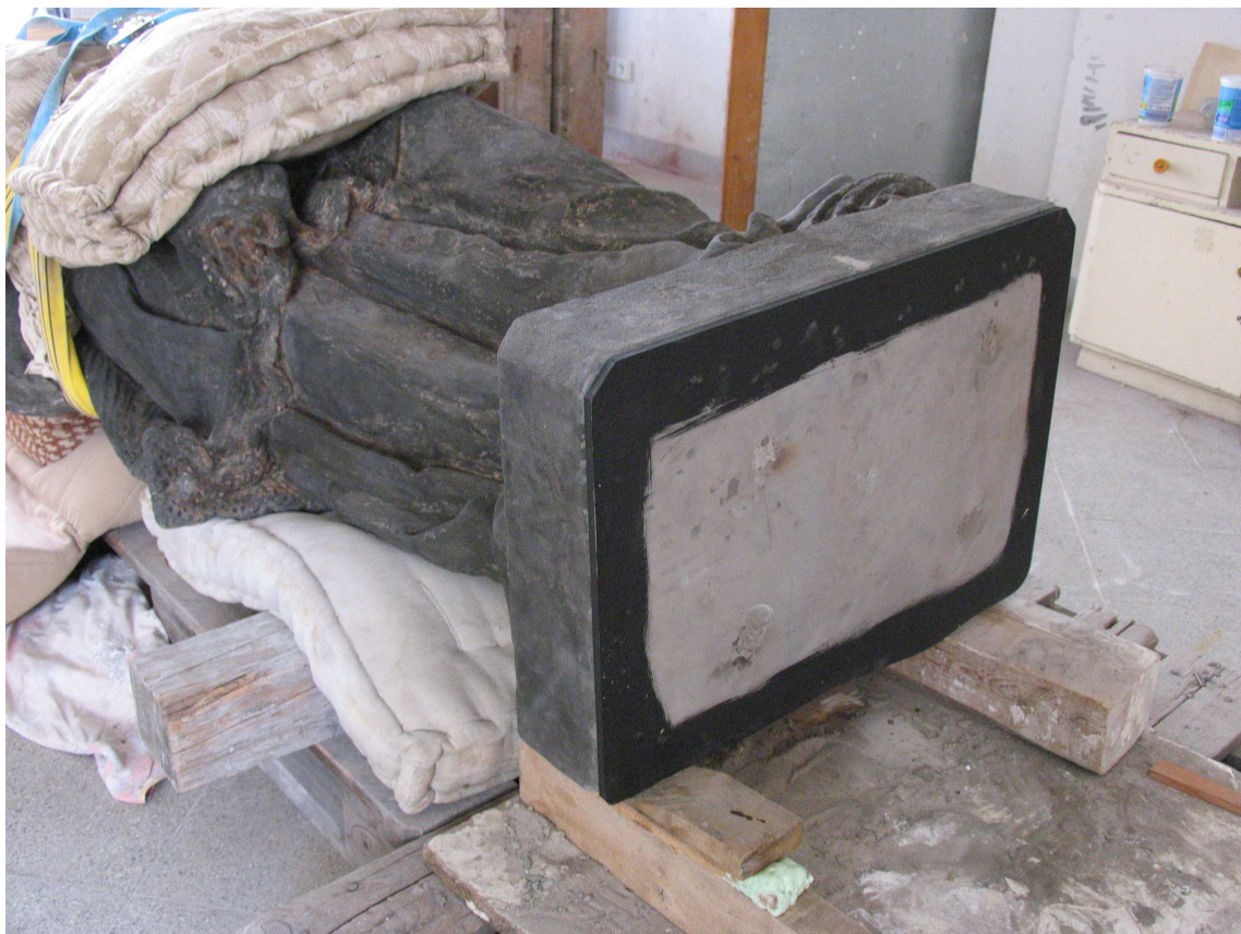
Obr.83 - osazení nerez. desky
